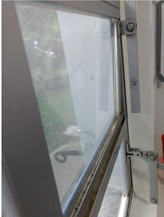
**Figura 13:** Vidros soltos da sala de vacina. (Fonte: Dos Autores 2018)
