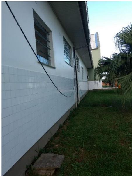
**Figura 16:** Fio no lado externo da unidade. (Fonte: Dos Autores 2018)
