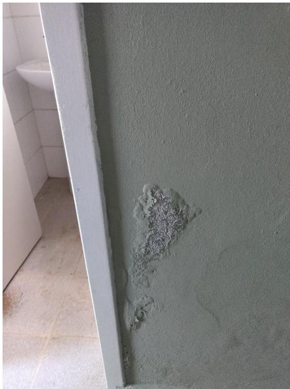
**Figura 12:** Problemas de infiltração na caixa d'água. (Fonte: Dos Autores 2018)
