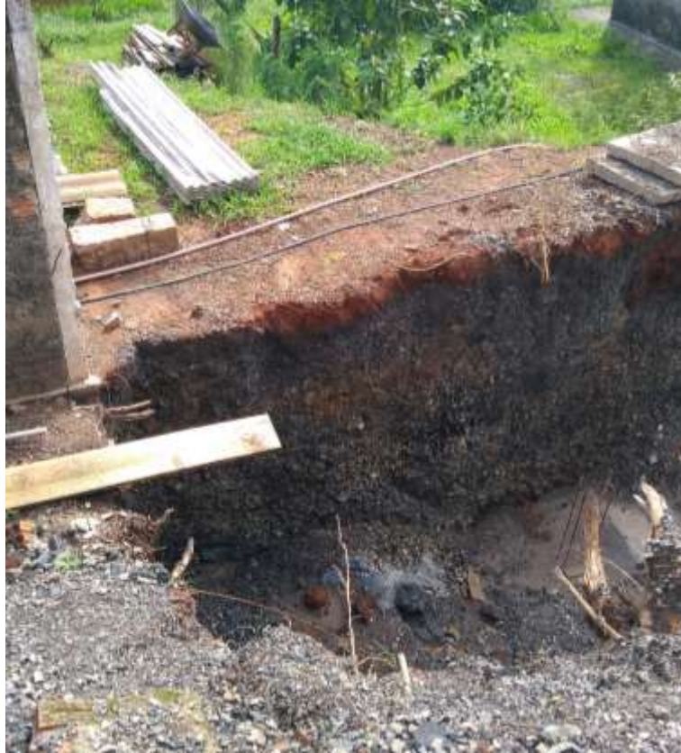
Figura 16: Local de escavação para colocação do muro de contenção. (Fonte: Dos Autores 2019)
