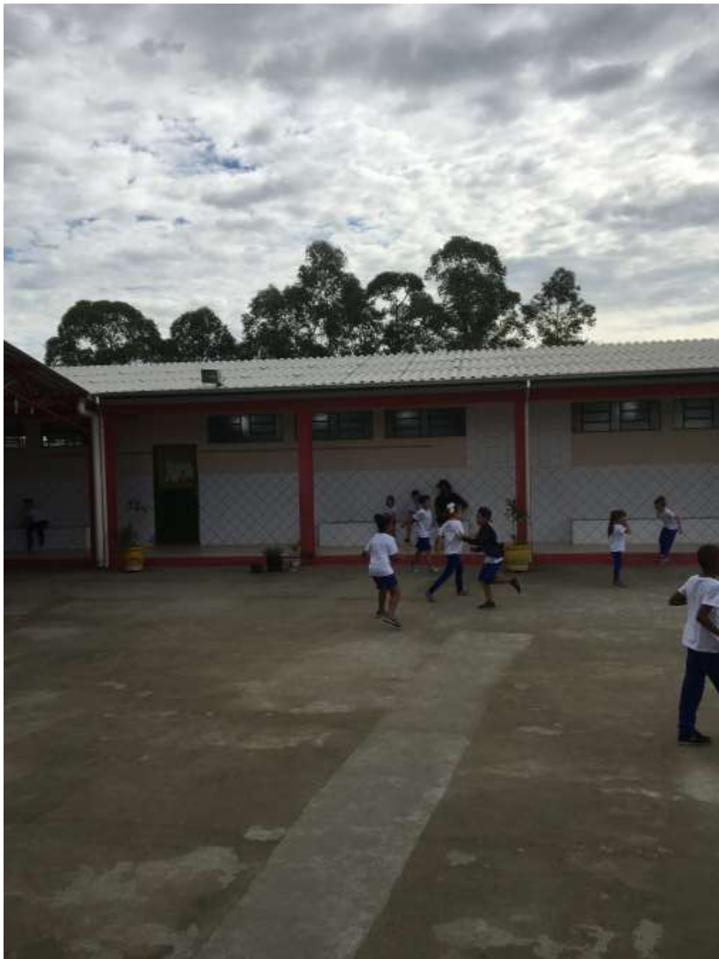
Figura 5: Telhado concluído. (Fonte: Dos Autores 2019)
