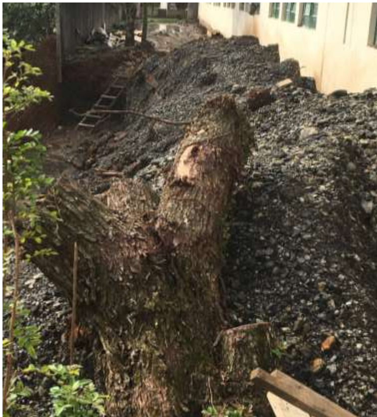
Figura 17: Acúmulo de material apoiado nas paredes da escola. (Fonte: Dos Autores 2019)
