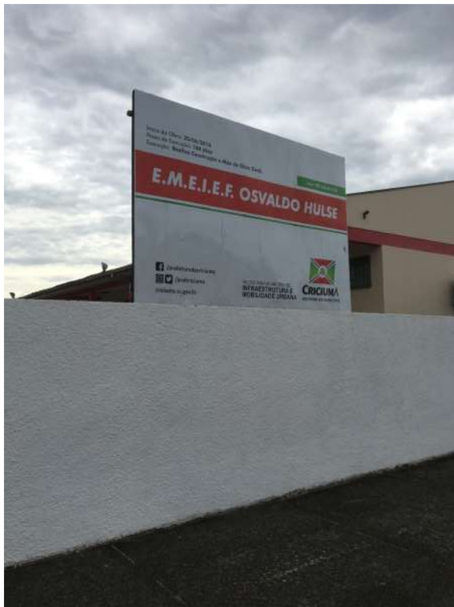
Figura 4: Placa para identificação da obra em execução. (Fonte: Dos Autores 2019)
