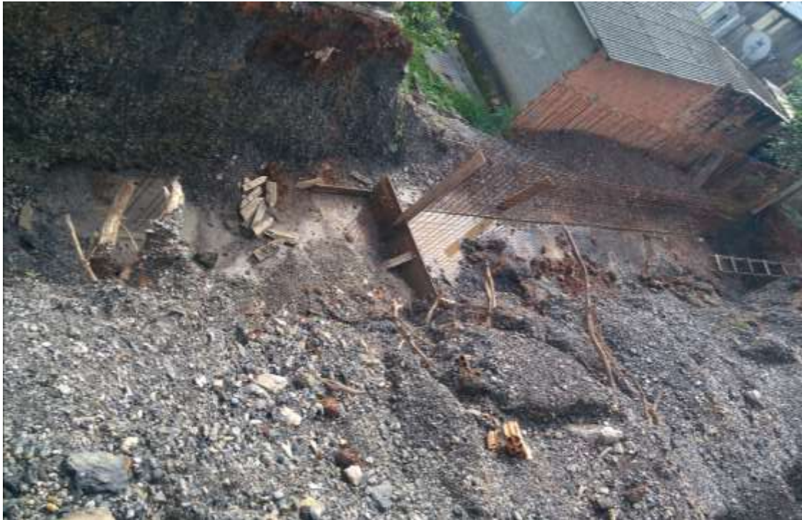
Figura 14: Local onde será construído o muro de arrimo. (Fonte: Dos Autores 2019)
