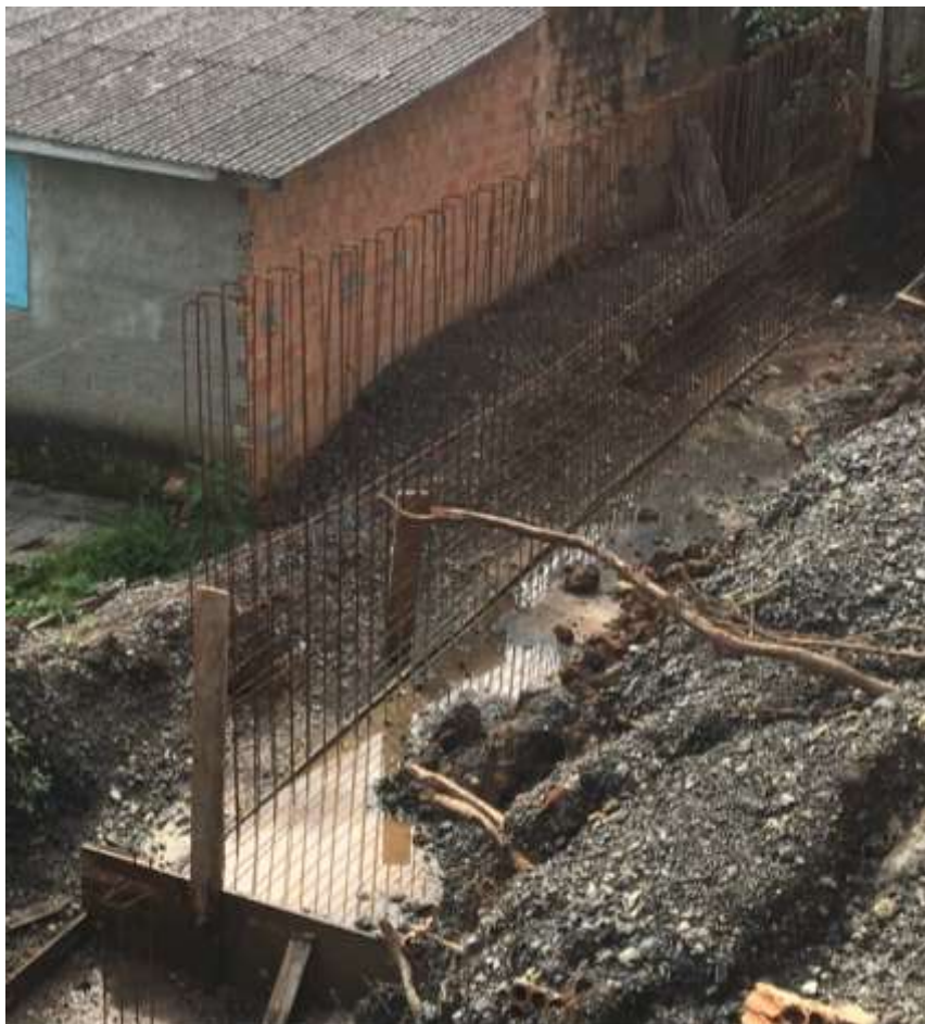
Figura 15: Estrutura da armação iniciada. (Fonte: Dos Autores 2019)
