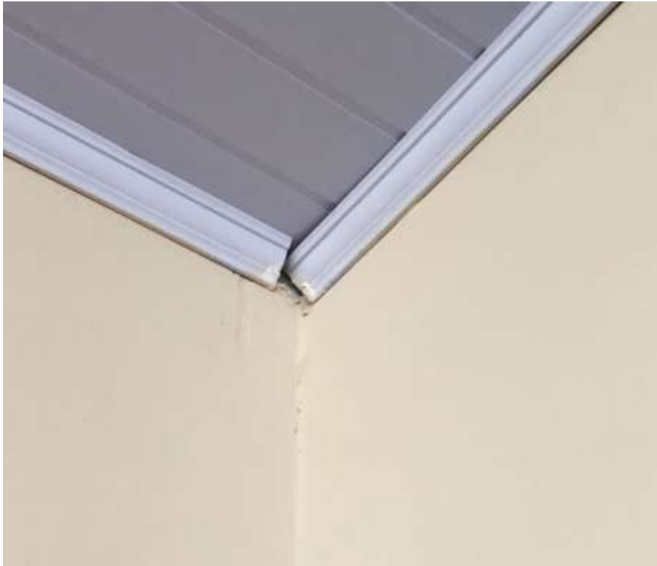
Figura 11: Junção de meia cana sem acabamento da sala 02 - turma 502. (Fonte: Dos Autores 2019)
