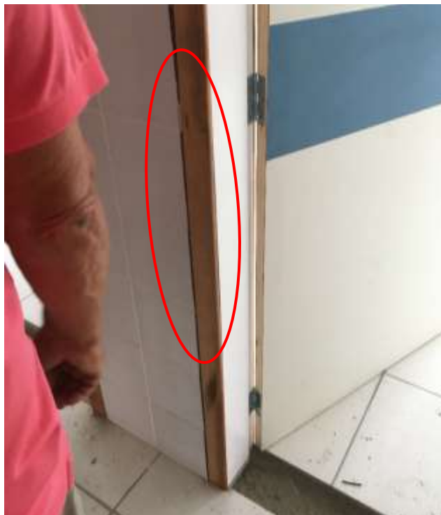
Figura 28: Desalinhamento entre vistas e azulejos. (Fonte: Dos Autores 2019)
