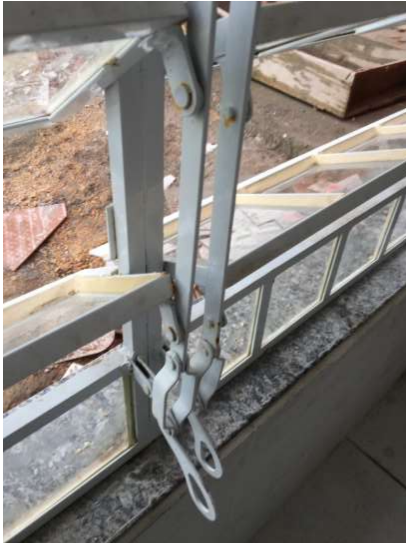
Figura 19: Alavanca emperrada. (Fonte: Dos Autores 2019)
