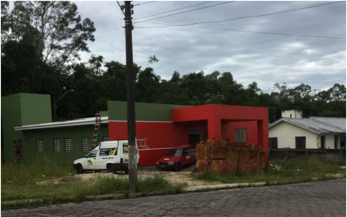
Figura 4: Vista frontal da unidade. (Fonte: Dos Autores 2019)
