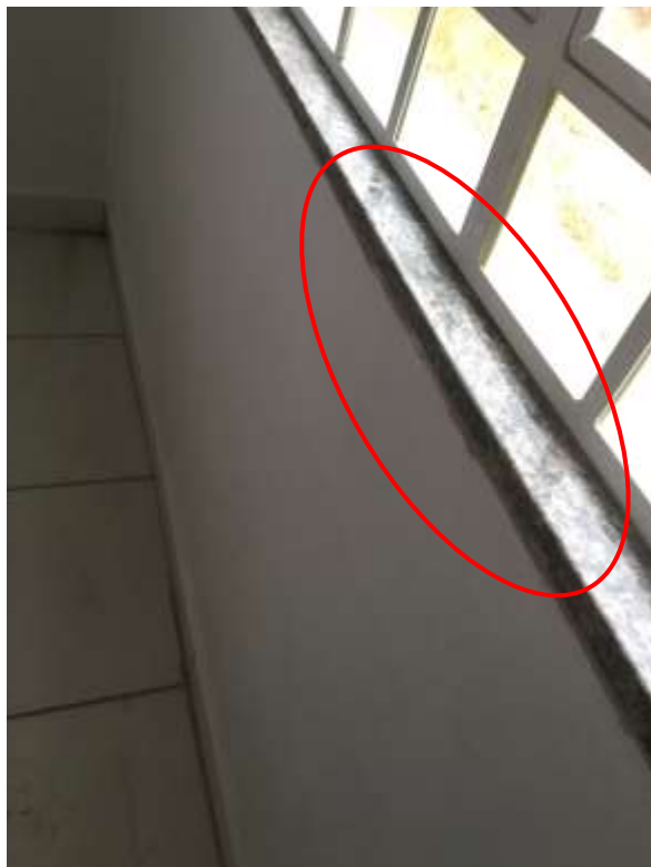
Figura 26: Despadronização das pingadeiras. (Fonte: Dos Autores 2019)
