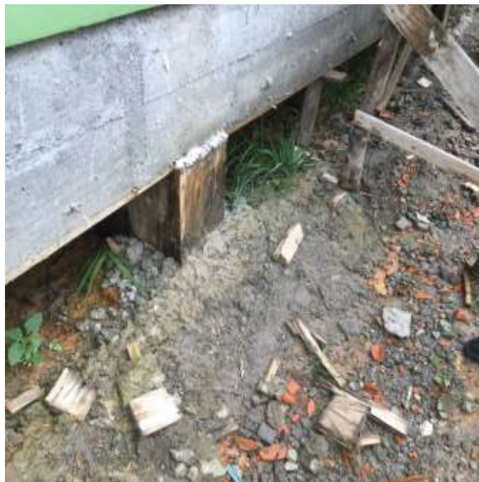
Figura 15: Pilar com a forma. (Fonte: Dos Autores 2019)
