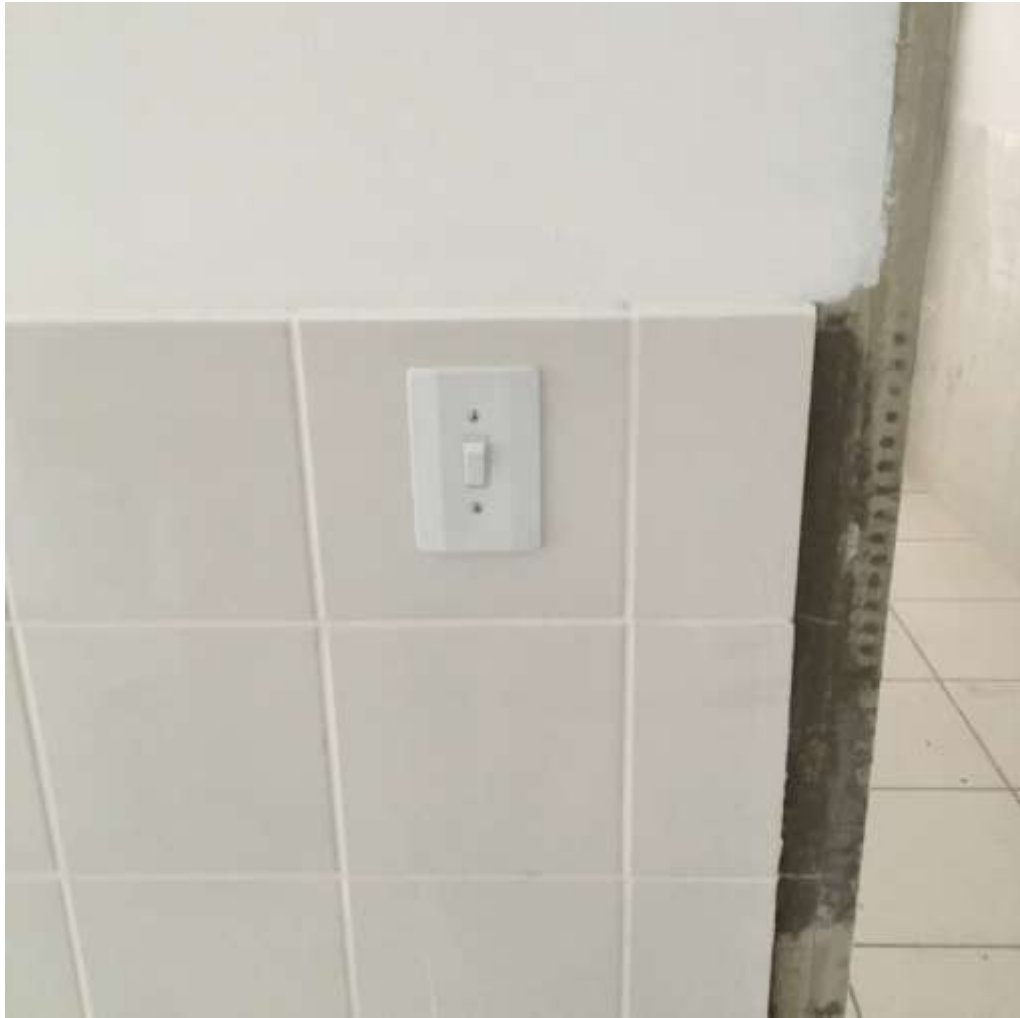
Figura 24: Interruptor com espelho colocado. (Fonte: Dos Autores 2019)
