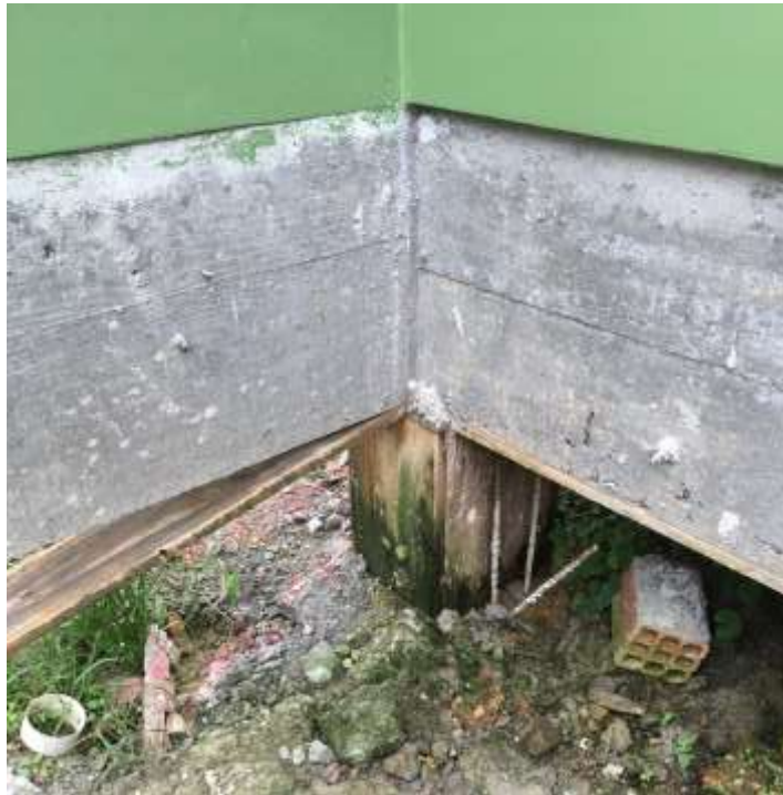
Figura 14: Pilar com a forma. (Fonte: Dos Autores 2019)
