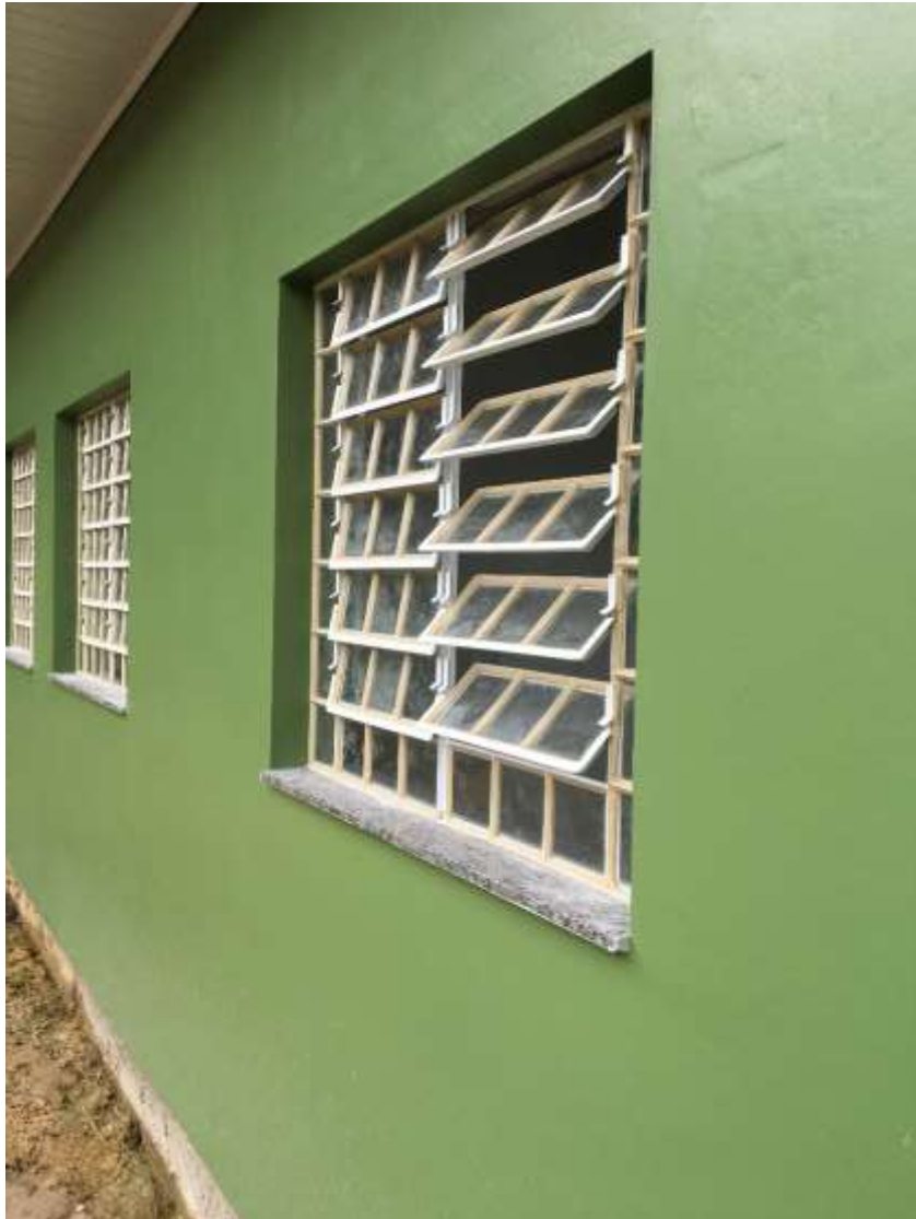
Figura 16: Esquadrias. (Fonte: Dos Autores 2019)
