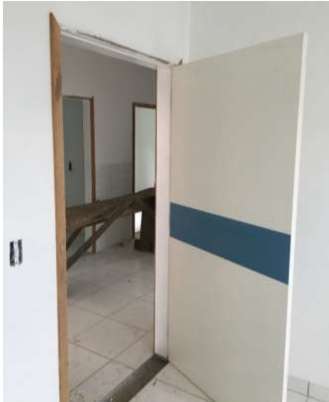
Figura 25: Colocação de portas e finalização de acabamentos. (Fonte: Dos Autores 2019)
