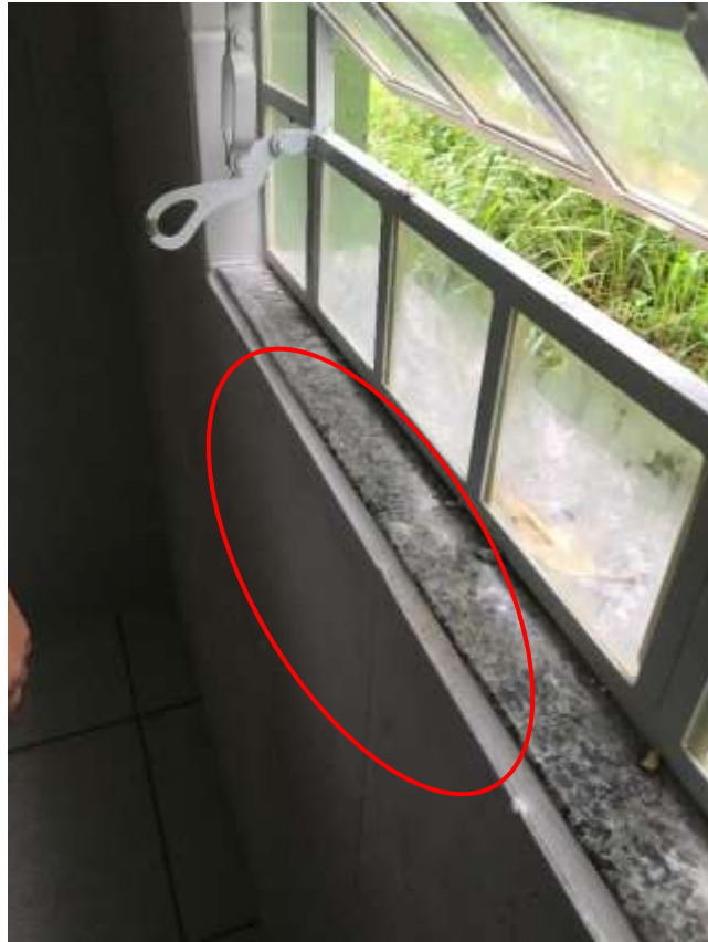
Figura 27: Despadronização das pingadeiras. (Fonte: Dos Autores 2019)
