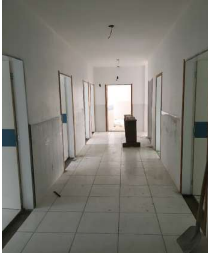
Figura 20: Pisos e azulejos assentados. (Fonte: Dos Autores 2019)
