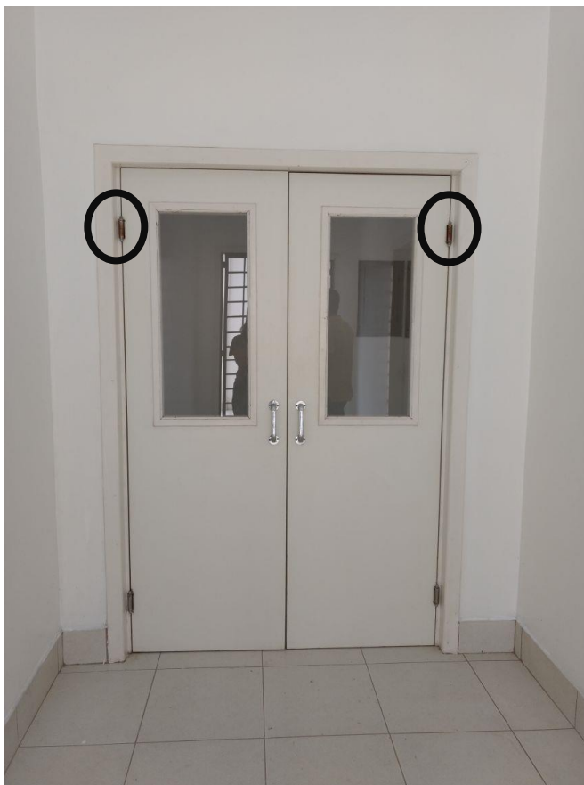
Figura 25: Porta com dobradiças enferrujadas. (Fonte: Dos Autores 2018)
