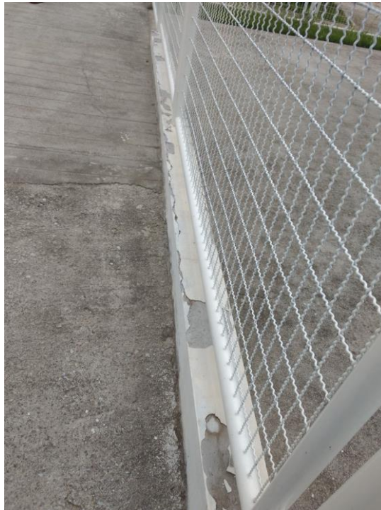
Figura 8: Massa fina em fragmentação. (Fonte: Dos Autores 2018)
