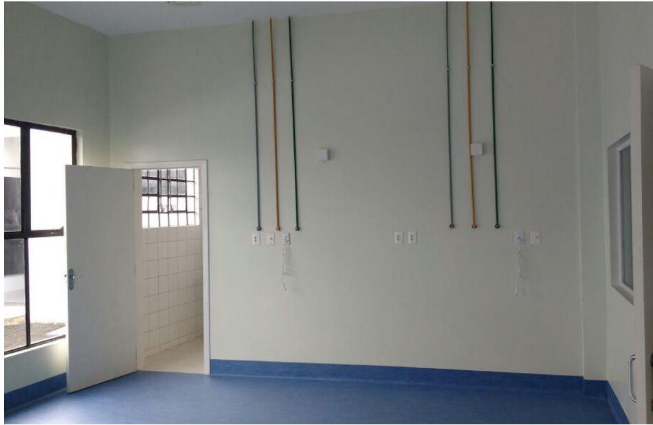
Figura 14: Quarto de plantão. (Fonte: Dos Autores 2018)
