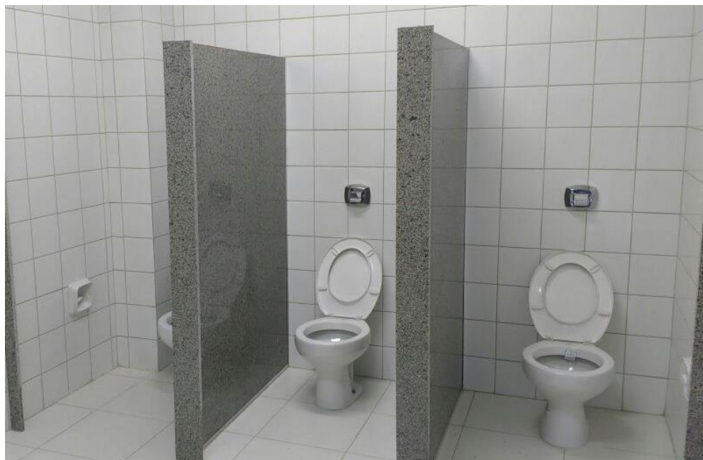
Figura 13: Banheiro da unidade em fase de conclusão. (Fonte: Dos Autores 2018)
