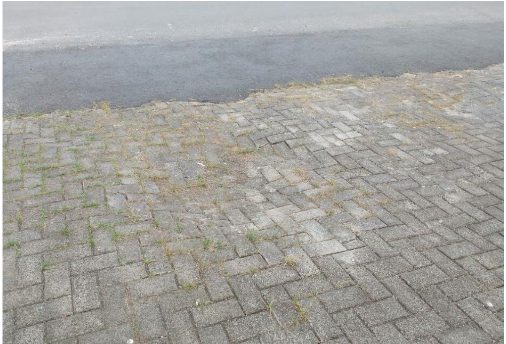
Figura 5: Paver do estacionamento desnivelado. (Fonte: Dos Autores 2018)
