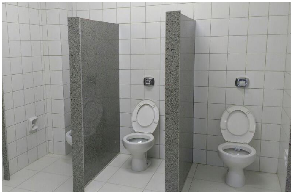
Figura 8: Banheiro da unidade em fase de conclusão. (Fonte: Dos Autores 2018)
