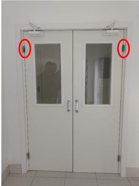
Figura 18: Dobradiças enferrujadas. (Fonte: Dos Autores 2018)
