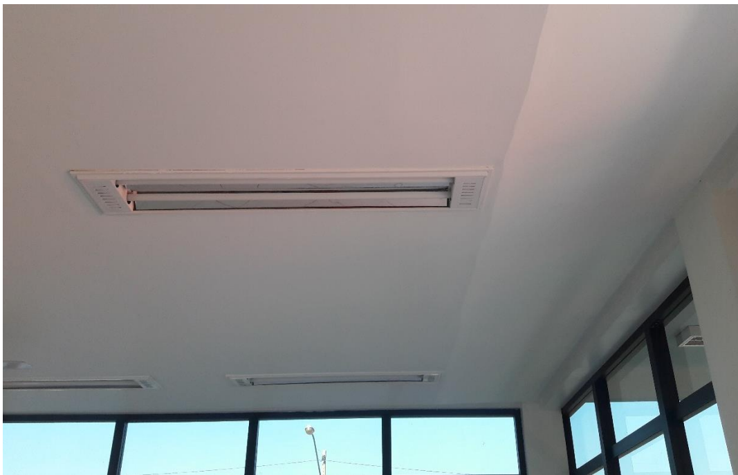
Figura 6: Forro reformado. (Fonte: Dos Autores 2017)
