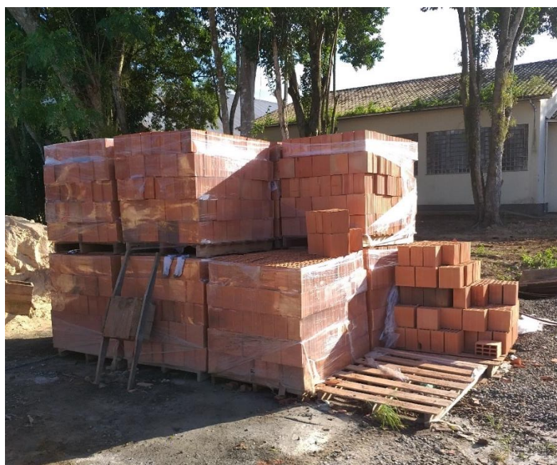
Figura 10: Blocos cerâmicos armazenados corretamente (Fonte: Dos Autores 2019)
