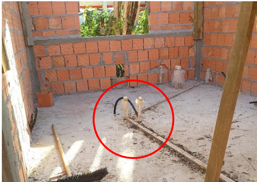
Figura 23: Tubulação no consultório do dentista (Fonte: Dos Autores 2019)
