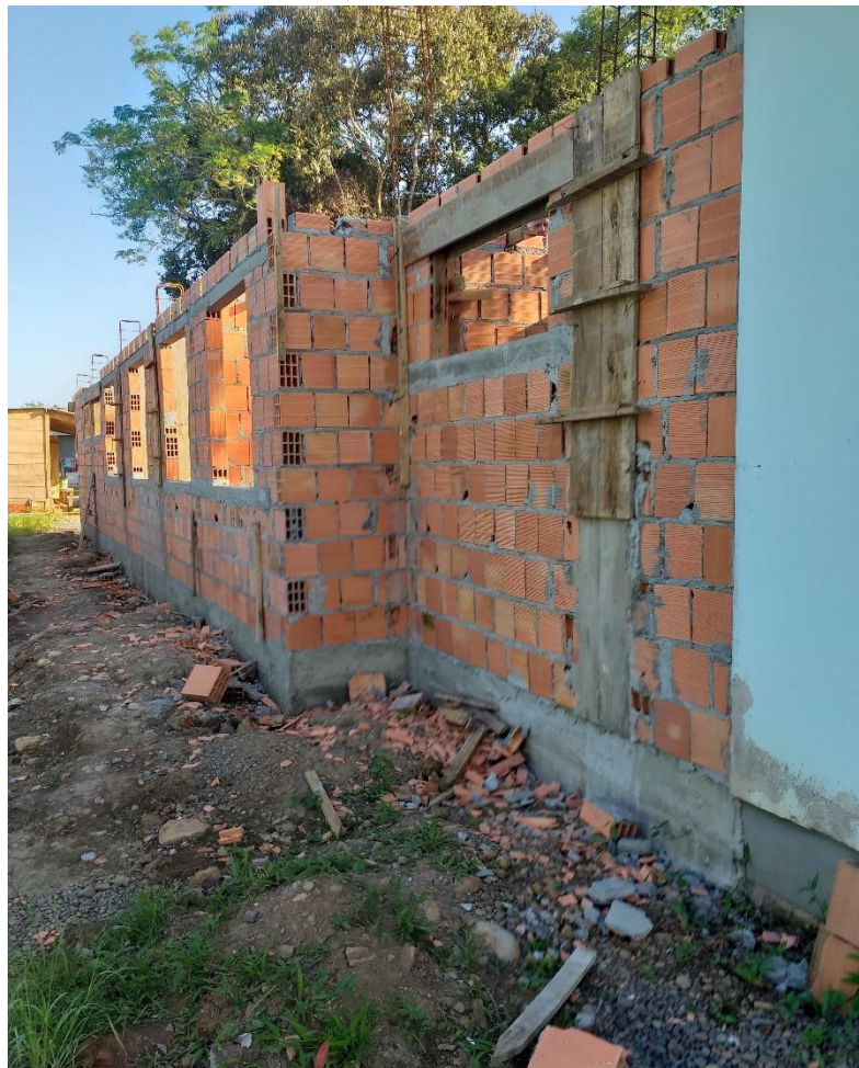
Figura 6: Fachada lateral da obra em execução (Fonte: Dos Autores 2019)
