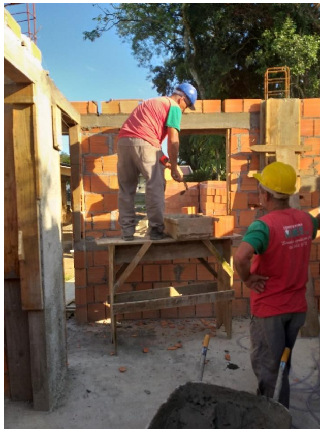
Figura 19: Funcionários utilizando EPI (Fonte: Dos Autores 2019)
