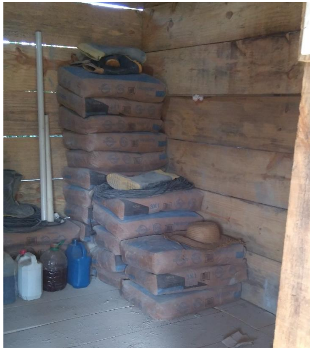
Figura 15: Sacos armazenados incorretamente (Fonte: Dos Autores 2019)
