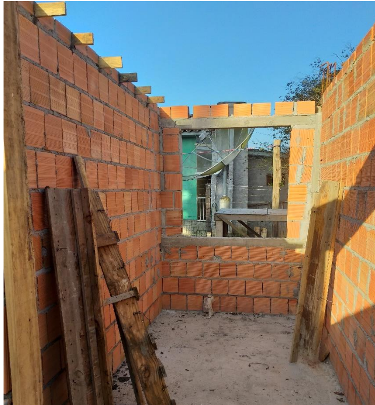
Figura 20: Consultório em execução (Fonte: Dos Autores 2019)
