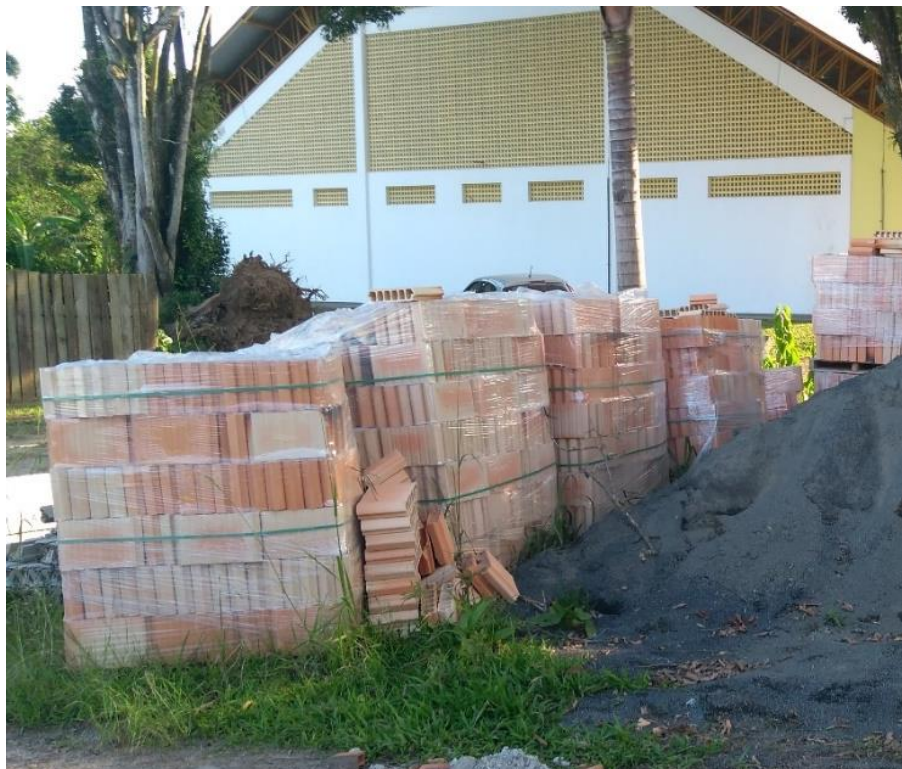
Figura 12: Tabelas armazenadas corretamente sobre pallets. (Fonte: Dos Autores 2019)
