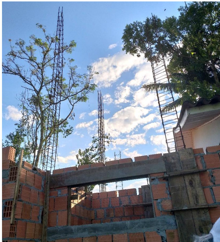
Figura 21: Ferragem dos pilares (Fonte: Dos Autores 2019)
