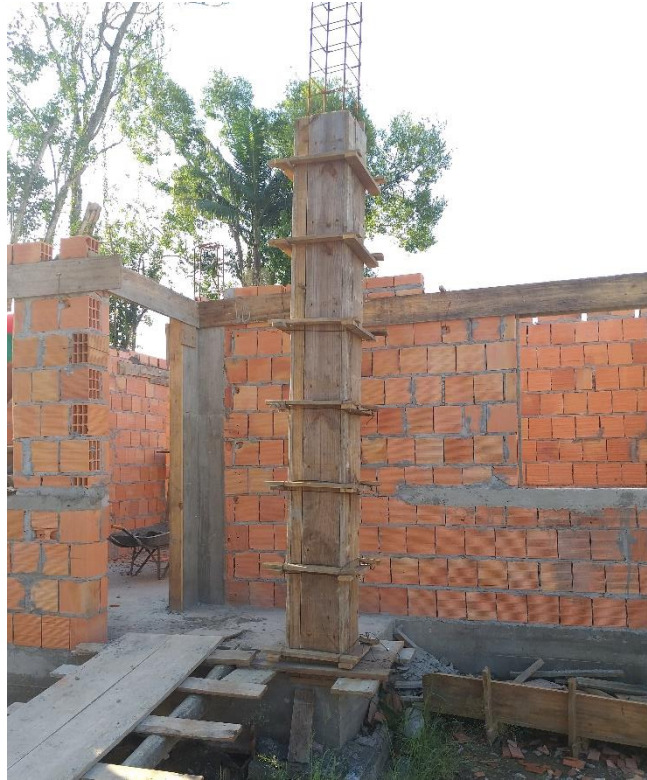
Figura 18: Pilar em execução (Fonte: Dos Autores 2019)
