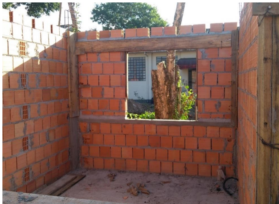
Figura 17: Consultório em execução (Fonte: Dos Autores 2019)
