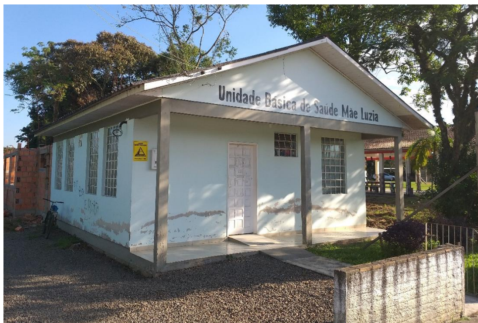
Figura 5: Fachada Frontal UBS Mãe Luzia (Fonte: Dos Autores 2019)
