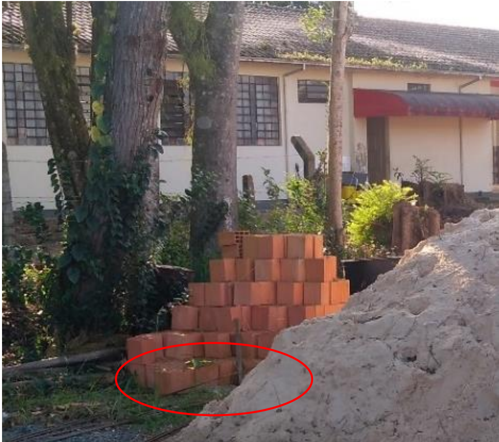
Figura 13: Materiais em contato direto com o solo (Fonte: Dos Autores 2019)
