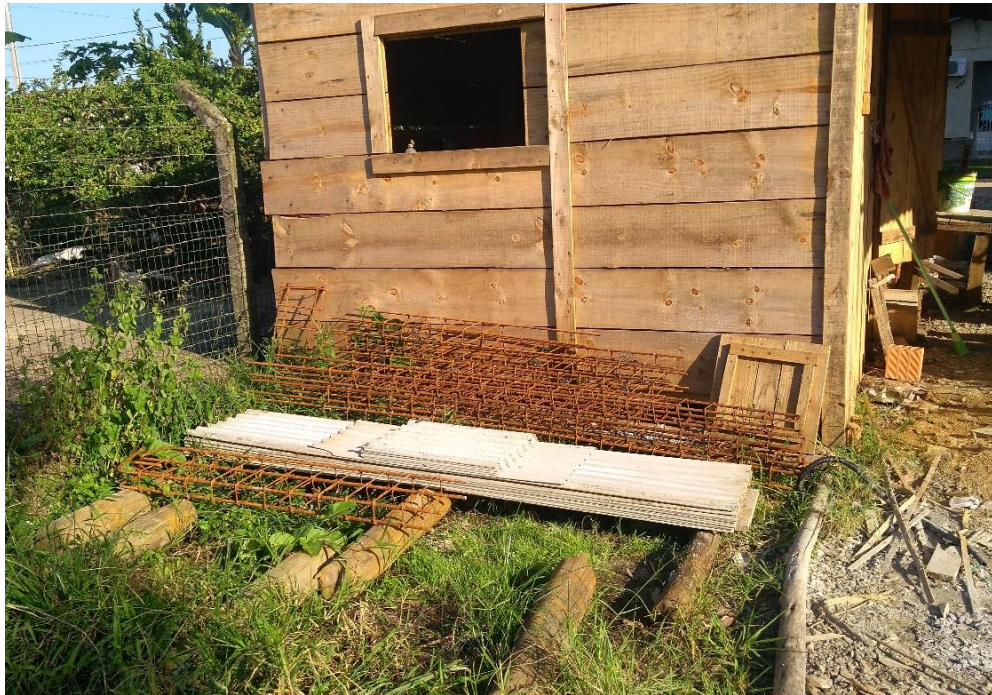
Figura 11: Materiais armazenados corretamente (Fonte: Dos Autores 2019)
