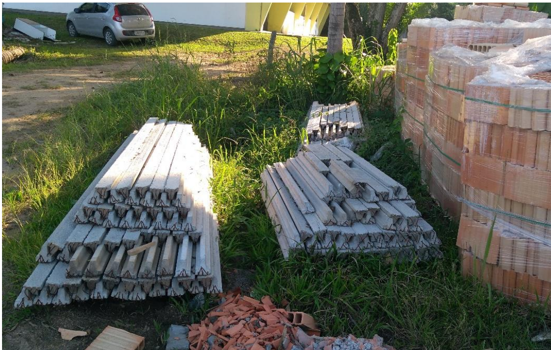
Figura 14: Vigotas armazenadas corretamente sem contato com o solo. (Fonte: Dos Autores 2019)
