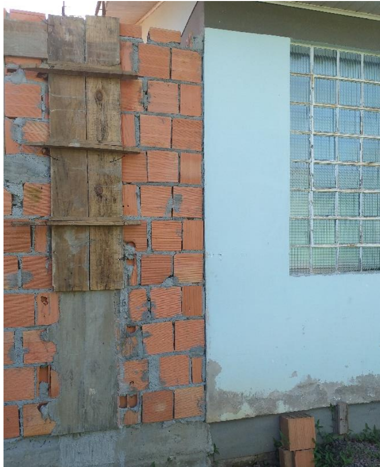
Figura 29: Encontro entre antiga e nova estrutura da UBS Mãe Luzia (Fonte: Dos Autores 2019)
