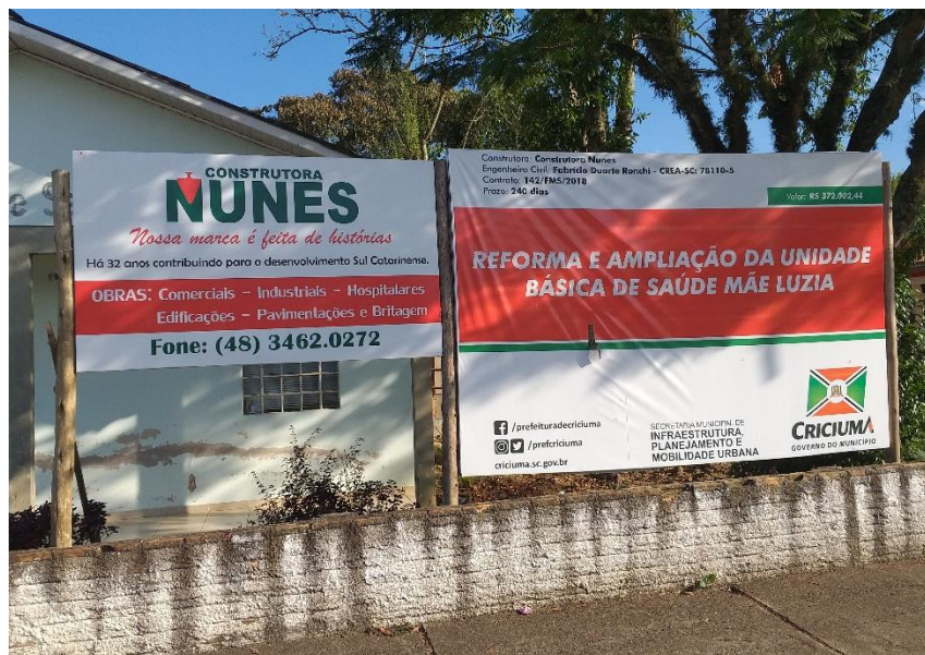
Figura 4: Placa para identificação da obra em execução. (Fonte: Dos Autores 2019)
