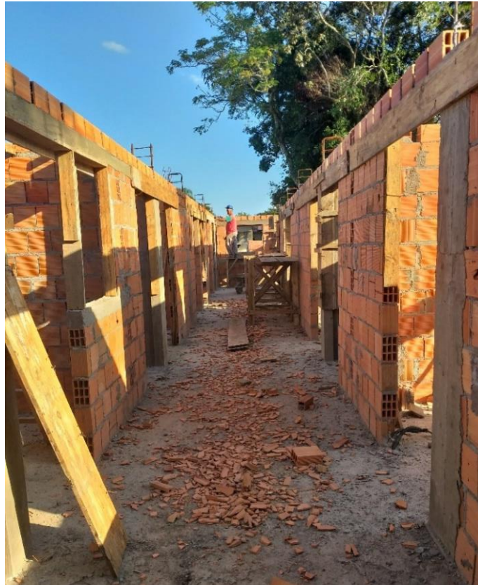
Figura 16: Corredor de acesso (Fonte: Dos Autores 2019)
