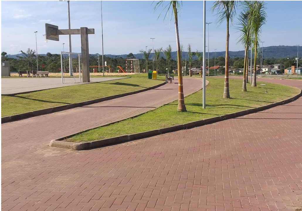
Figura 54: Vista das pistas de passeio. (Fonte: Dos Autores 2019)
