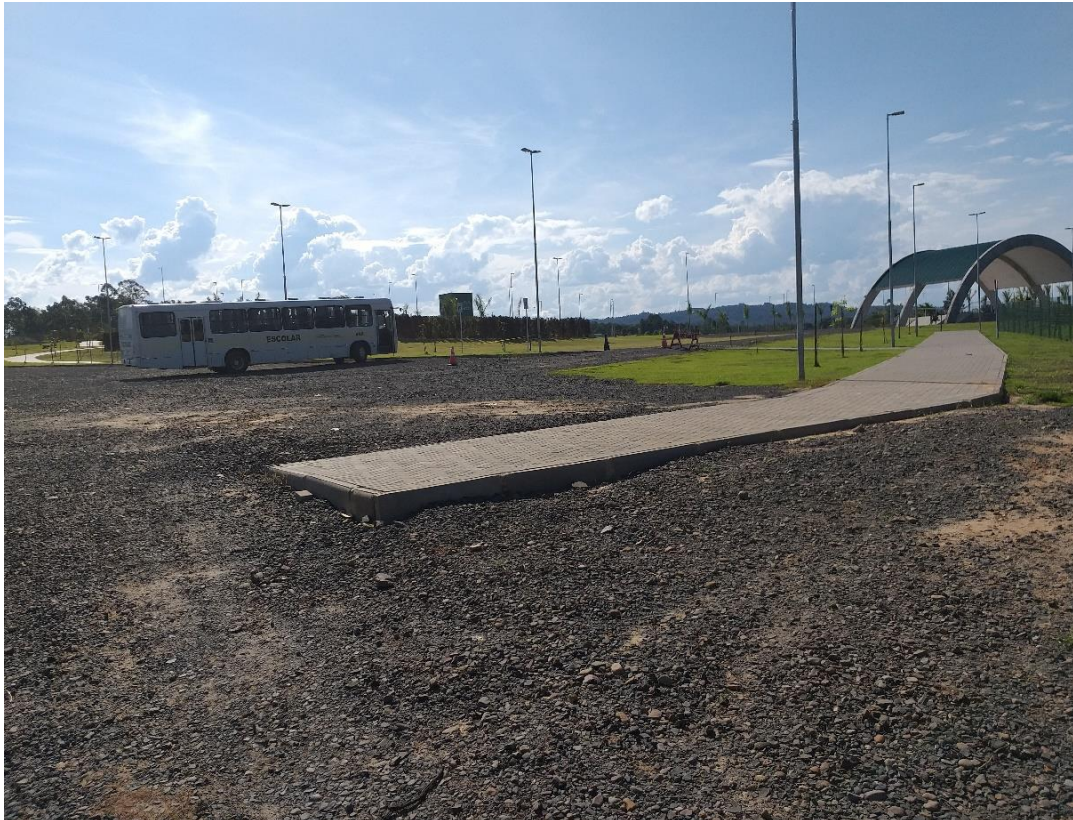
Figura 24: Estacionamento situado à direita da entrada principal. (Fonte: Dos Autores 2019)
