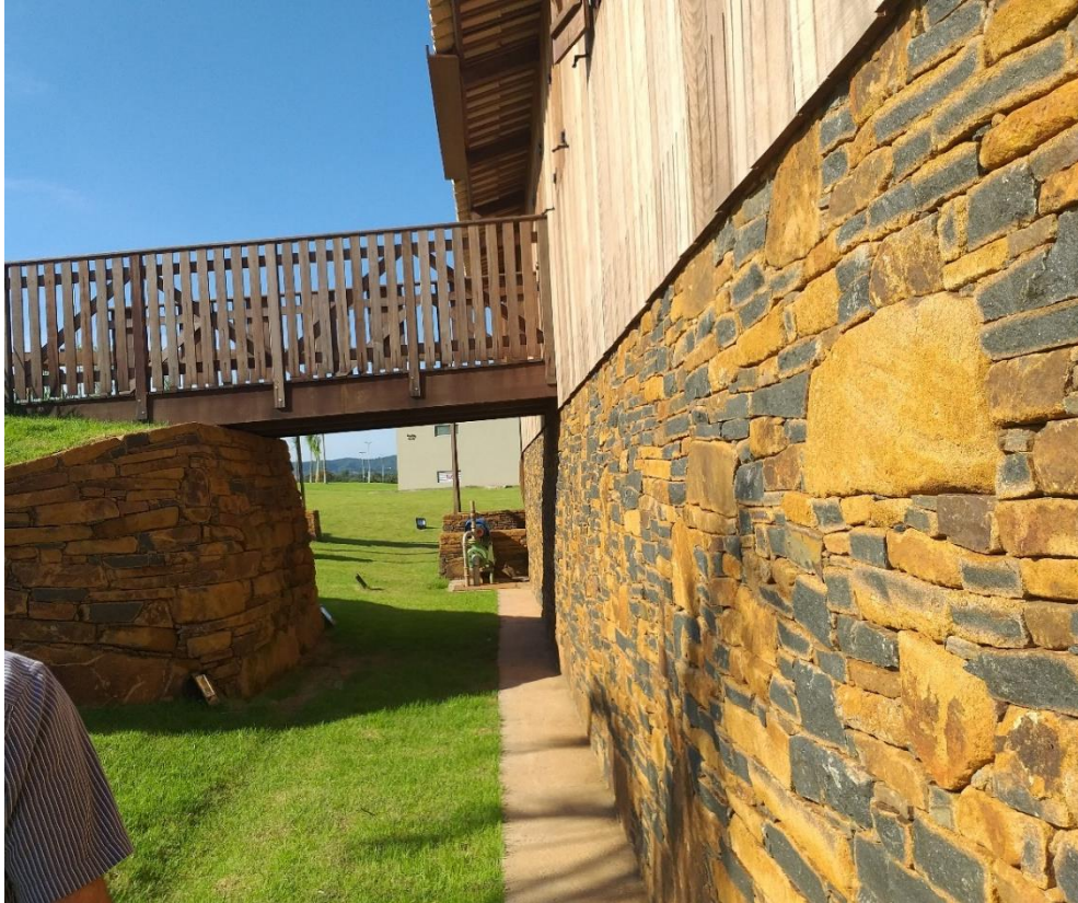
Figura 28: Revestimento basáltico da atafona. (Fonte: Dos Autores 2019)
