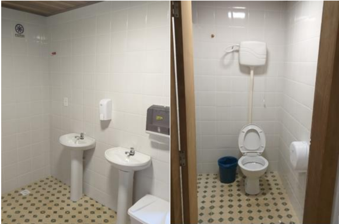
Figura 37: Banheiro masculino atafona. (Fonte: Dos Autores 2019)
