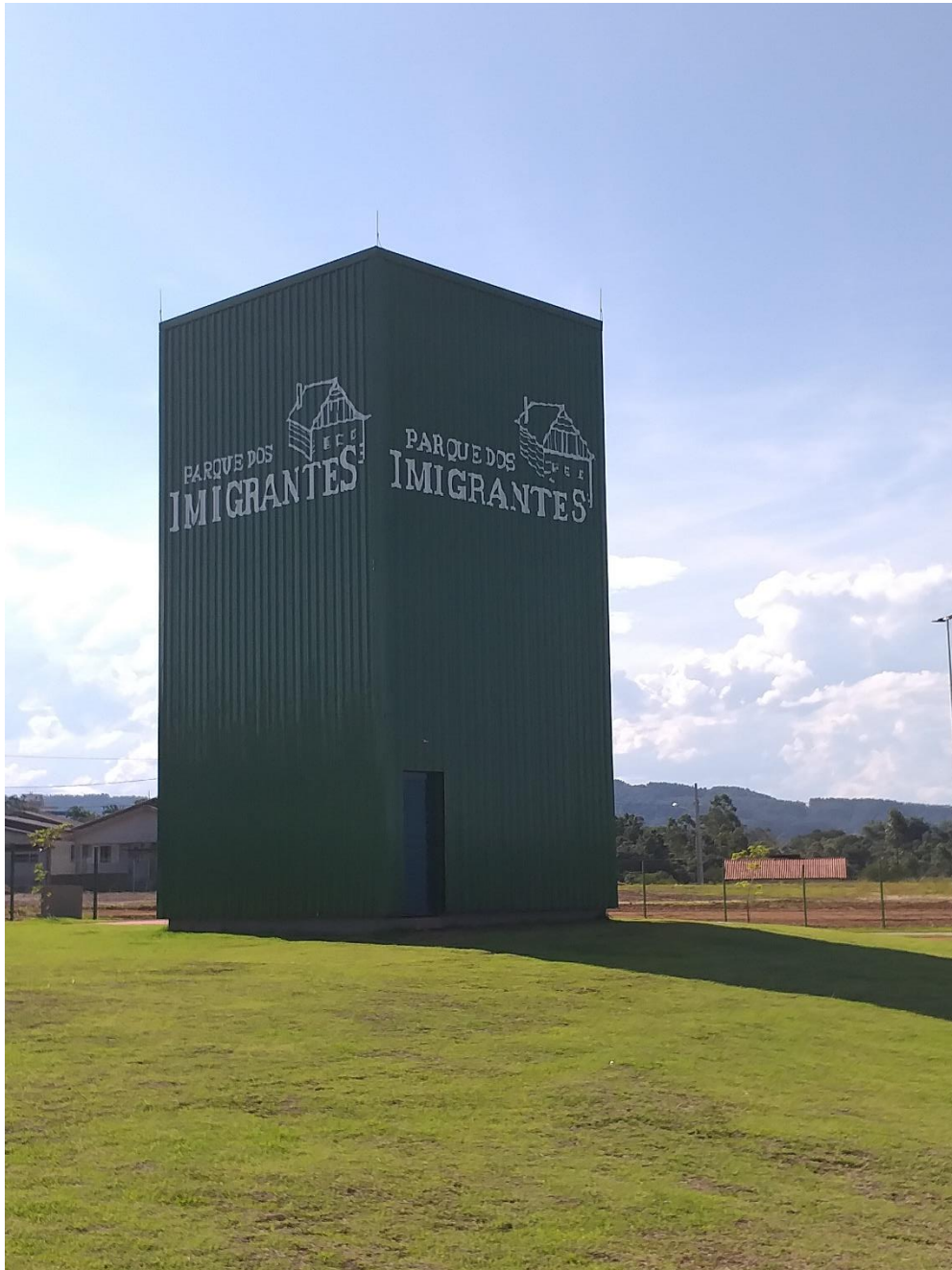
Figura 56: Estrutura que abriga o reservatório do parque. (Fonte: Dos Autores 2019)
