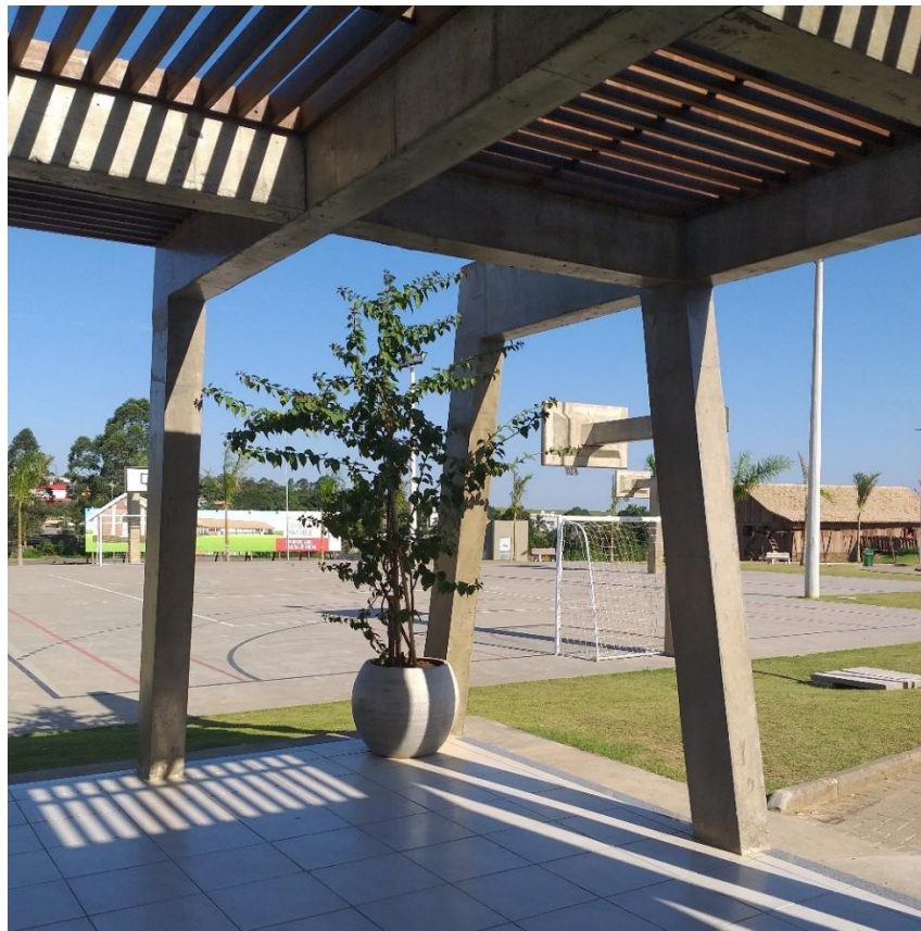
Figura 64: Área de ventilação da edificação. (Fonte: Dos Autores 2019)
