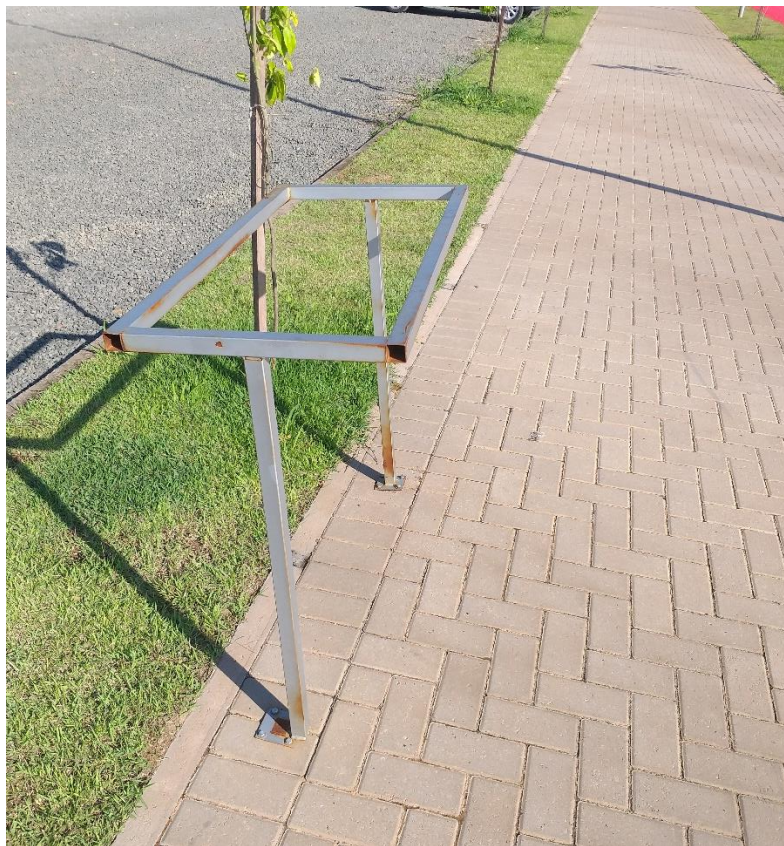
Figura 90: Ausência da lixeira e oxidação na estrutura de aço. (Fonte: Dos Autores 2019)
