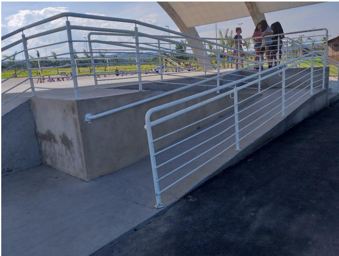
Figura 16: Rampa de acessibilidade. (Fonte: Dos Autores 2019)
