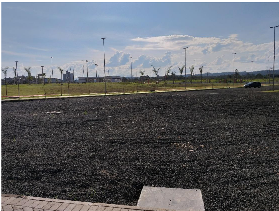
Figura 47: Estacionamento com acesso pela Rua Trezentos e Dez. (Fonte: Dos Autores 2019)
