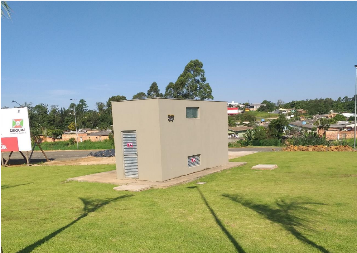
Figura 57: Subestação. (Fonte: Dos Autores 2019)
