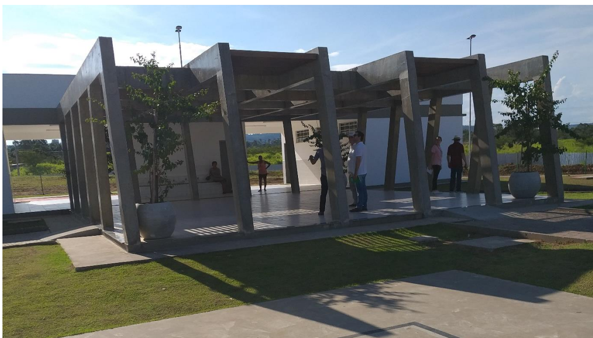
Figura 62: Vista frontal da área de lazer. (Fonte: Dos Autores 2019)
