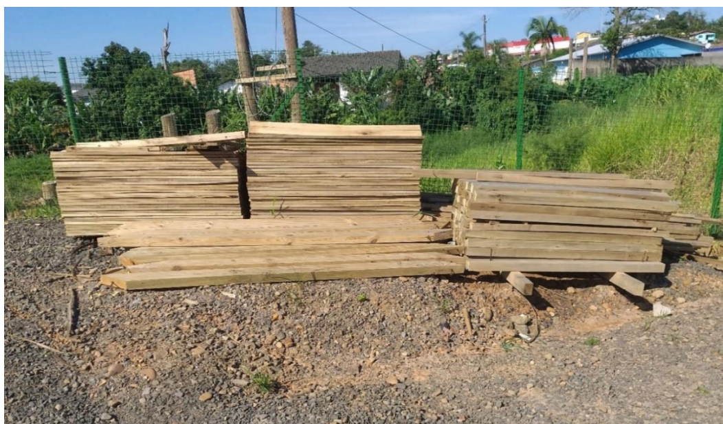
Figura 23: Armazenamento indevido em contato com o solo. (Fonte: Dos Autores 2019)
