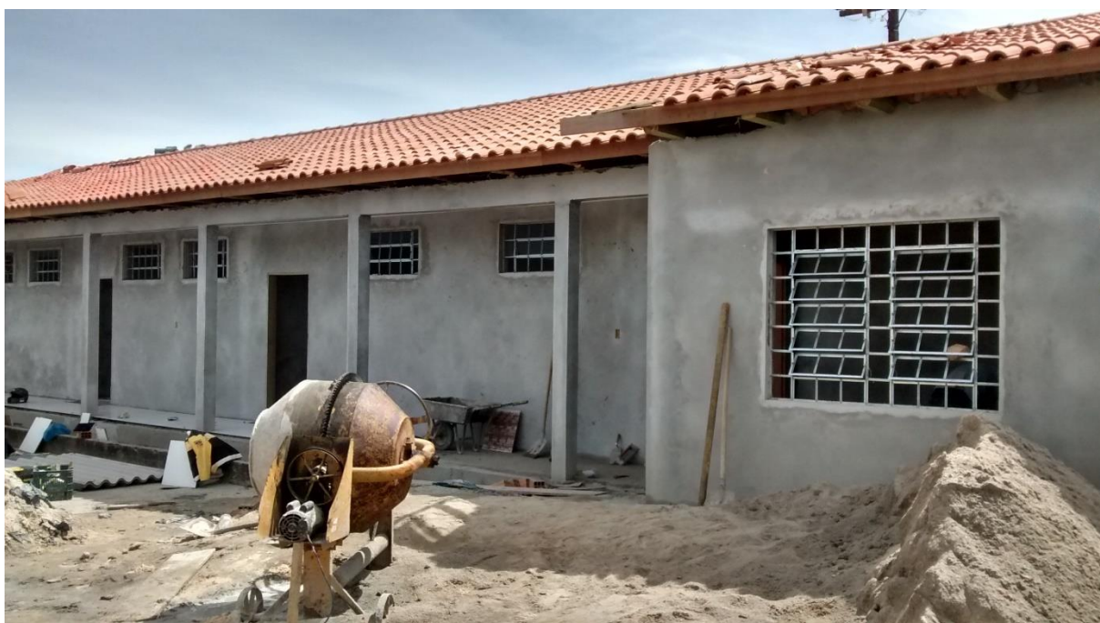
Figura 04: Fachada frontal do prédio. (Fonte: Dos autores 2015)
