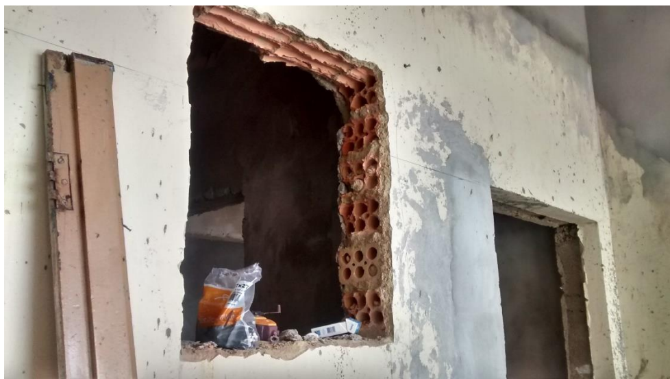
Figura 13: Construção do banheiro. (Fonte: Dos autores 2015)
