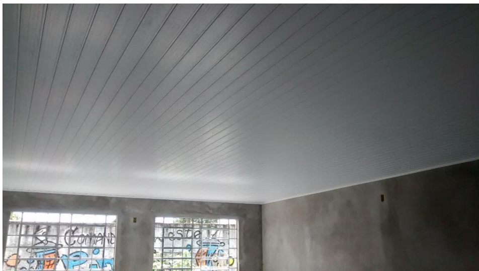
Figura 09: Cobertura em forro de PVC instalada em uma das salas. (Fonte: Dos autores 2015)
