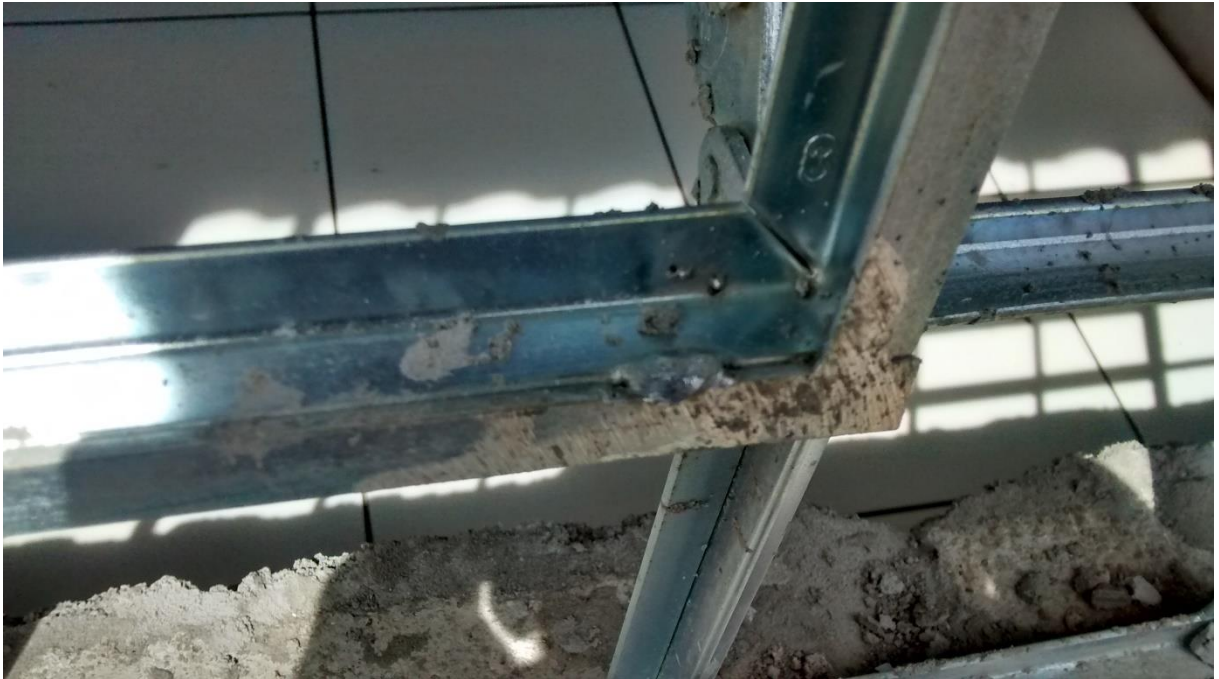
Figura 16: Esquadria apresentando um acabamento de má qualidade. (Fonte: Dos autores 2015)
