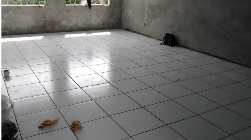
Figura 08: Colocação de cerâmica. (Fonte: Dos autores 2015)
