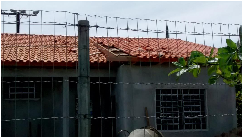
Figura 20: Telhado com elevação sobre o depósito. (Fonte: Dos autores 2015)
