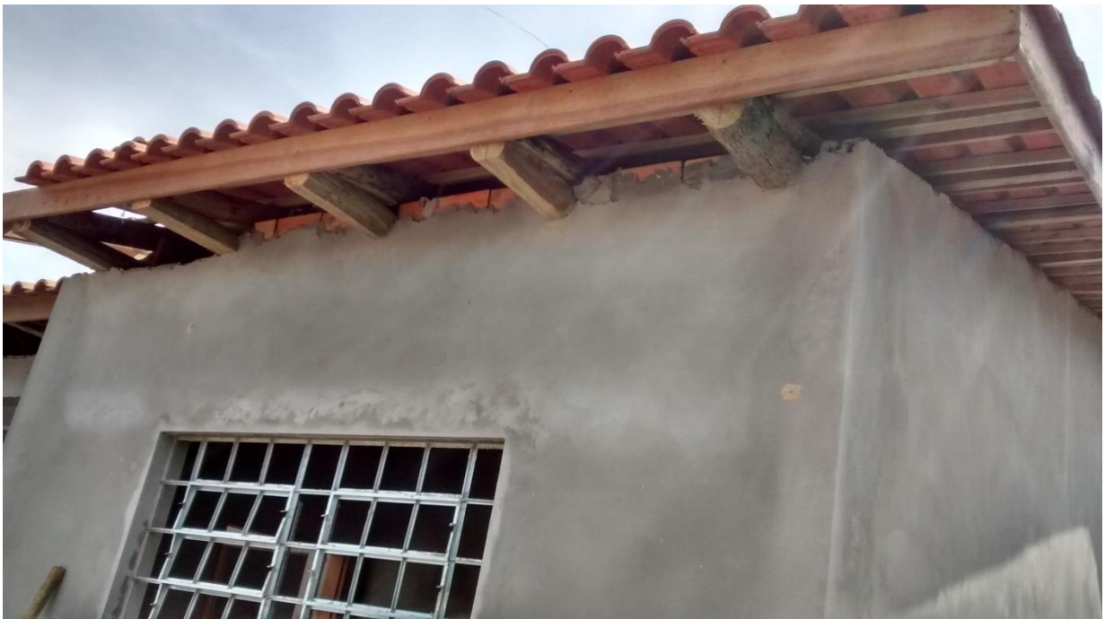
Figura 07: Beiral a ser executado. (Fonte: Dos autores 2015)
