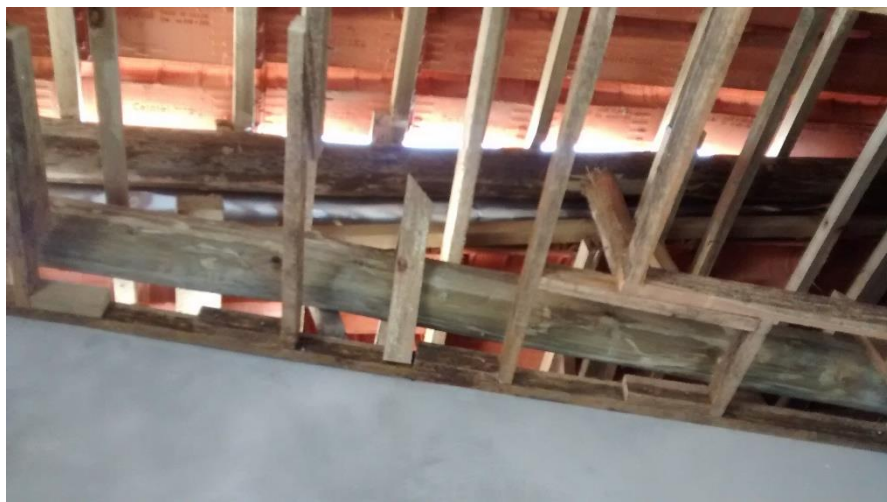
Figura 21: Chapa metálica colocada internamente. (Fonte: Dos autores 2015)
