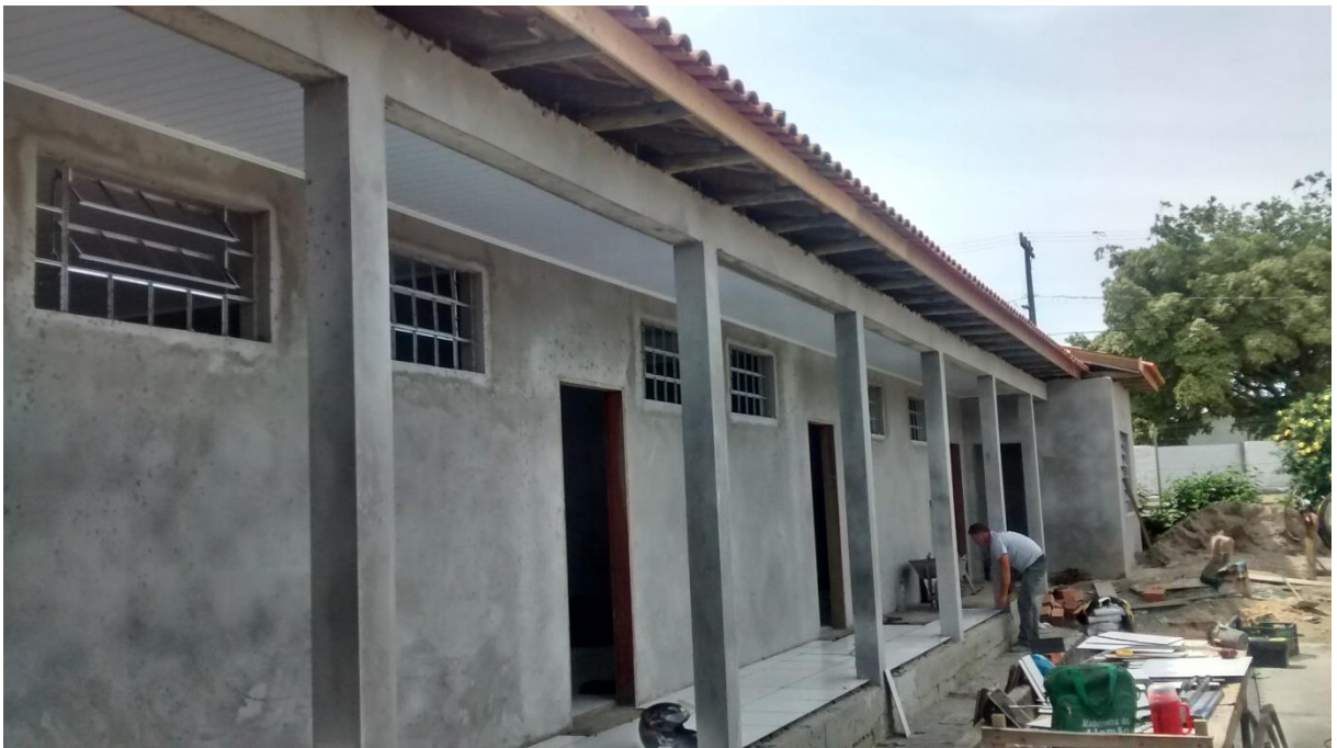
Figura 05: Corredor acesso as salas de aula e ao depósito. (Fonte: Dos autores 2015)
