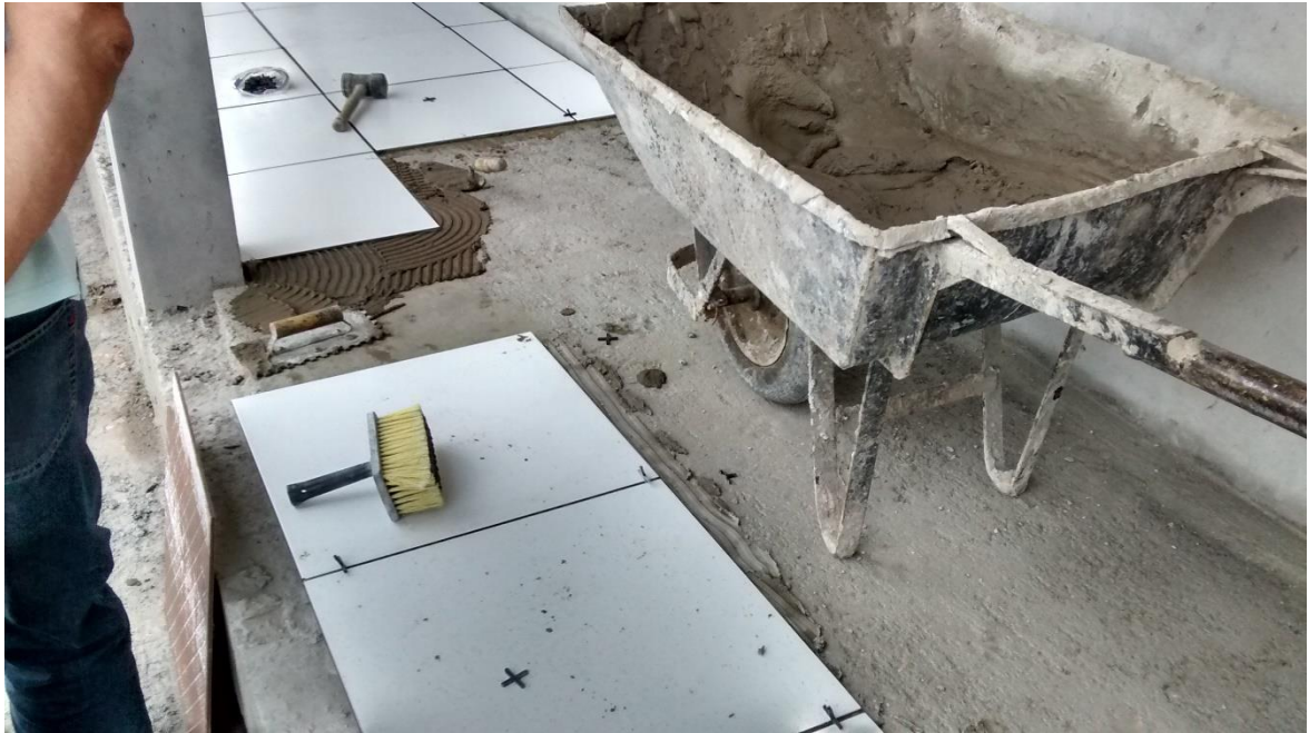
Figura 06: Colocação da pavimentação no corredor externo. (Fonte: Dos autores 2015)
