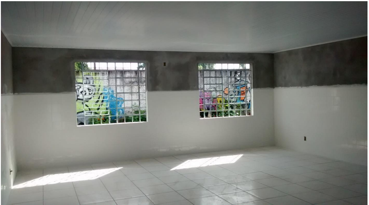
Figura 05: Revestimento cerâmico e cobertura sala de aula. (Fonte: Dos autores 2015)
