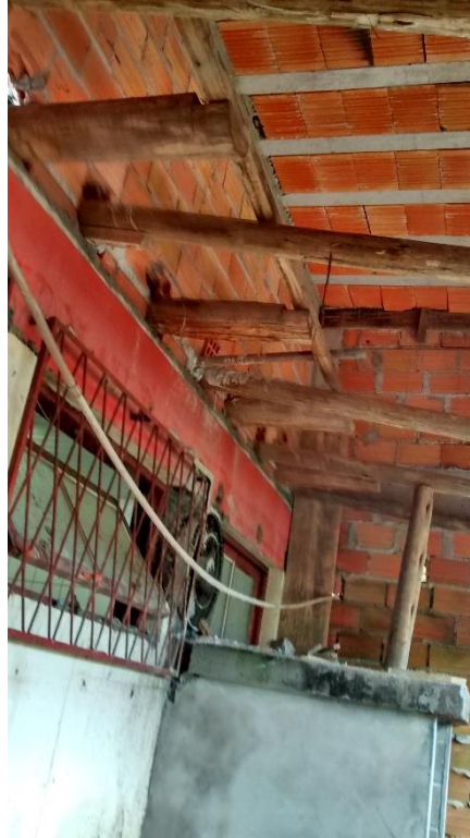
Figura 16: Estrutura que abrigará reservatório internamente. (Fonte: Dos autores 2015)
