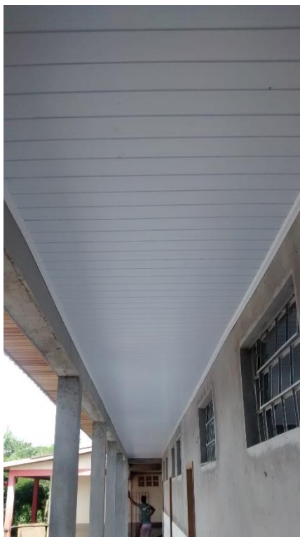
Figura 06: Cobertura em forro de PVC no corredor. (Fonte: Dos autores 2015)
