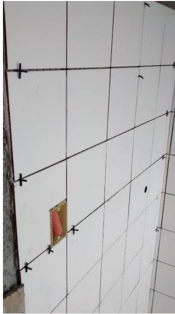
Figura 13: Revestimento cerâmico sendo colocado no banheiro. (Fonte: Dos autores 2015)
