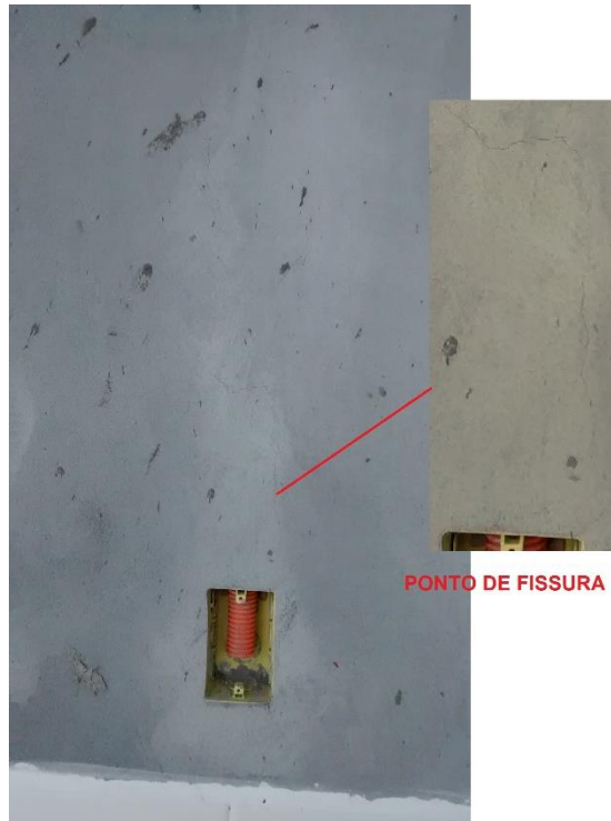
Figura 20: Fissuras em uma das paredes. (Fonte: Dos autores 2015)
