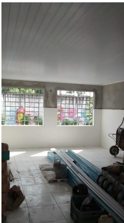
Figura 07: Revestimento cerâmico e cobertura sala de aula. (Fonte: Dos autores 2015)
