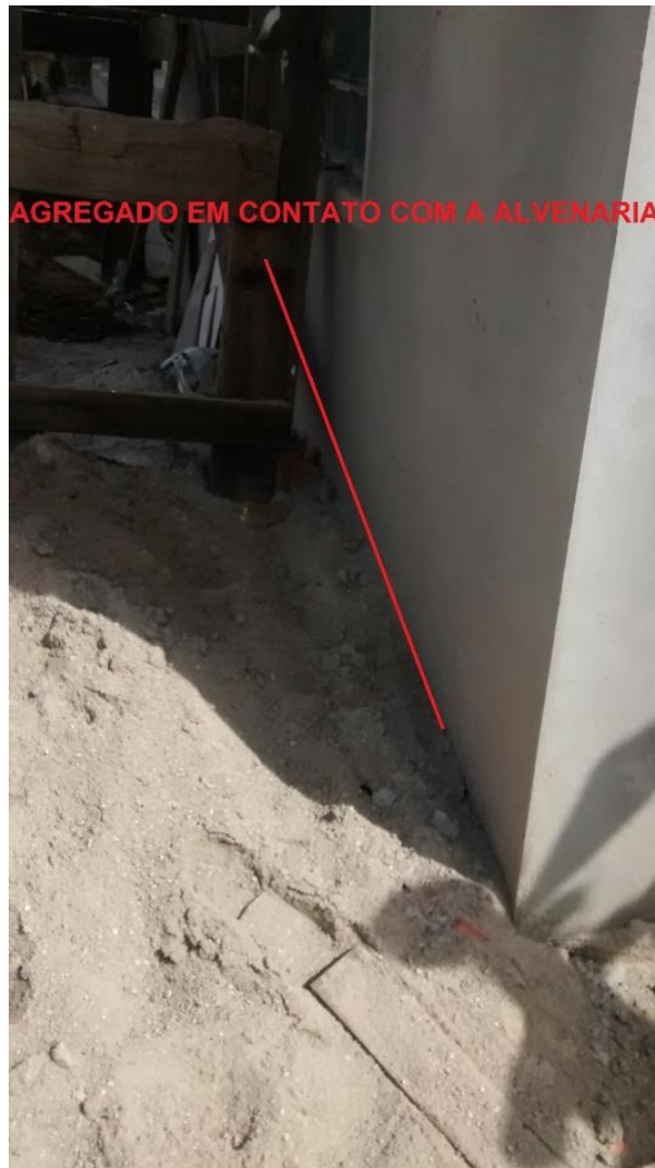
Figura 27: Agregado em contato com a parede. (Fonte: Dos autores 2015)
