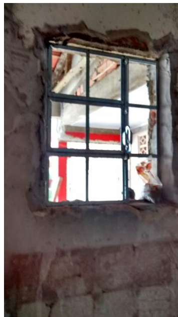
Figura 14: Instalação de esquadria em um dos ambientes em construção. (Fonte: Dos autores 2015)
