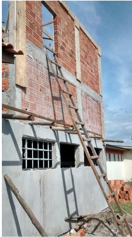
Figura 15: Construção da estrutura que abrigará o reservatório. (Fonte: Dos autores 2015)
