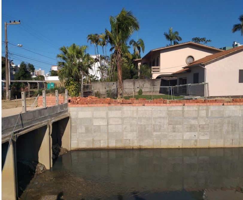
Figura 5: Muro em construção (Fonte: Dos Autores 2019)
