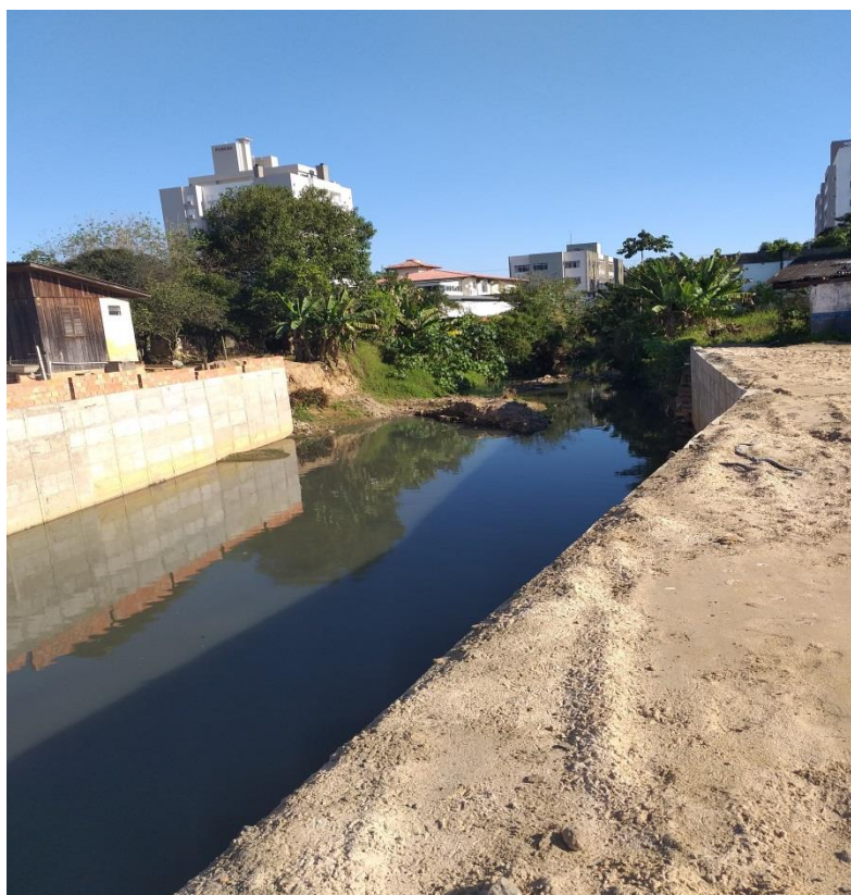
Figura 4: Segunda etapa do canal auxiliar. (Fonte: Dos Autores 2019)
