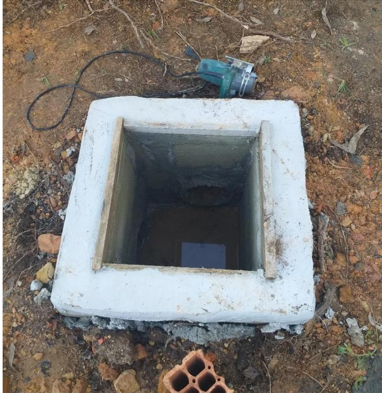
**Figura 18:** Caixa de inspeção em execução. (Fonte: Dos Autores 2019)
