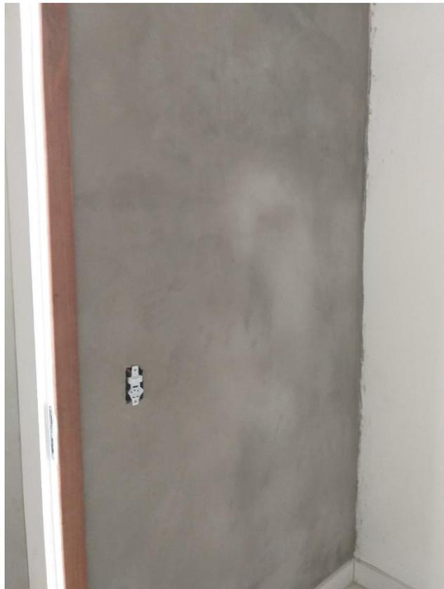
**Figura 74:** Parede recém rebocada e sem pintura. (Fonte: Dos Autores 2019)
