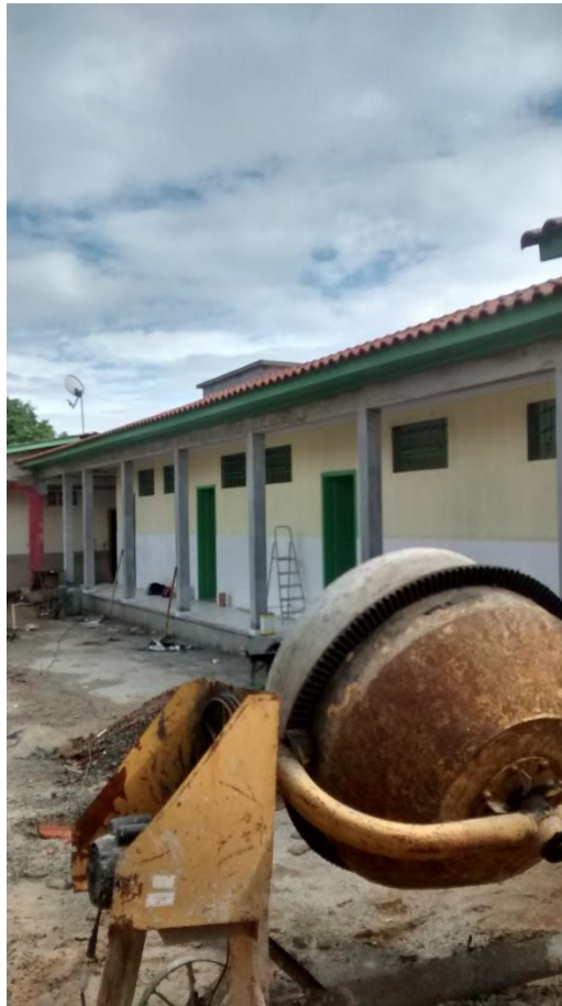
Figura 04: Fachada frontal do prédio. (Fonte: Dos autores 2016)
