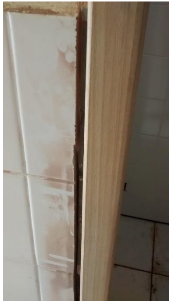
Figura 29: Retrabalho a ser realizado entre a vista e o revestimento. (Fonte: Dos autores 2016)
