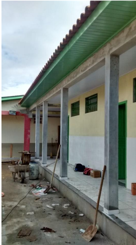
Figura 08: Pintura da fachada frontal e beiral. (Fonte: Dos autores 2016)
