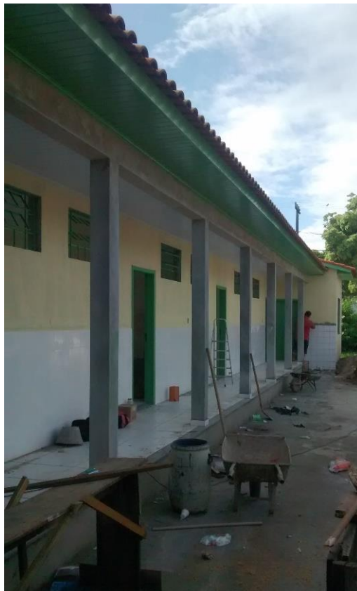
Figura 05: Fachada frontal do prédio. (Fonte: Dos autores 2016)
