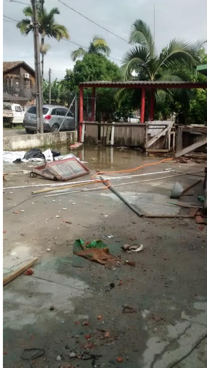
Figura 42: Sujeira no e acúmulo de água no pátio. (Fonte: Dos autores 2016)
