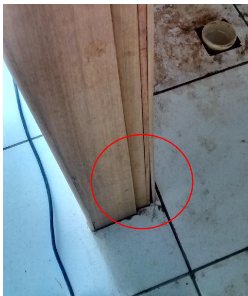
Figura 36: Vista de porta empenada. (Fonte: Dos autores 2016)
