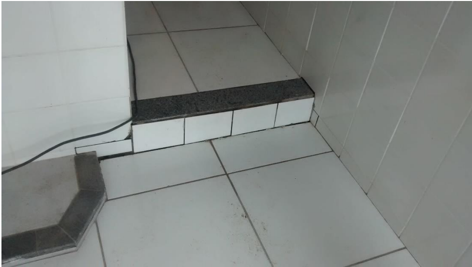
Figura 33: Pisos a serem retrabalhados. (Fonte: Dos autores 2016)
