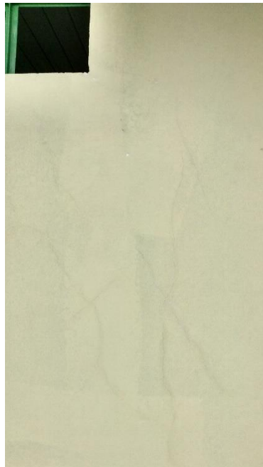
Figura 28: Retrabalho realizado em uma das fissuras. (Fonte: Dos autores 2016)
