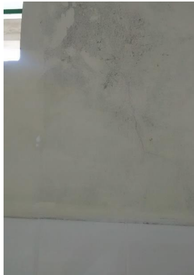
Figura 27: Retrabalho realizado em uma das fissuras. (Fonte: Dos autores 2016)
