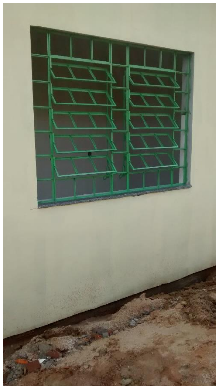
Figura 44: Areia retirada. (Fonte: Dos autores 2016)
