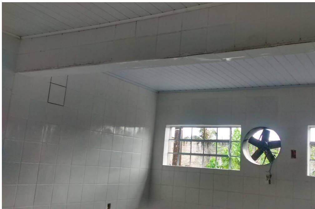
Figura 14: Cozinha internamente. (Fonte: Dos autores 2016)
