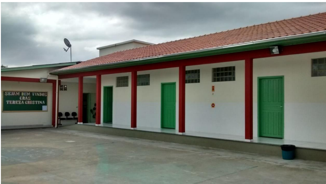
Figura 04: Fachada frontal do prédio. (Fonte: Dos autores 2016)
