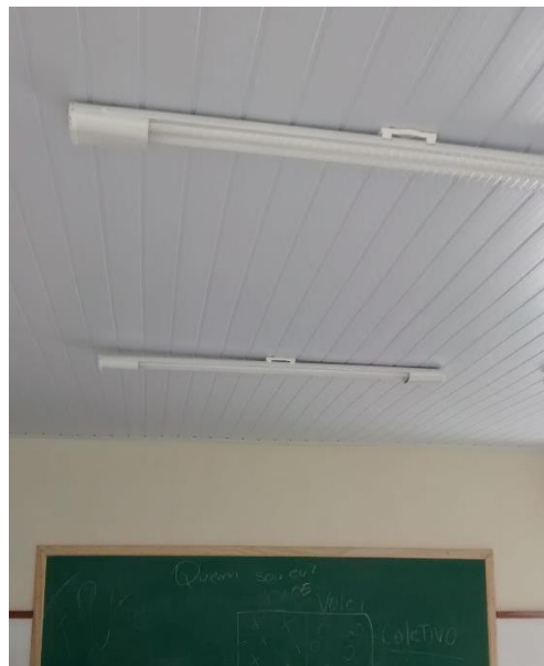
Figura 14: Instalação elétrica realizada. (Fonte: Dos autores 2016)
