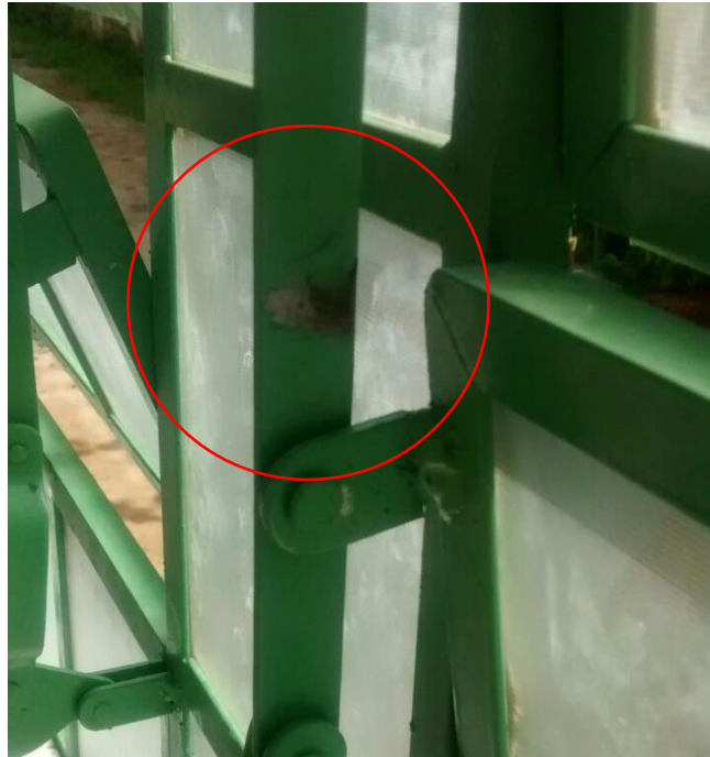
Figura 45: Pintura danificada com o funcionamento da esquadria. (Fonte: Dos autores 2016)
