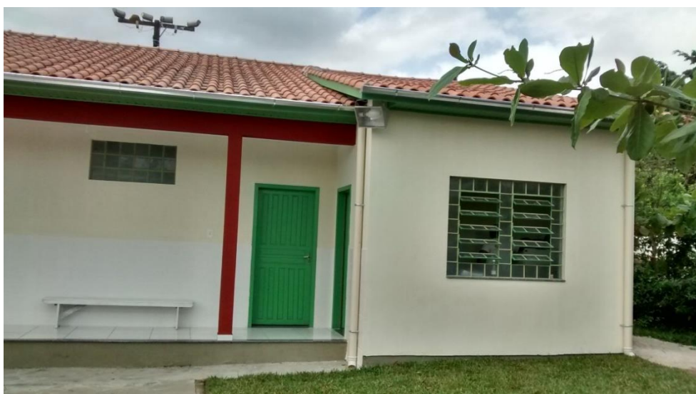
Figura 06: Pintura realizada na fachada frontal do prédio. (Fonte: Dos autores 2016)
