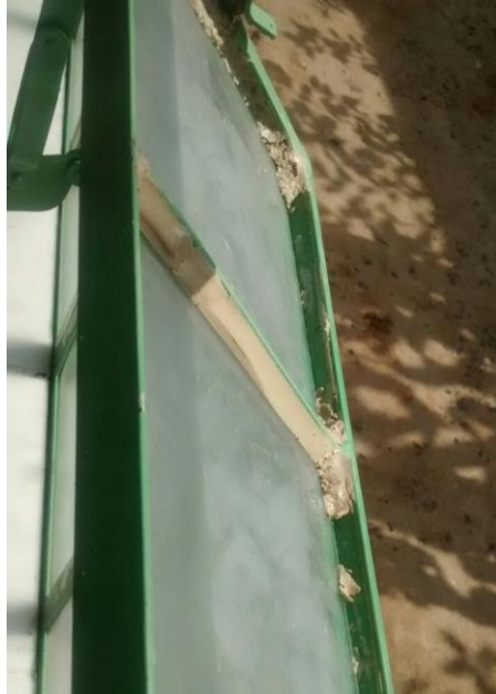
Figura 55: Rejunte dos vidros retirado por ação de vândalos. (Fonte: Dos autores 2016)
