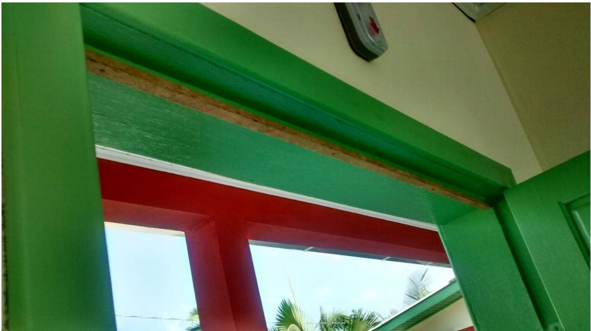
Figura 23: Madeiras instaladas na porta. (Fonte: Dos autores 2016)
