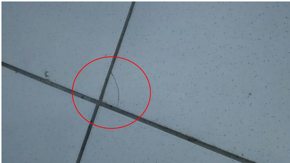
Figura 48: Piso danificado. (Fonte: Dos autores 2016)
