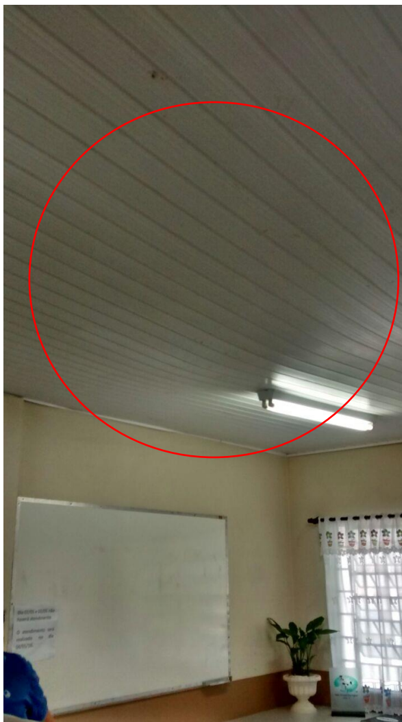
Figura 63: Forro PVC refeiteiro com rebaixo. (Fonte: Dos autores 2016)
