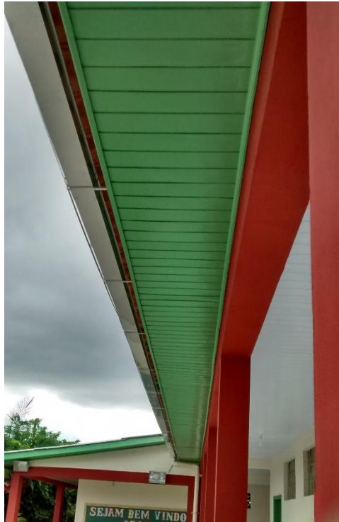
Figura 09: Pintura realizada nos beirais. (Fonte: Dos autores 2016)
