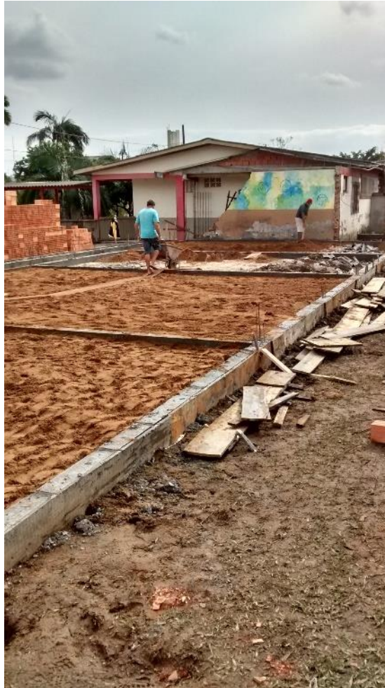
Figura 5: Aterramento das vigas de baldrame. (Fonte: Dos autores 2015)
