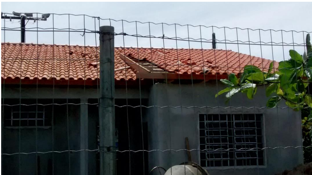
Figura 9: Telhado com elevação sobre o depósito. (Fonte: Dos autores 2015)
