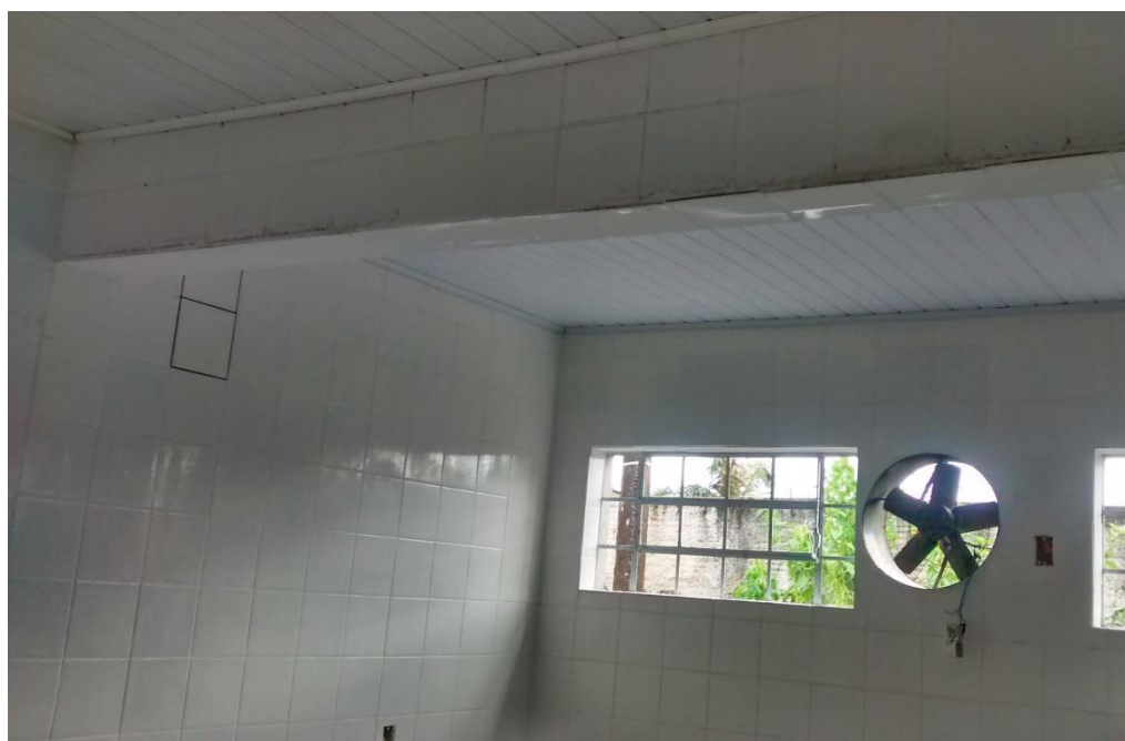
Figura 15: Cozinha internamente. (Fonte: Dos autores 2016)
