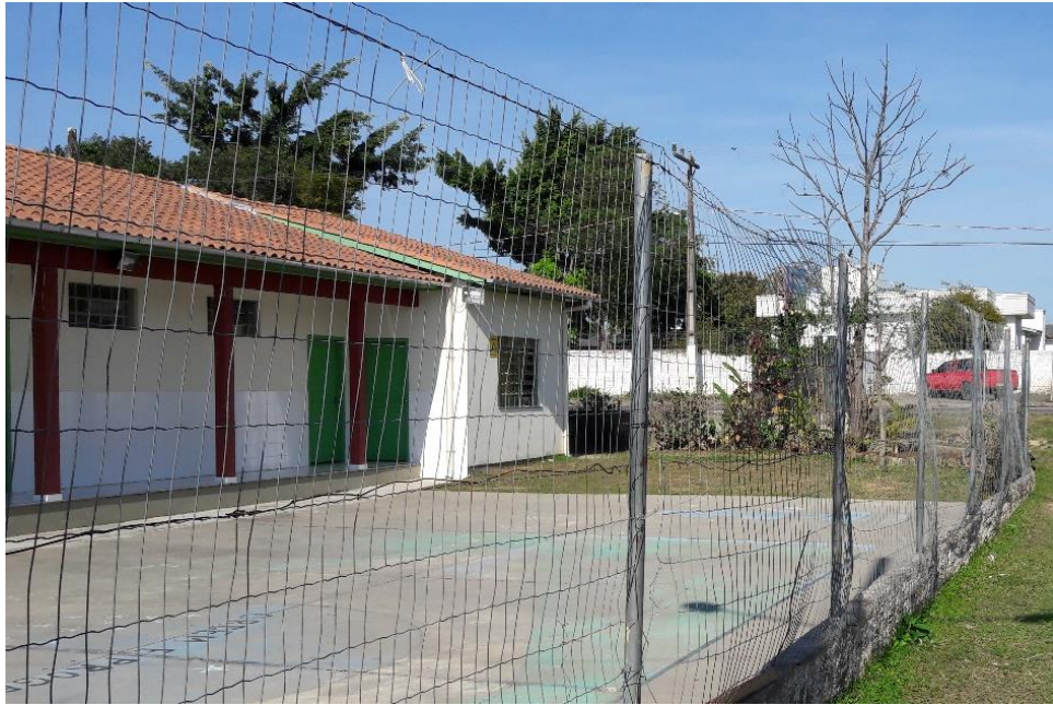
Figura 19: Muro de tela da parte frontal do CRAS. (Fonte: Dos Autores).
