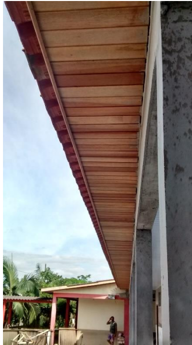
Figura 10: Beiral em madeira. (Fonte: Dos autores 2015)
