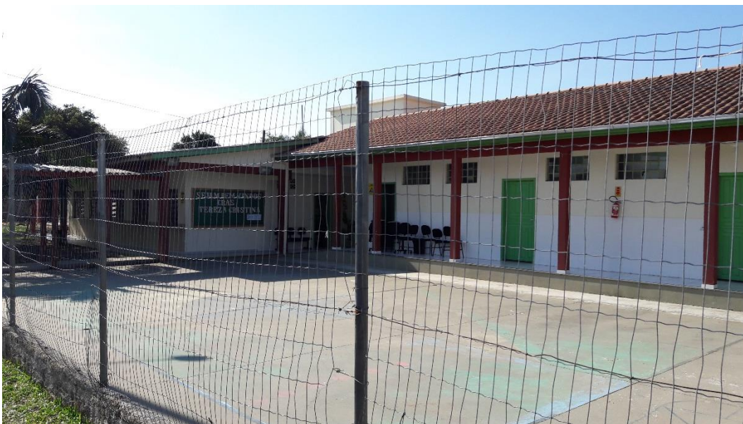
Figura 2: Vista parte frontal do CRAS (Fonte: Autores)
