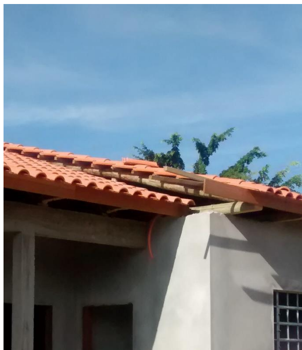
Figura 7: Detalhe da elevação da cobertura sobre o depósito. (Fonte: Dos autores 2015)
