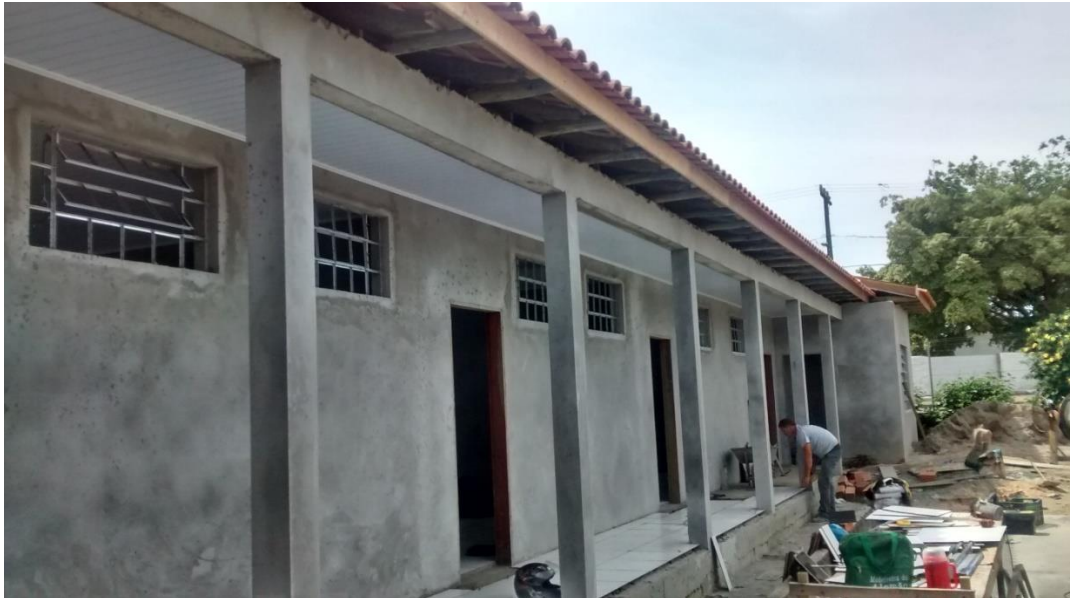
Figura 8: Corredor acesso as salas de aula e ao depósito. (Fonte: Dos autores 2015)
