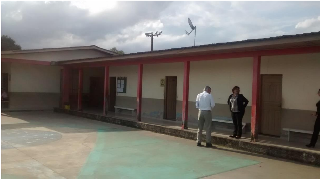
Figura 3: Pátio e área do CRAS a ser ampliada (Fonte: Autores 2015).
