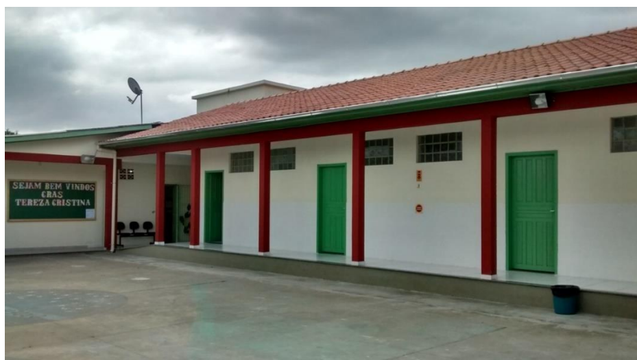
Figura 17: Fachada frontal do prédio. (Fonte: Dos autores 2016)
