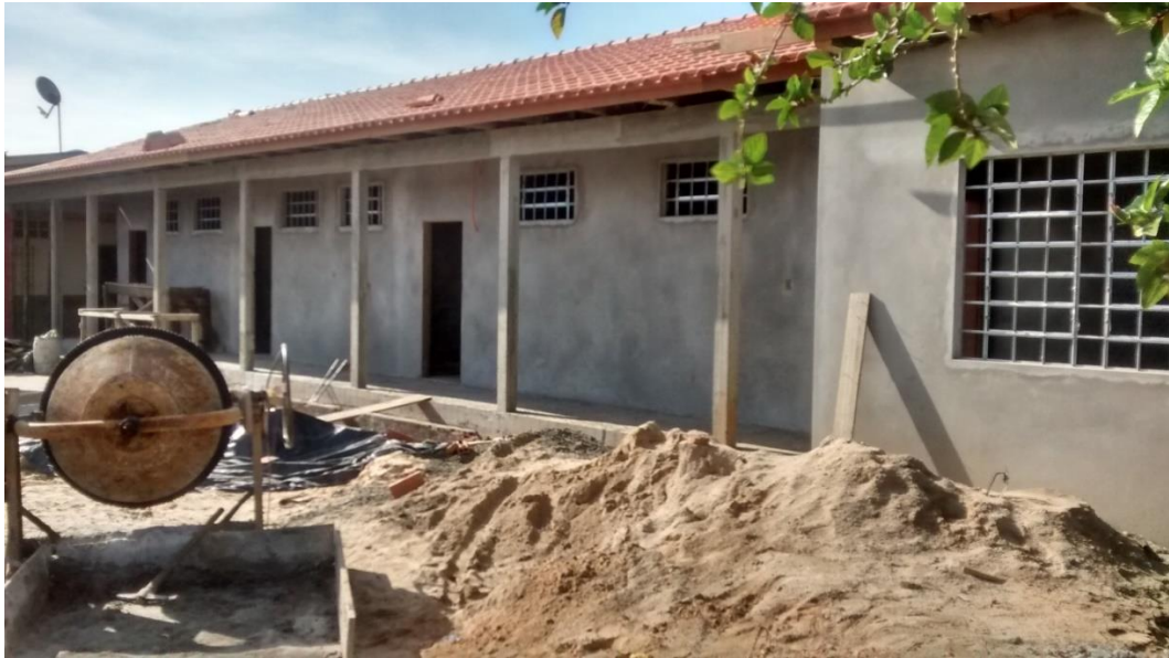
Figura 6: Fachada frontal do CRAS. (Fonte: Dos autores 2015)
