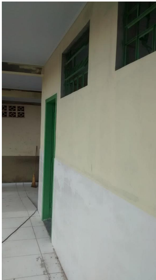
Figura 14: Execução da pintura nas portas, esquadrias e paredes. (Fonte: Dos autores 2016)
