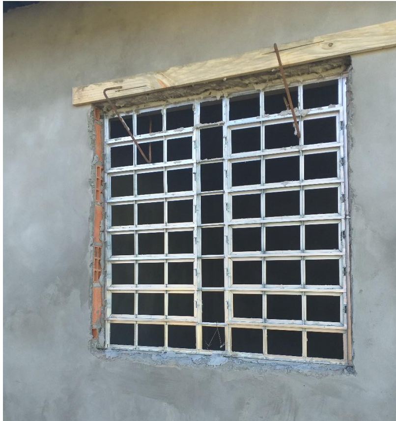
Figura 14: Esquadria fixada. (Fonte: Dos Autores 2019)
