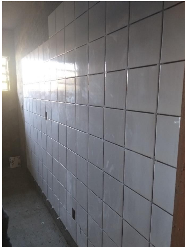
Figura 21: Revestimento cerâmico em processo de instalação. (Fonte: Dos Autores 2019)
