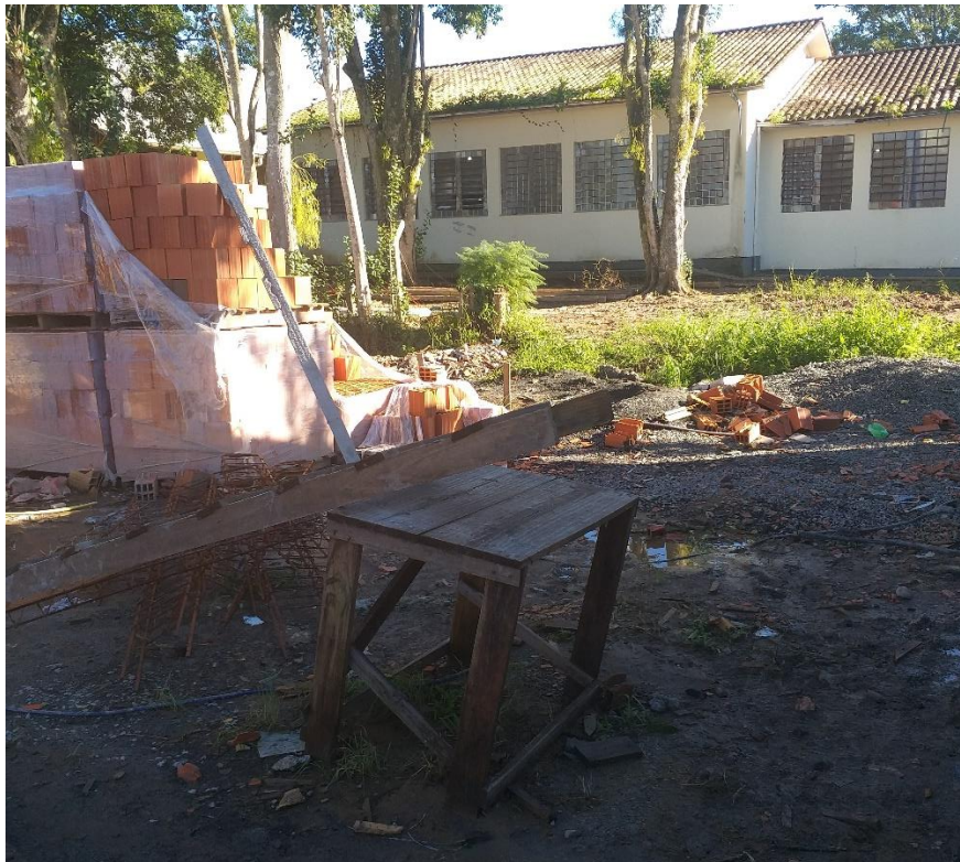
Figura 36: Canteiro de obras. (Fonte: Dos Autores 2019)
