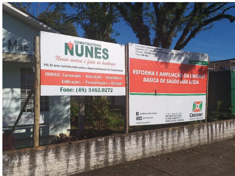
Figura 4: Placa de identificação da obra UBS Mãe Luzia em execução. (Fonte: Dos Autores 2019)
