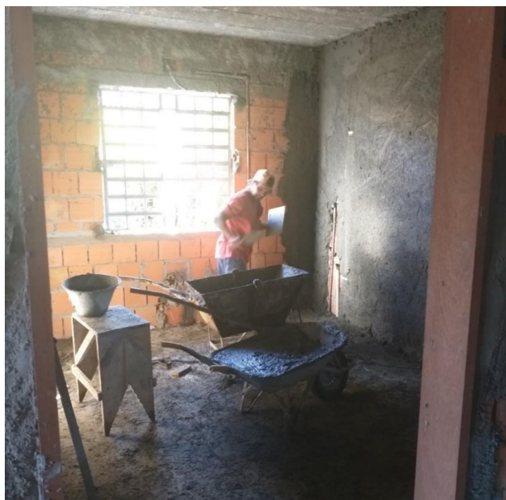
Figura 20: Trabalhador fazendo revestimento vertical da parede. (Fonte: Dos Autores 2019)
