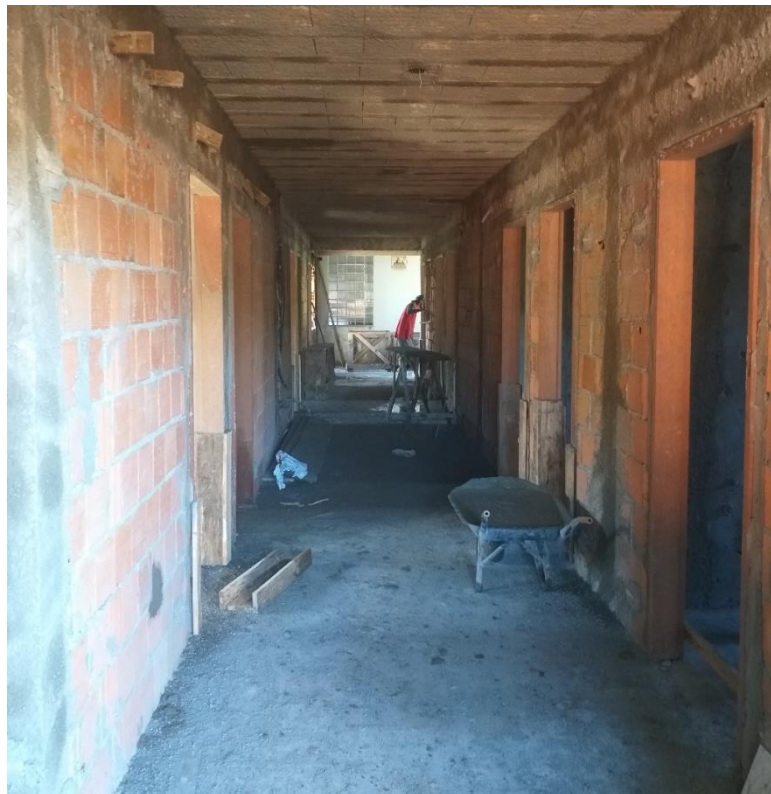
Figura 17: Corredor de acesso. (Fonte: Dos Autores 2019)
