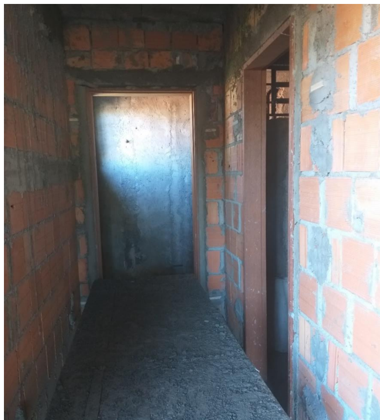
Figura 18: Marco das portas instalados. (Fonte: Dos Autores 2019)
