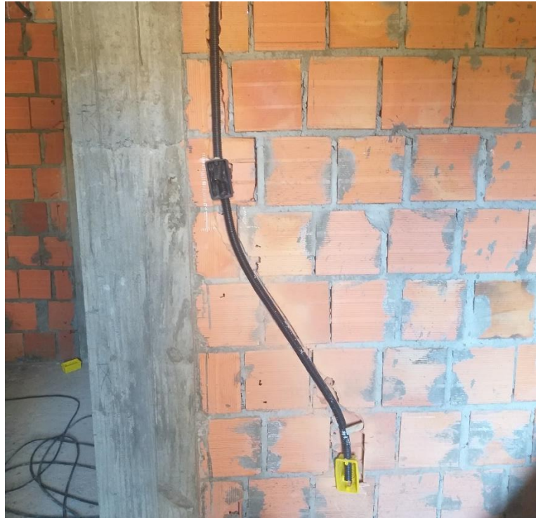
Figura 28: Eletroduto e caixa de luz. (Fonte: Dos Autores 2019)
