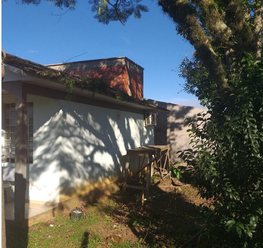
Figura 13: Estrutura para caixa d'água. (Fonte: Dos Autores 2019)
