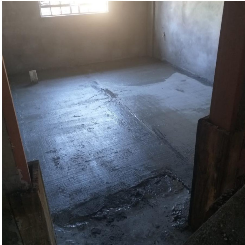
Figura 25: Concretagem. (Fonte: Dos Autores 2019)
