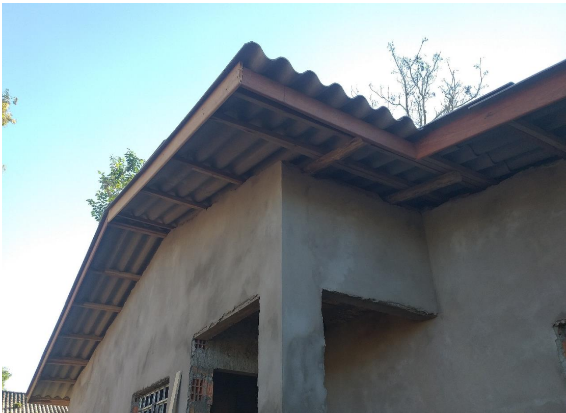
Figura 10: Etapa de execução da cobertura. (Fonte: Dos Autores 2019)
