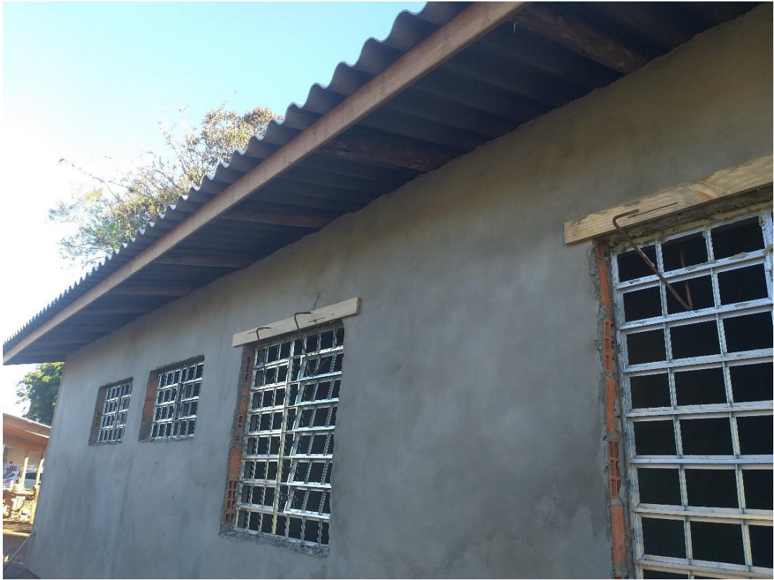
Figura 9: Etapa de execução da cobertura. (Fonte: Dos Autores 2019)
