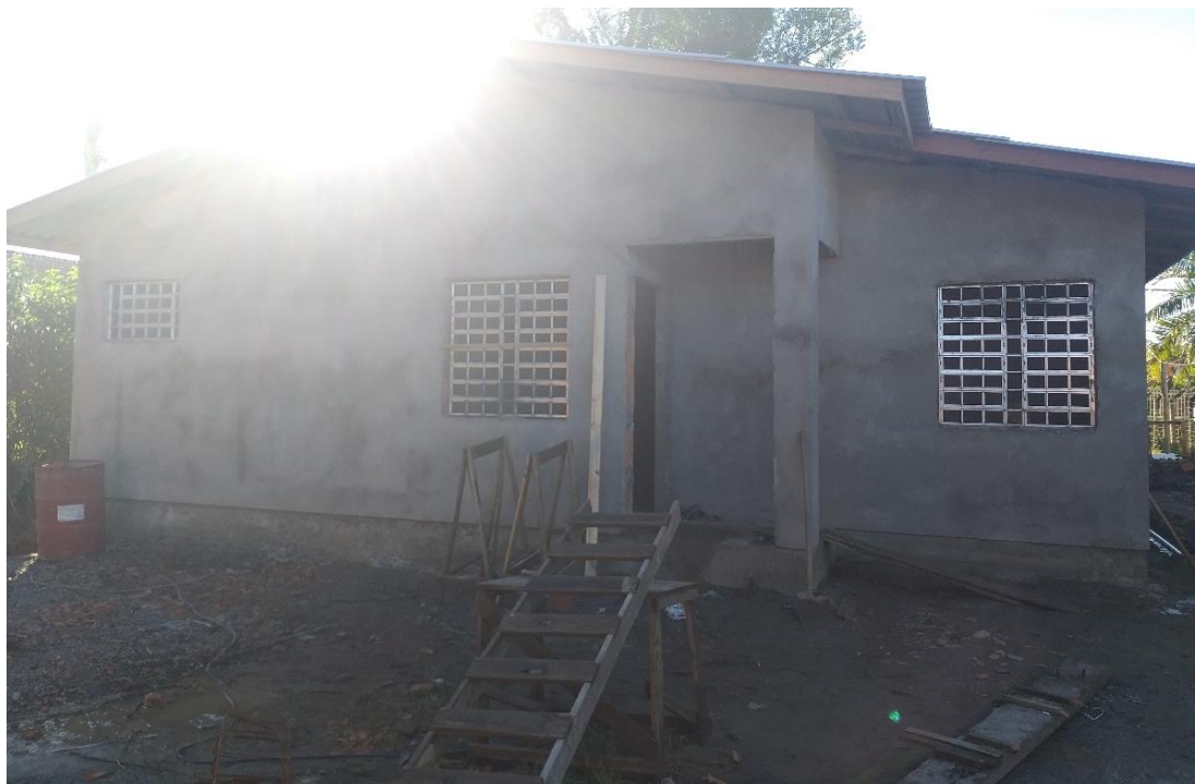
Figura 7: Fachada posterior da UBS Mãe Luzia. (Fonte: Dos Autores 2019)
