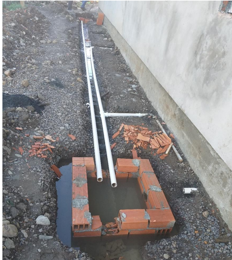
Figura 16: Caixas de inspeção e encanamento em construção. (Fonte: Dos Autores 2019)
