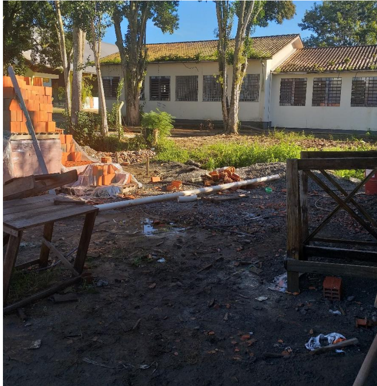
Figura 39: Canteiro de obras. (Fonte: Dos Autores 2019)
