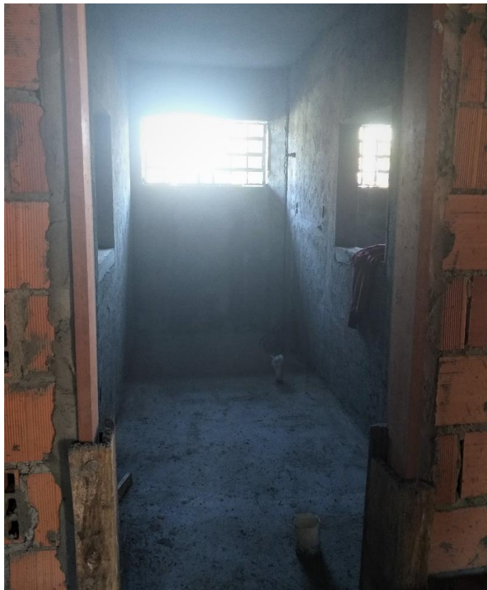
Figura 24: Sala de utilidades. (Fonte: Dos Autores 2019)
