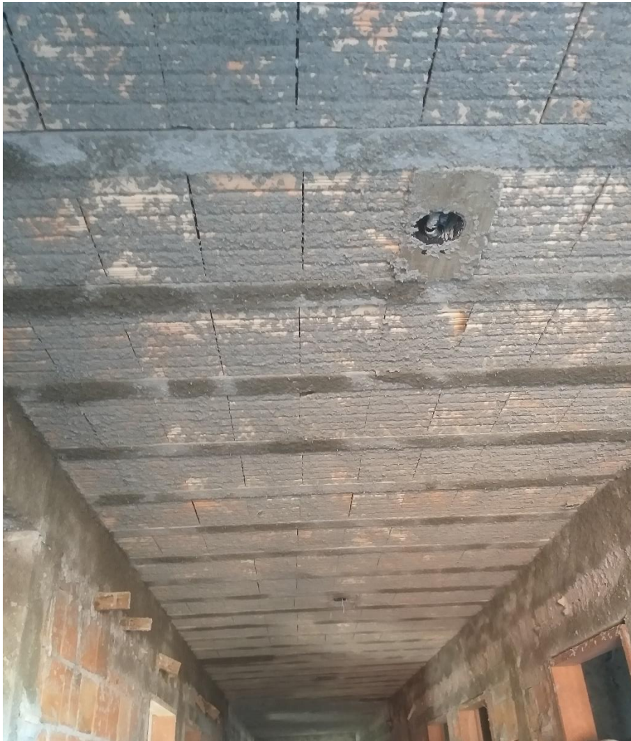
Figura 8: Etapa da laje pré-moldada concluída. (Fonte: Dos Autores 2019)
