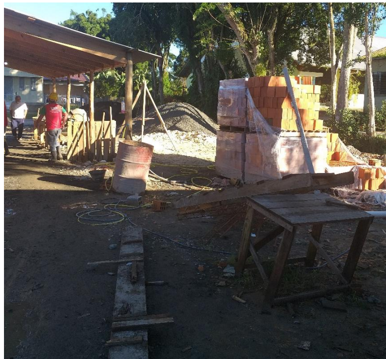
Figura 38: Canteiro de obras. (Fonte: Dos Autores 2019)
