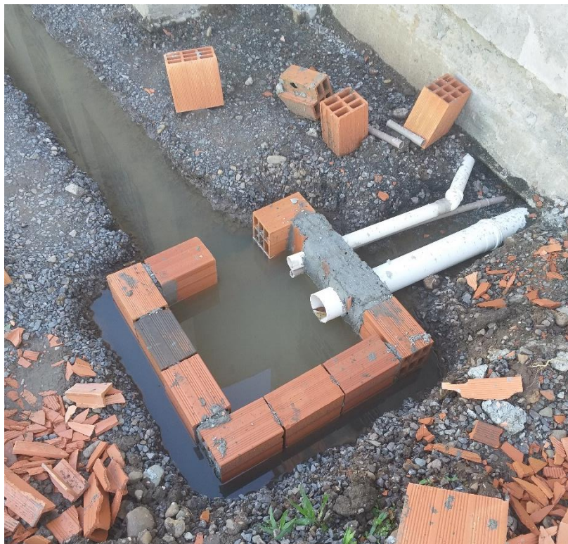
Figura 15: Caixa de inspeção em construção. (Fonte: Dos Autores 2019)
