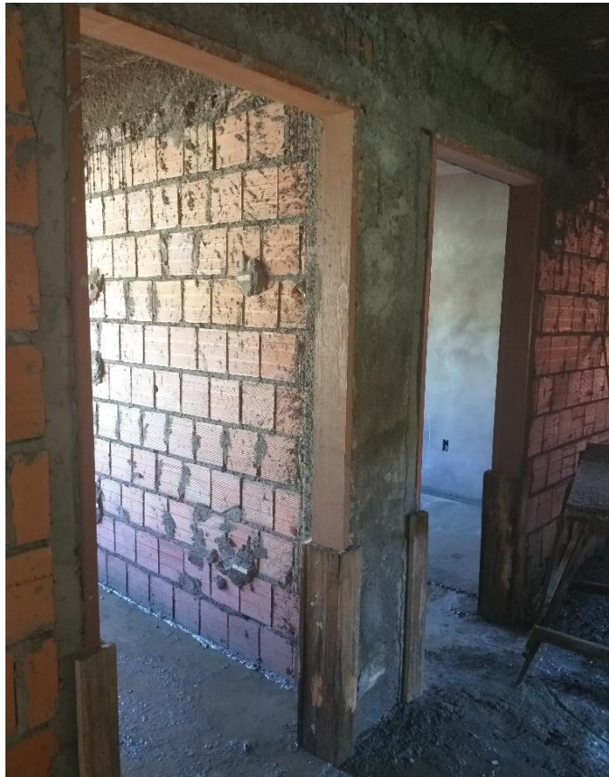
Figura 19: Marco das portas instalados. (Fonte: Dos Autores 2019)
