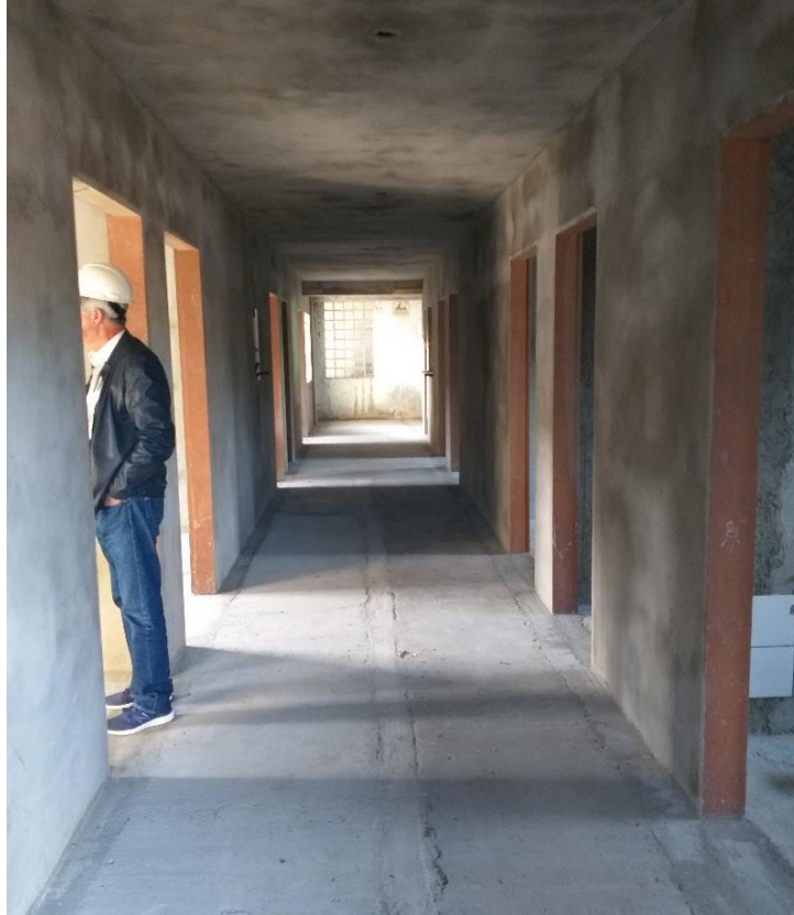
Figura 15: Corredor de acesso. (Fonte: Dos Autores 2019)
