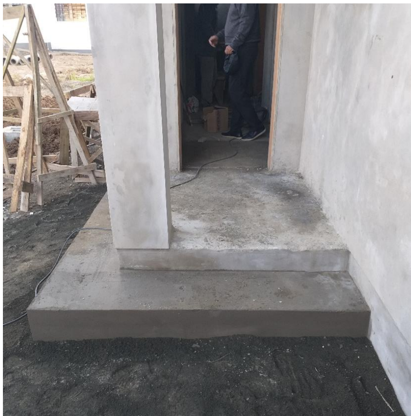
Figura 14: Degrau da entrada posterior para funcionários. (Fonte: Dos Autores 2019)
