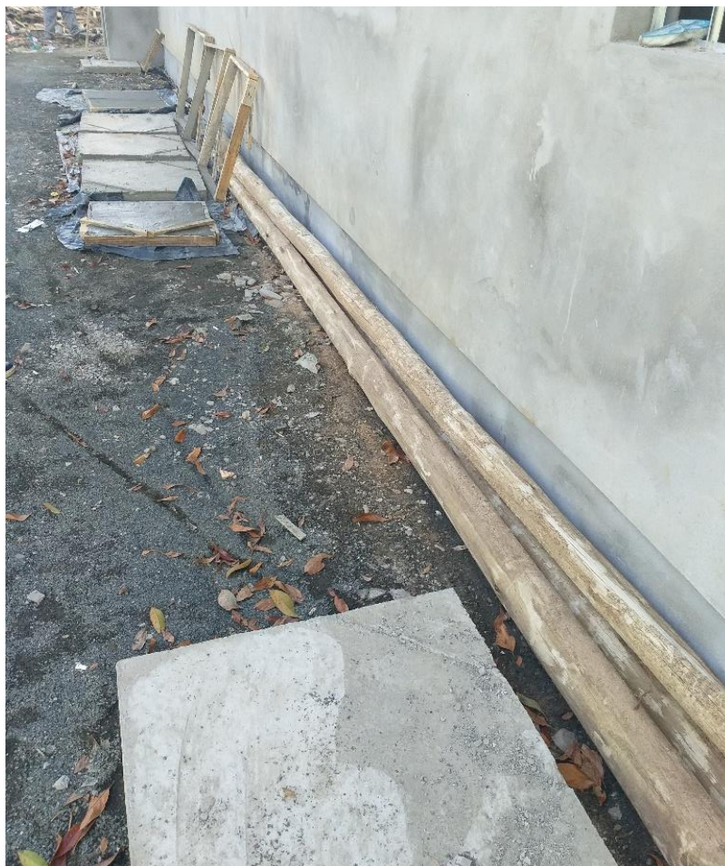
Figura 11: Caixas de inspeção finalizadas. (Fonte: Dos Autores 2019)
