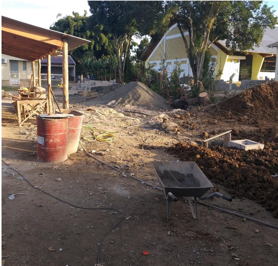
Figura 32: Canteiro de obras. (Fonte: Dos Autores 2019)
