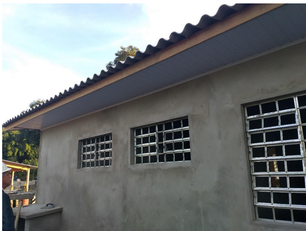
Figura 8: Cobertura finalizada. (Fonte: Dos Autores 2019)
