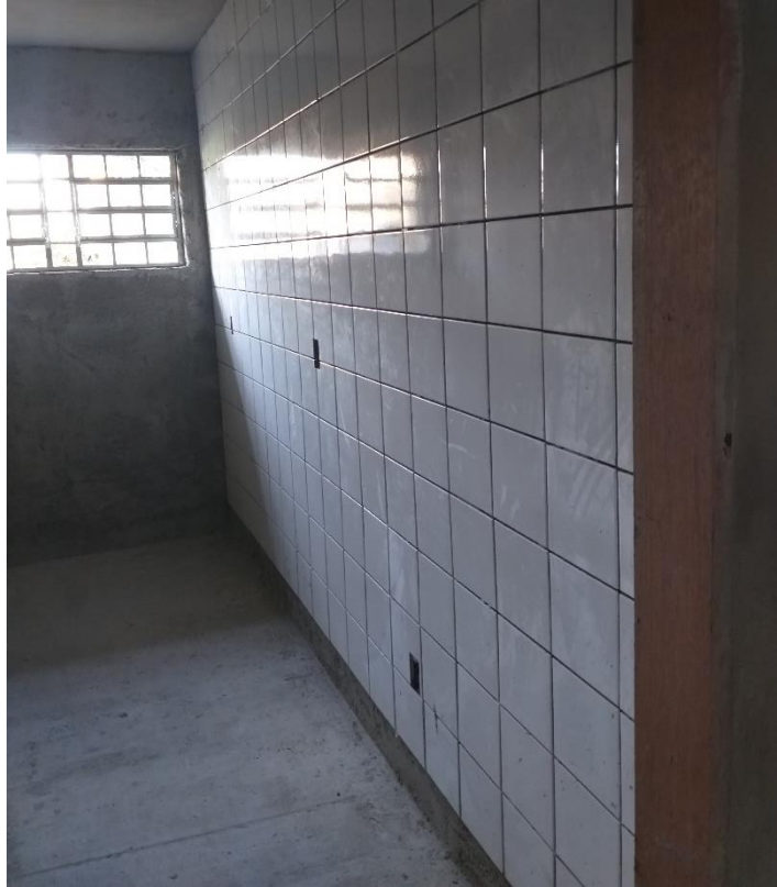
Figura 19: Etapa de colocação dos pisos. (Fonte: Dos Autores 2019)
