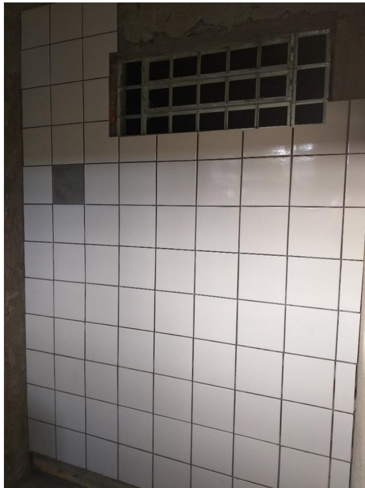
Figura 25: Etapa de colocação dos pisos. (Fonte: Dos Autores 2019)
