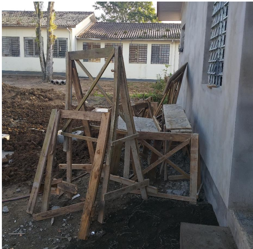
Figura 30: Canteiro de obras. (Fonte: Dos Autores 2019)
