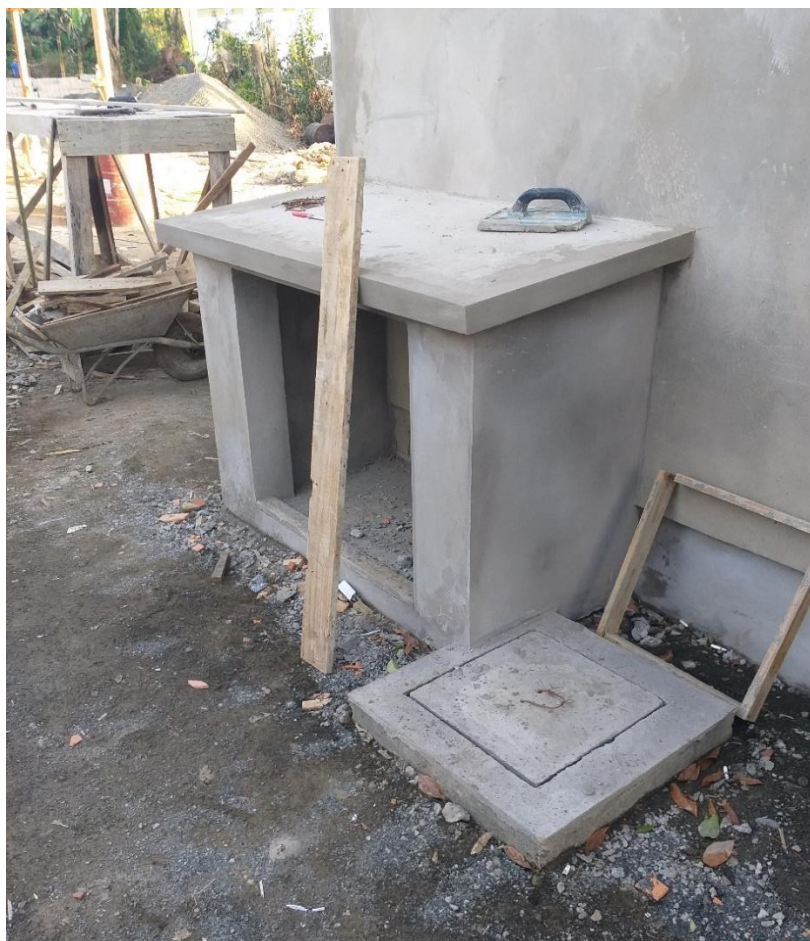
Figura 13: Estrutura. (Fonte: Dos Autores 2019)
