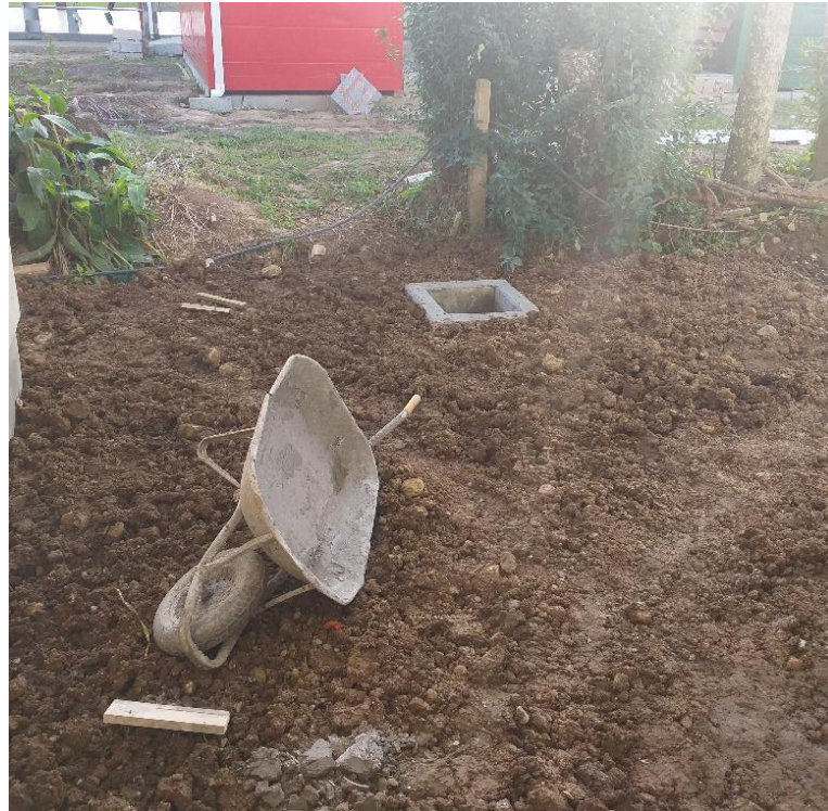
Figura 28: Esgoto tapado. (Fonte: Dos Autores 2019)
