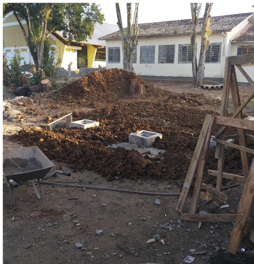
Figura 31: Canteiro de obras. (Fonte: Dos Autores 2019)
