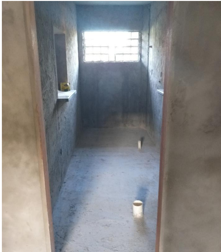
Figura 20: Sala de utilidades. (Fonte: Dos Autores 2019)
