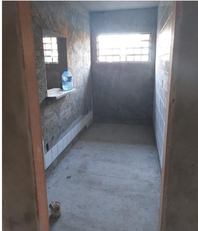
Figura 17: Sala de esterilização. (Fonte: Dos Autores 2019)
