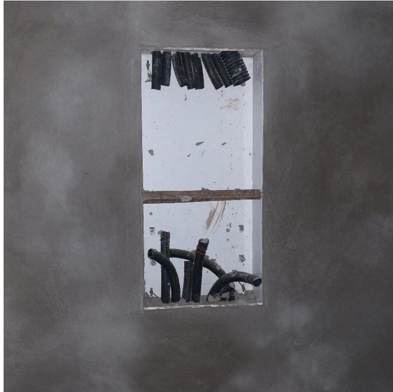
Figura 21: Caixa de energia em processo de preparação. (Fonte: Dos Autores 2019)
