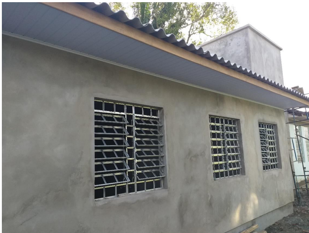
Figura 7: Cobertura finalizada. (Fonte: Dos Autores 2019)
