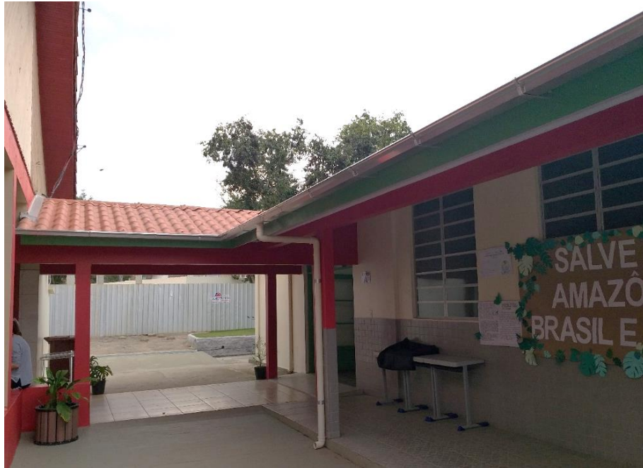
Figura 10: Reforma do Bloco A. (Fonte: Dos Autores 2019)
