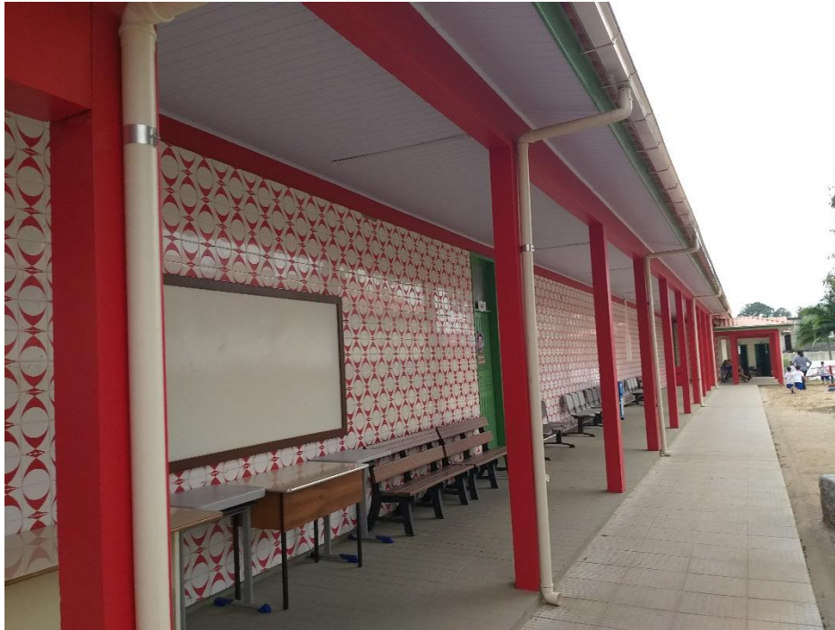
Figura 16: Reforma no Bloco B. (Fonte: Dos Autores 2019)
