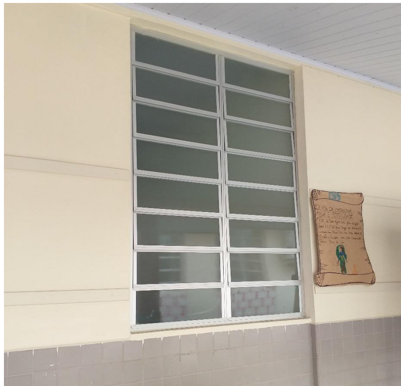
Figura 13: Janela de alumínio nova no Bloco A. (Fonte: Dos Autores 2019)
