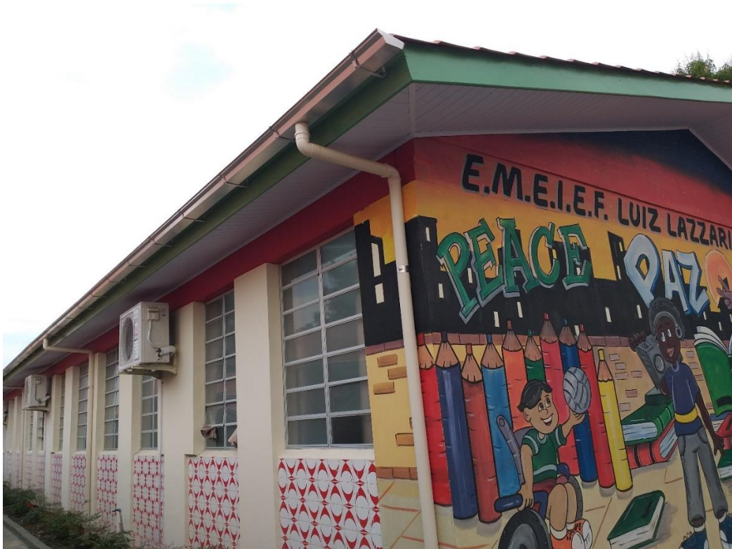
Figura 15: Bloco B com beiral, tubo de escoamento, calha, ares-condicionados, janelas e pintura nova. (Fonte: Dos Autores 2019)
