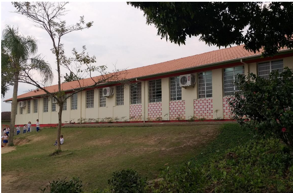
Figura 19: Reforma no Bloco C. (Fonte: Dos Autores 2019)
