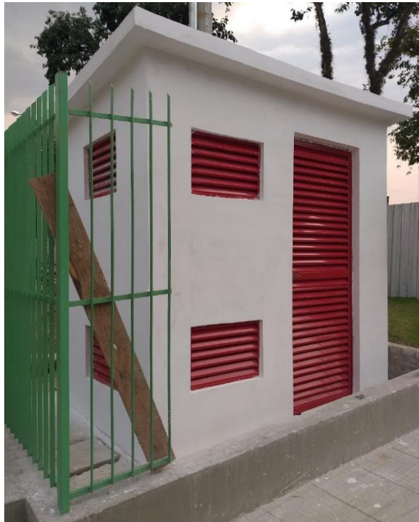
Figura 8: Subestação. (Fonte: Dos Autores 2019)
