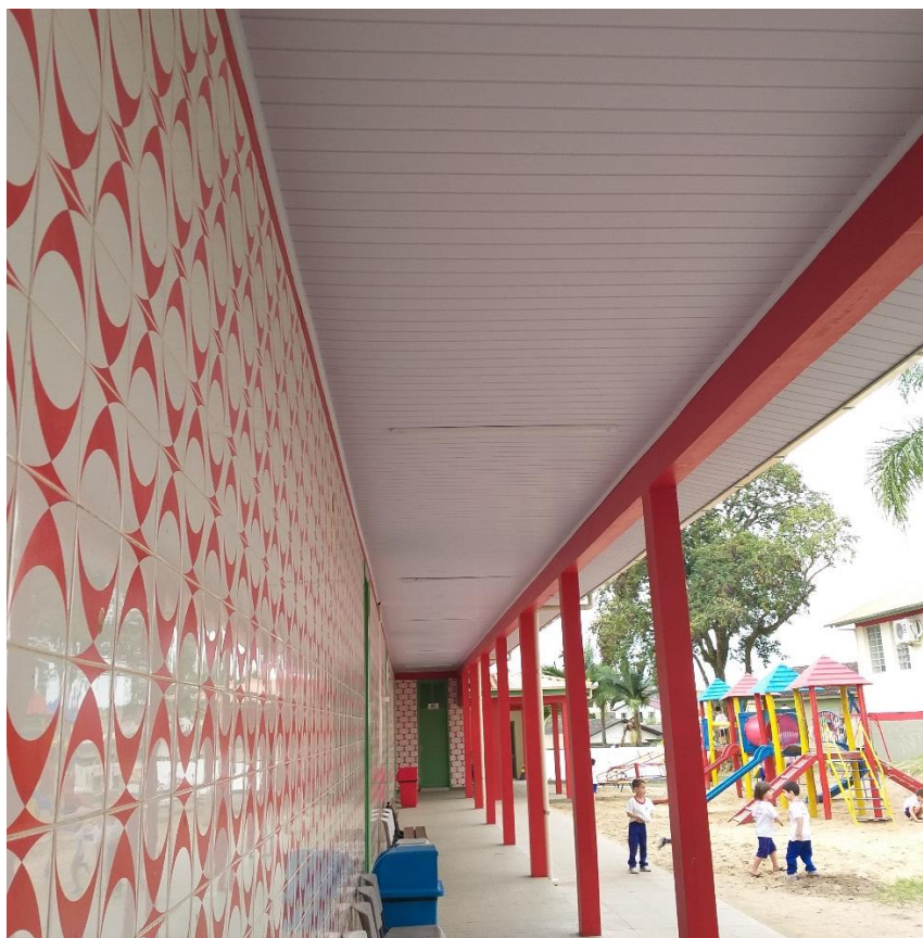
Figura 17: Forro novo de PVC Bloco B. (Fonte: Dos Autores 2019)
