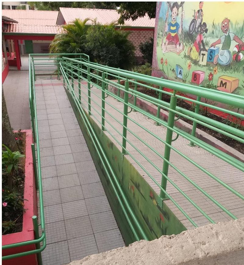
Figura 20: Rampa de acesso ao Bloco C. (Fonte: Dos Autores 2019)
