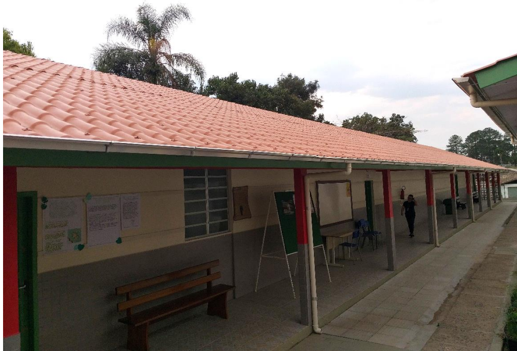
Figura 12: Telhado novo de PVC PRECONV no Bloco A. (Fonte: Dos Autores 2019)
