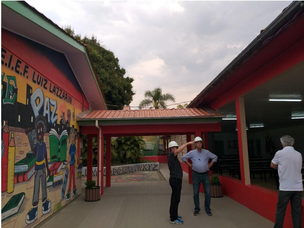
Figura 14: Passarela reformada de encontro ao bloco B para o D. (Fonte: Dos Autores 2019)
