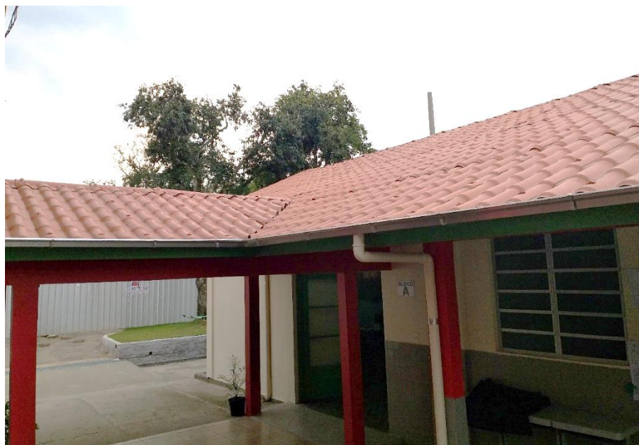
Figura 11: Telhado novo de PVC PRECONV no Bloco A. (Fonte: Dos Autores 2019)
