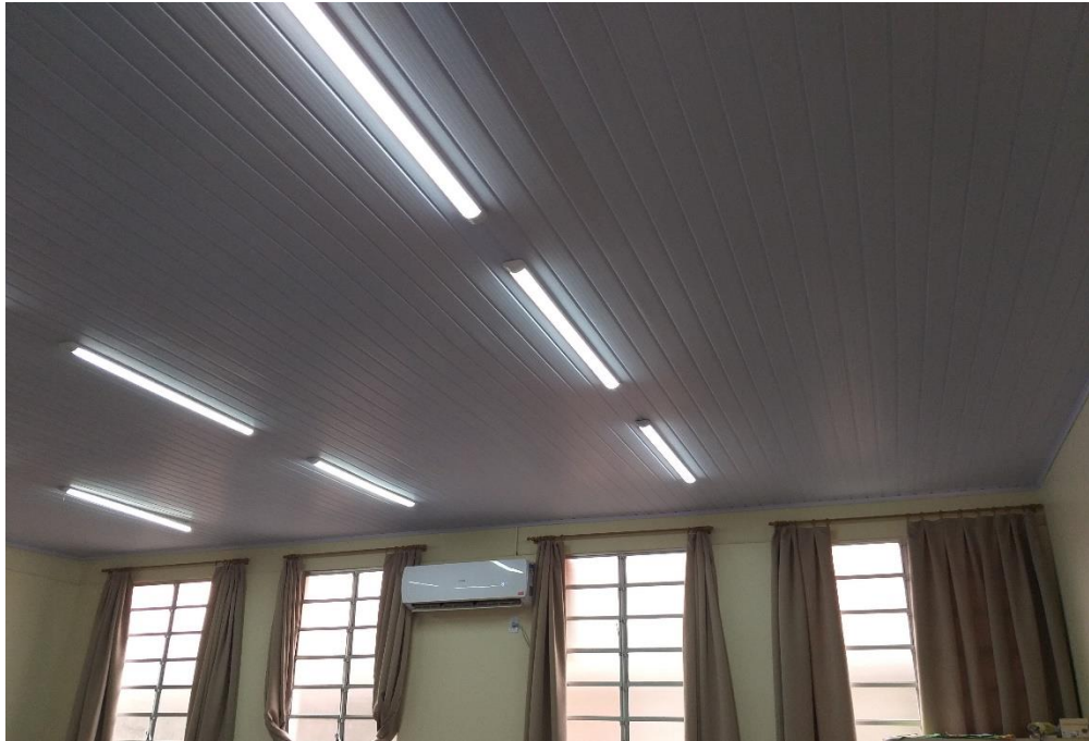
Figura 18: Reforma em sala de aula Bloco B. (Fonte: Dos Autores 2019)
