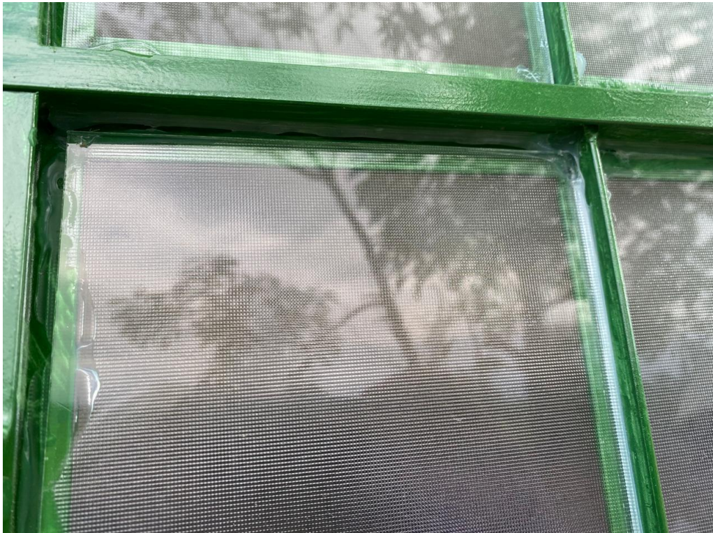
Figura 15: Acabamentos aplicados de forma incorreta. (Fonte: Dos Autores 2020).
