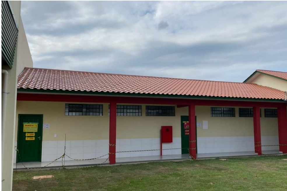
Figura 10: Cobertura e pintura finalizadas (Fonte: Dos Autores 2020).
