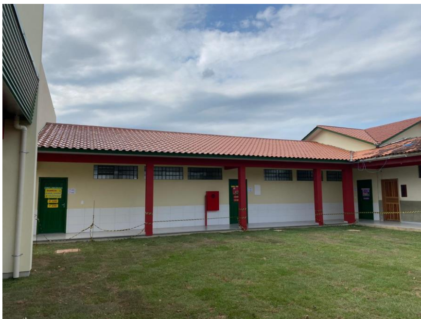
Figura 5: Parte interna da obra (Fonte: Dos Autores 2020).
