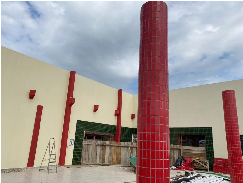
Figura 11: Cobertura a ser concluída. (Fonte: Dos Autores).
