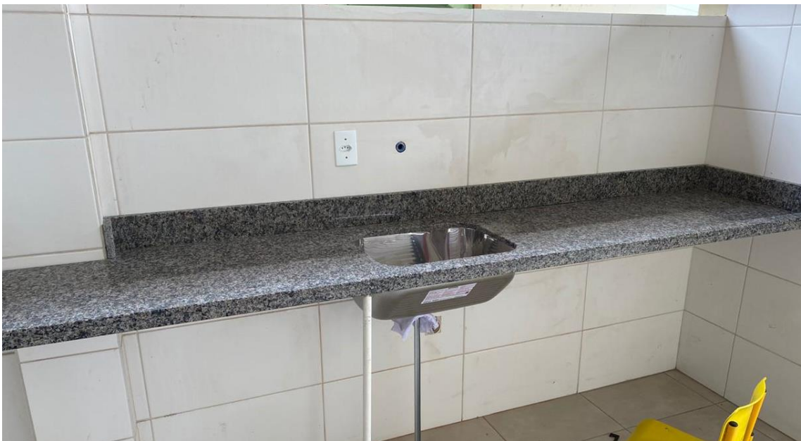
Figura 17: Cuba de granito instalada. (Fonte: Dos Autores 2020).
