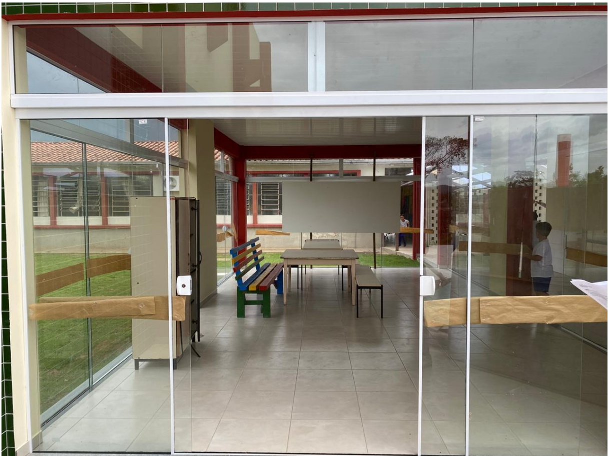
Figura 18: Refeitório concluído. (Fonte: Dos Autores).
