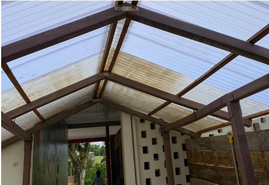
Figura 19: Estrutura de ligação (Fonte: Dos Autores).
