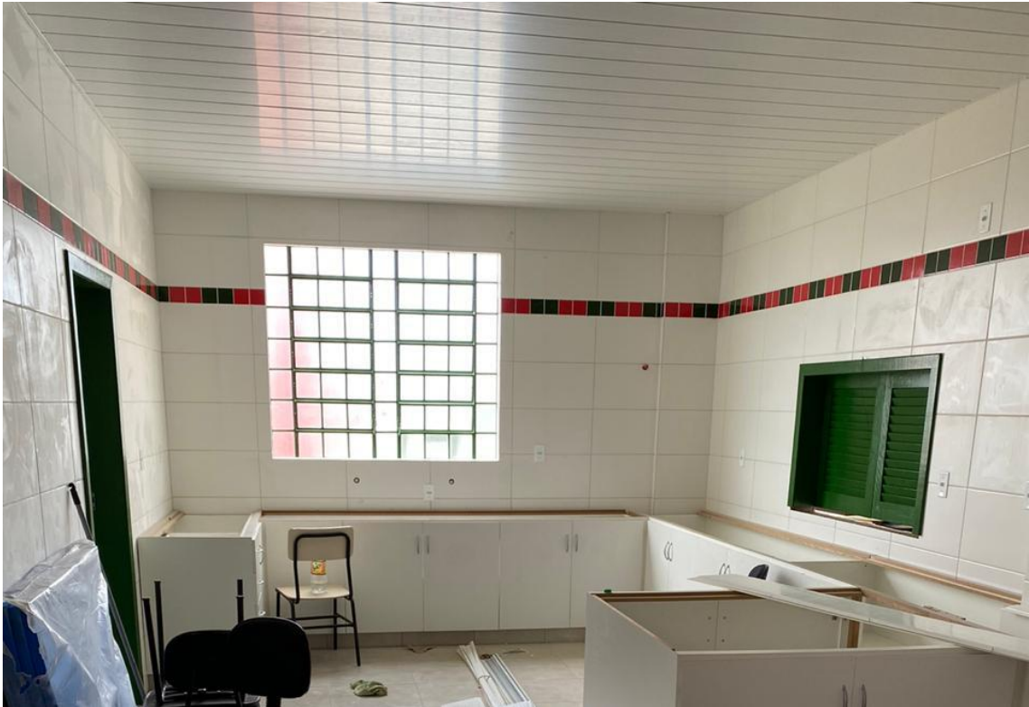
Figura 16: Cozinha da escola. (Fonte: Dos Autores 2020).
