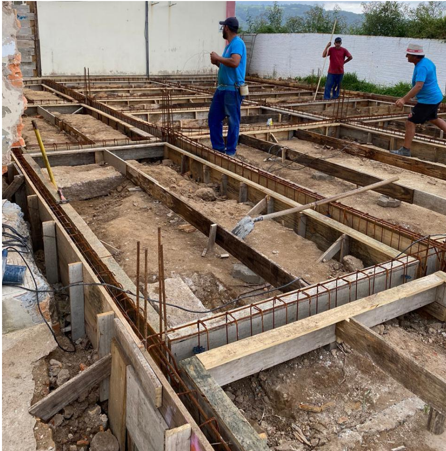
Figura 23: Execução de formas e armaduras (Fonte: Dos Autores 2020).
