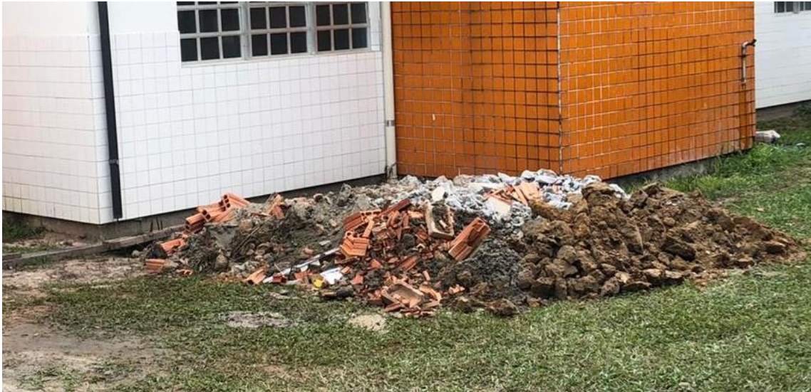
Figura 7: Entulho da obra descartado incorretamente (Fonte: Dos Autores 2020).
