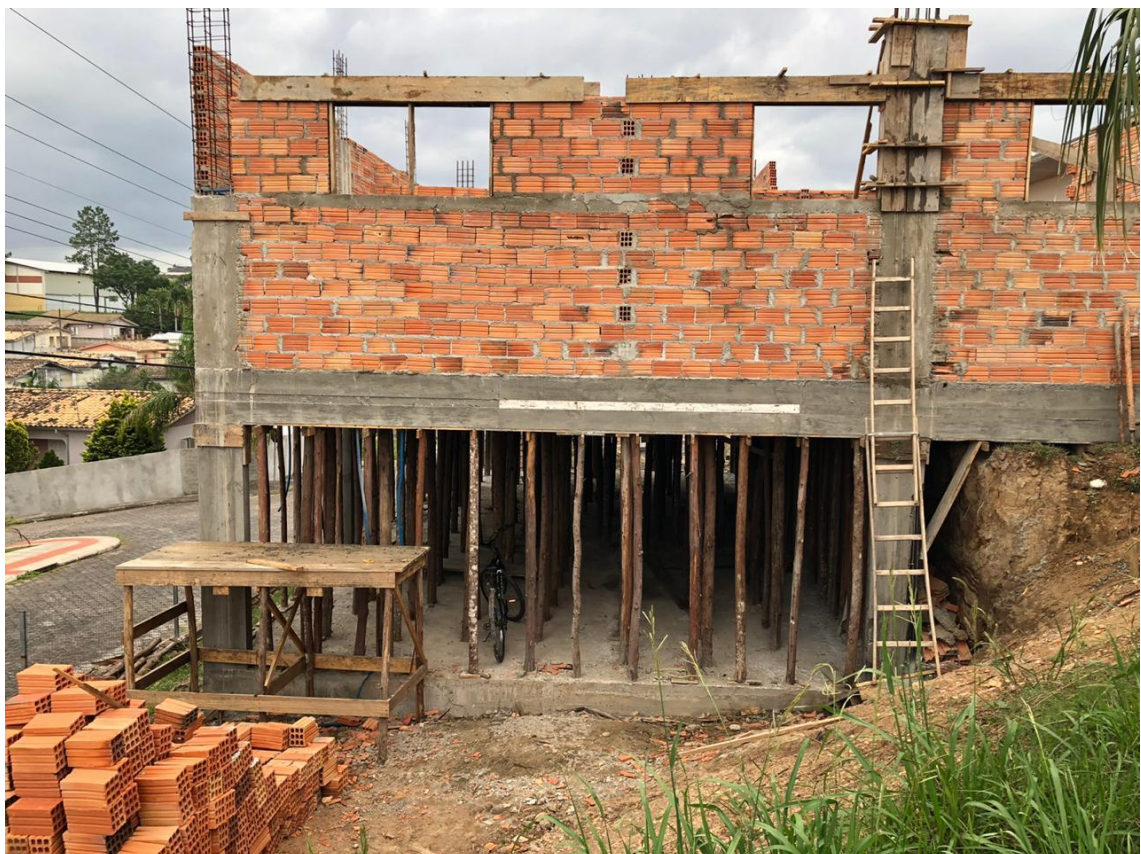
Figura 6: Fachada dos fundos em construção. (Fonte: Dos Autores 2020).
