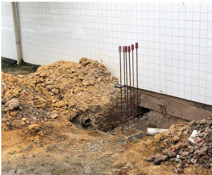
Figura 20: Início ampliação da sala (Fonte: Dos Autores 2020).
