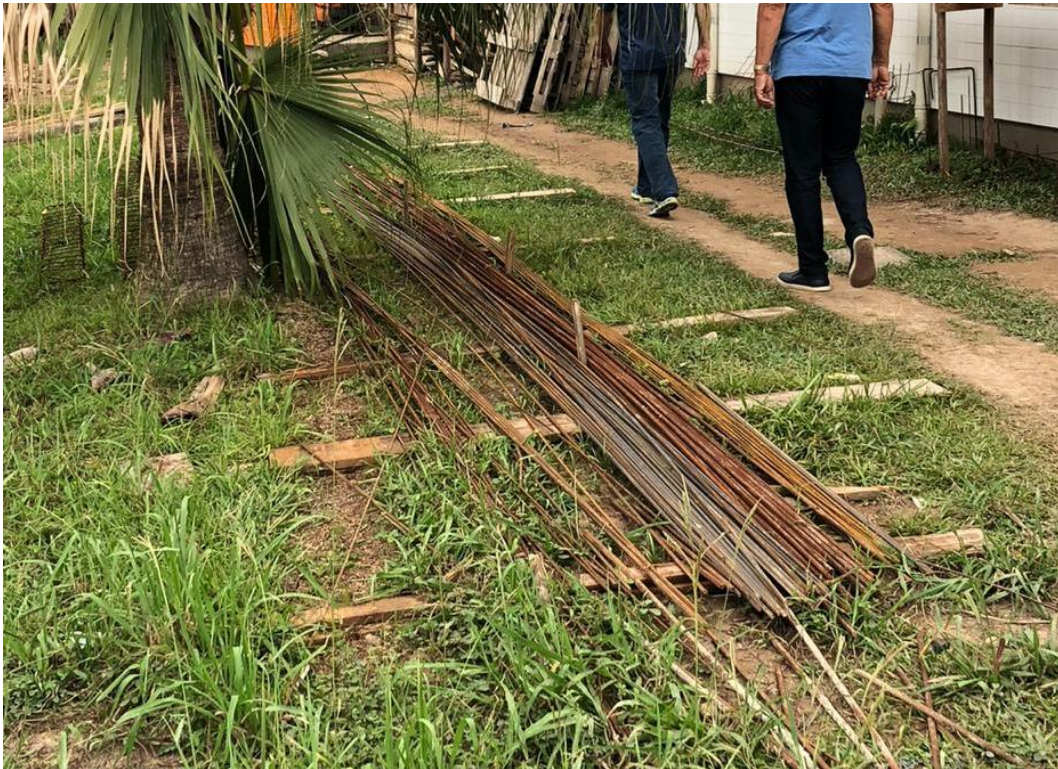
Figura 8: Ferragens para armação armazenadas corretamente (Fonte: Dos Autores 2020).
