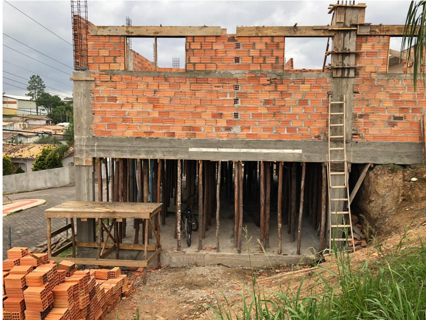
Figura 14: Parte dos fundos sendo construída (Fonte: Dos Autores 2020).
