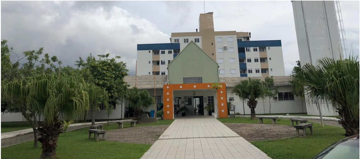
Figura 5: Fachada já existente. (Fonte: Dos Autores 2020).
