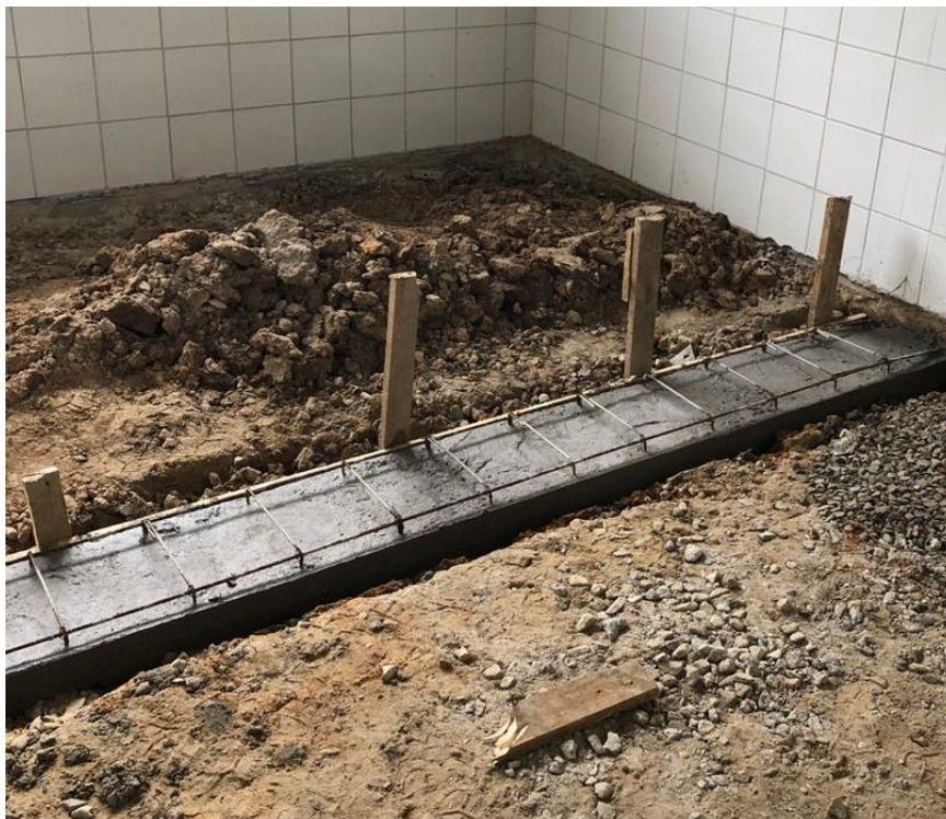
Figura 17: Viga de reforço para paredes (Fonte: Dos Autores 2020).
