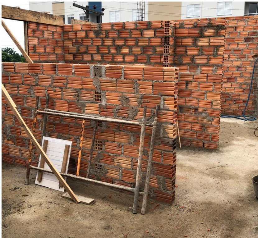
Figura 15: Paredes sendo construídas nos fundos (Fonte: Dos Autores 2020).
