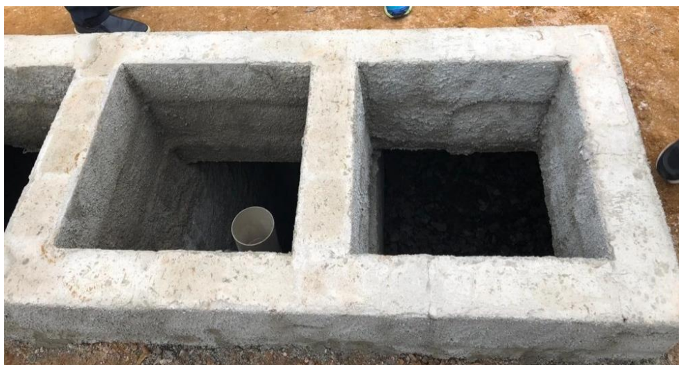
Figura 12: Caixas sépticas já construídas (Fonte: Dos Autores 2020).
