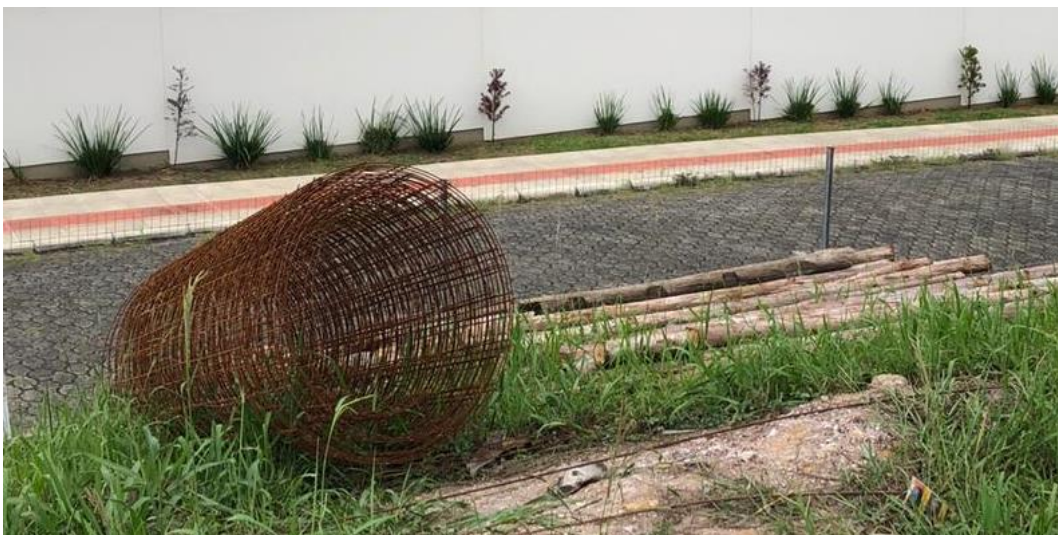
Figura 9: Ferragens para armação armazenadas incorretamente (Fonte: Dos Autores 2020).
