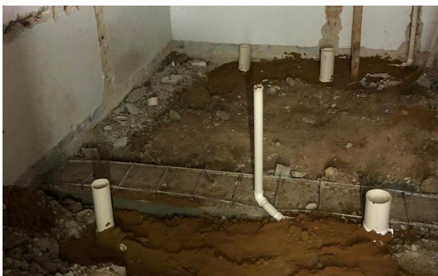
Figura 18: Viga de reforço para paredes (Fonte: Dos Autores 2020).
