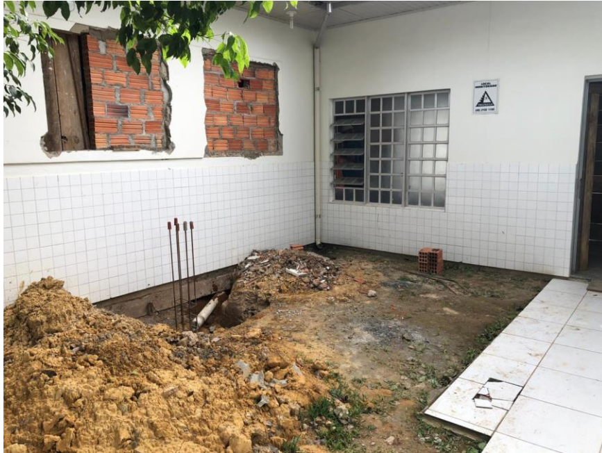
Figura 19: Início ampliação da sala (Fonte: Dos Autores 2020).
