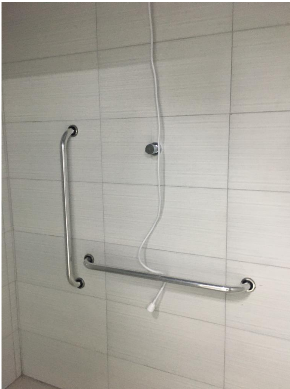
Figura 28: Banheiro acessível. (Fonte: Dos Autores 2020).
