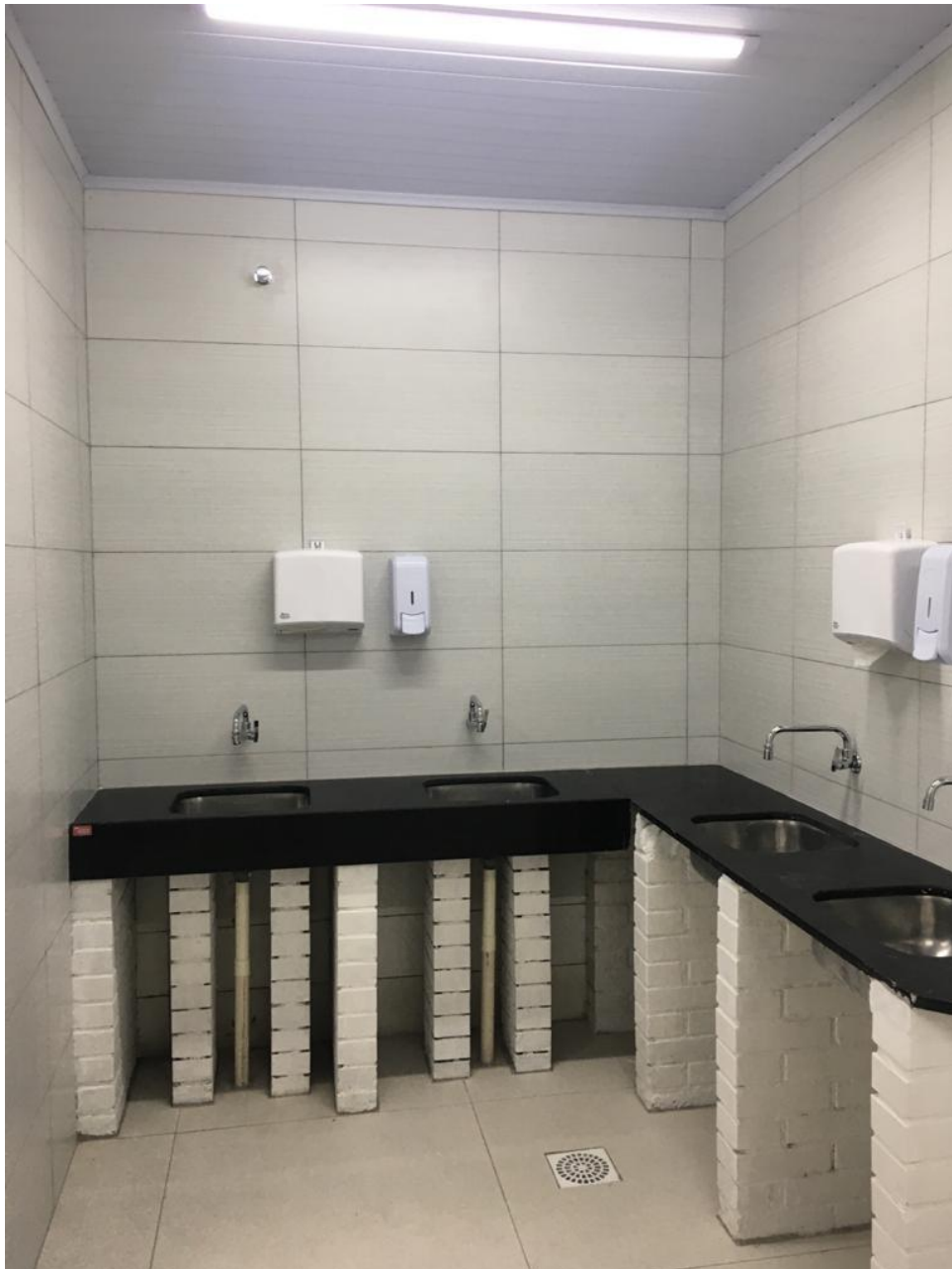
Figura 25: Paredes do banheiro revestidas. (Fonte: dos Autores 2020).
