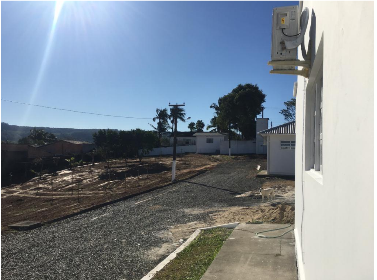
Figura 38: Terreno tratado. (Fonte: Dos Autores 2020).
