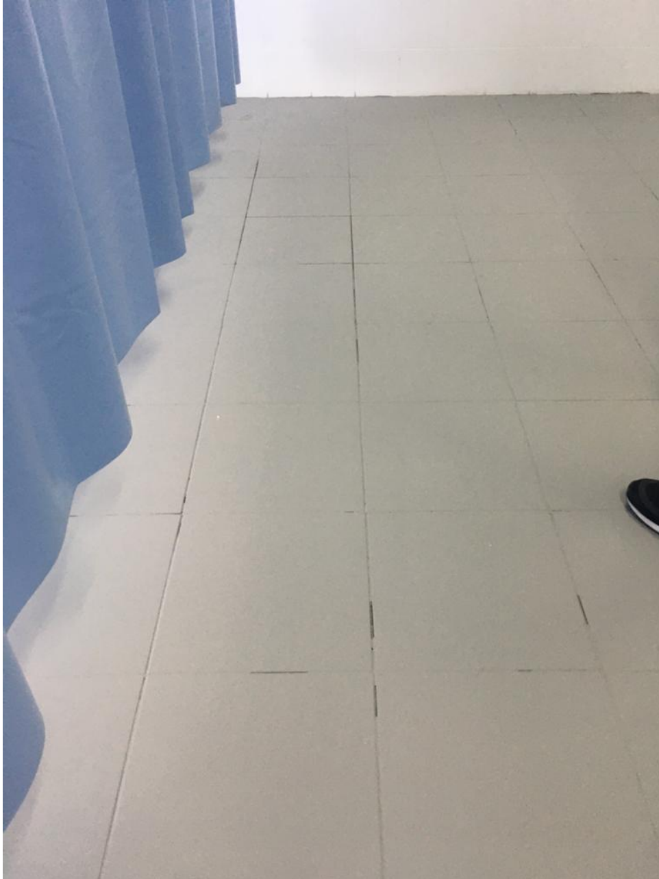
Figura 34: Chão com pintura emborrachada. (Fonte: Dos Autores 2020).
