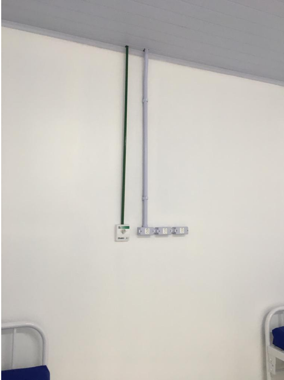
Figura 15: Sistema de oxigênio. (Fonte: Dos Autores 2020).
