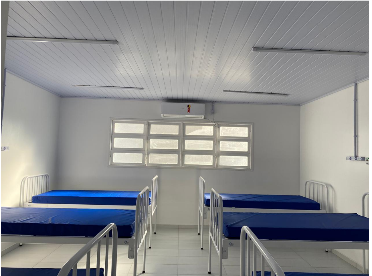
Figura 14: Quarto com ar condicionado. (Fonte: Dos Autores 2020).
