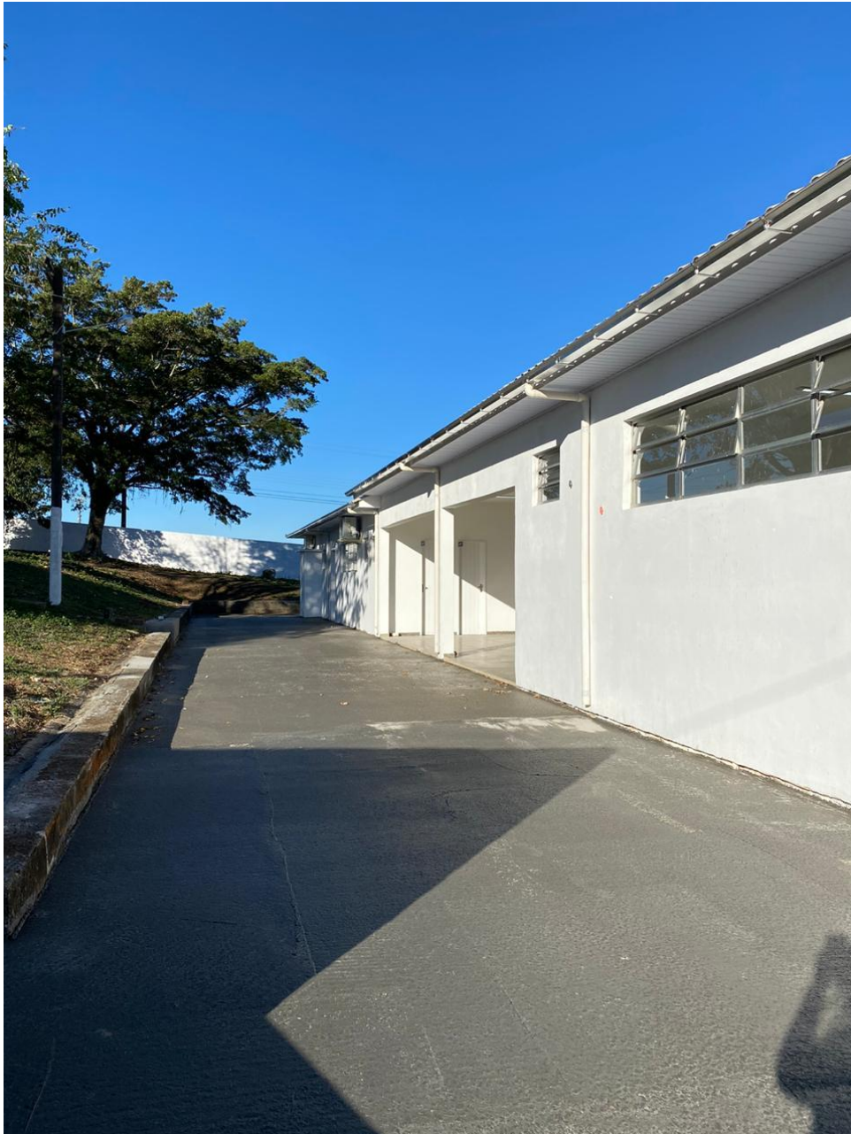
Figura 35: Chão concretado. (Fonte: Dos Autores 2020).
