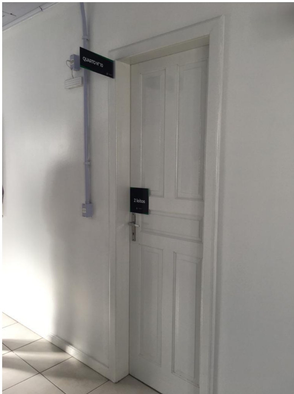
Figura 19: Porta de madeira. (Fonte: Dos Autores 2020).
