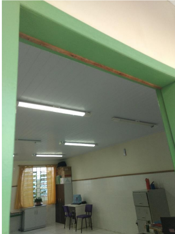
Figura 12: Madeiras instaladas na porta. (Fonte: Dos Autores 2018)
