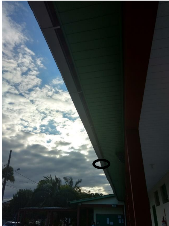
Figura 9: Solda feita na calha. (Fonte: Dos Autores 2018)
