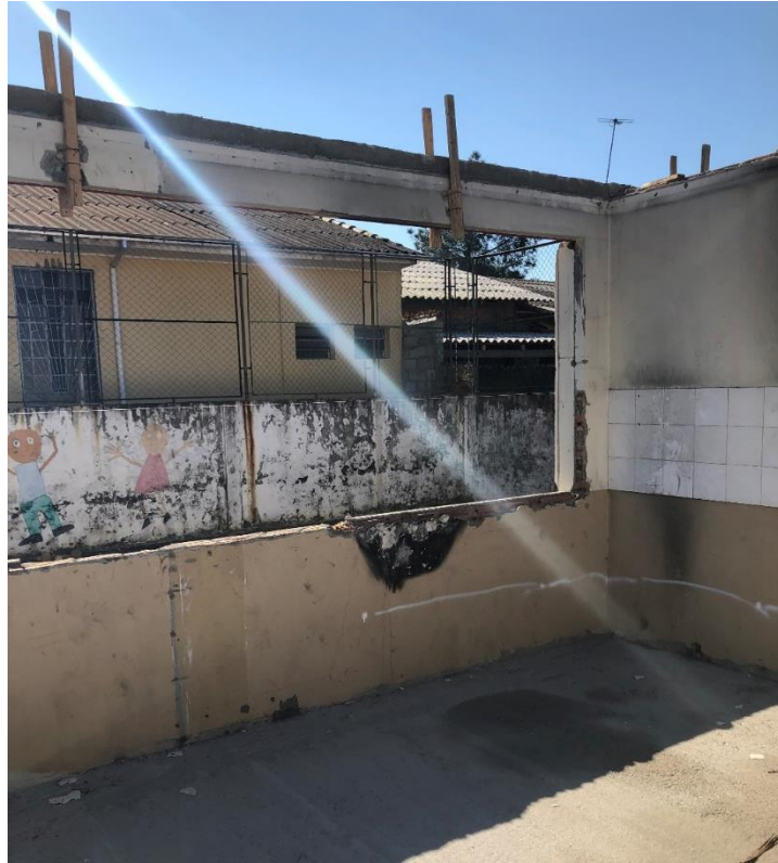
Figura 38: Banheiros antiga estrutura. (Fonte: Dos Autores 2019)
