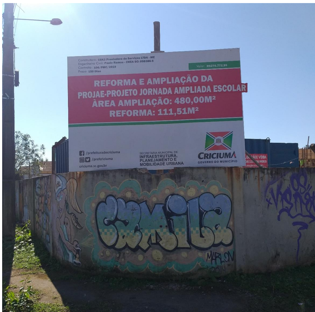
Figura 4: Placa para identificação da obra Escola Eliza Sampaio Rovaris. (Fonte: Dos Autores 2019)
