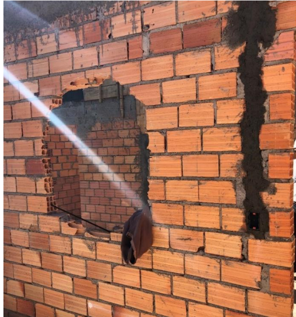
Figura 28: Execução da parte elétrica. (Fonte: Dos Autores 2019)
