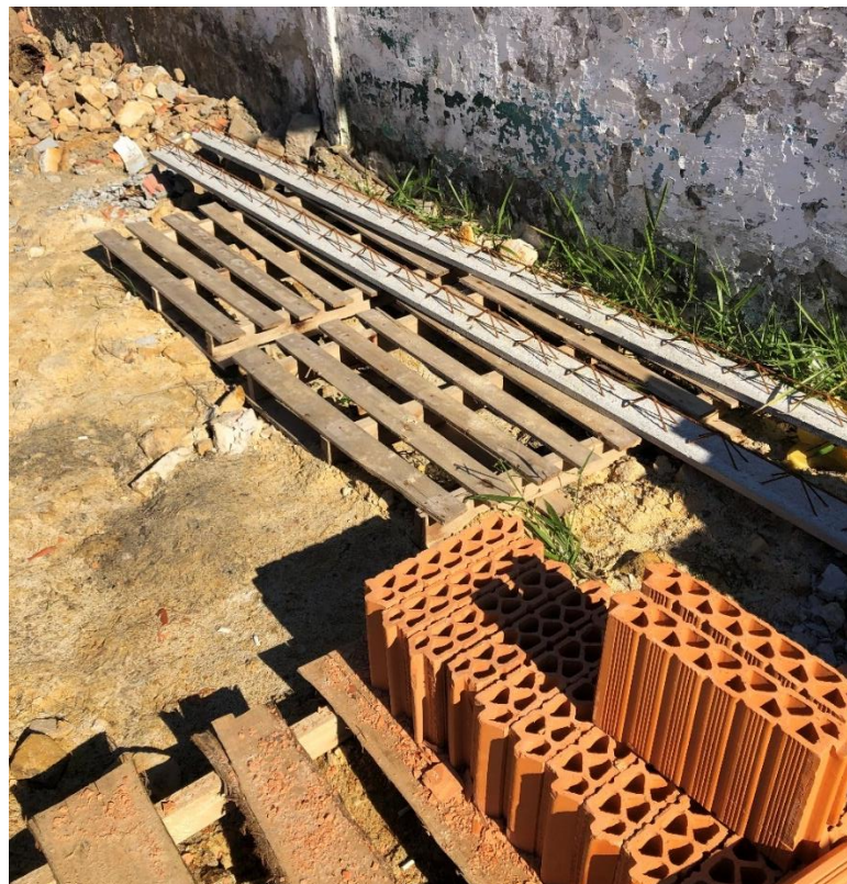
Figura 10: Vigotas e blocos cerâmicos devidamente armazenados. (Fonte: Dos Autores 2019)
