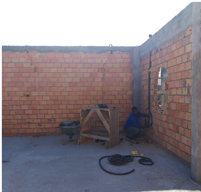
Figura 25: Trabalhador executando a parte elétrica da obra. (Fonte: Dos Autores 2019)
