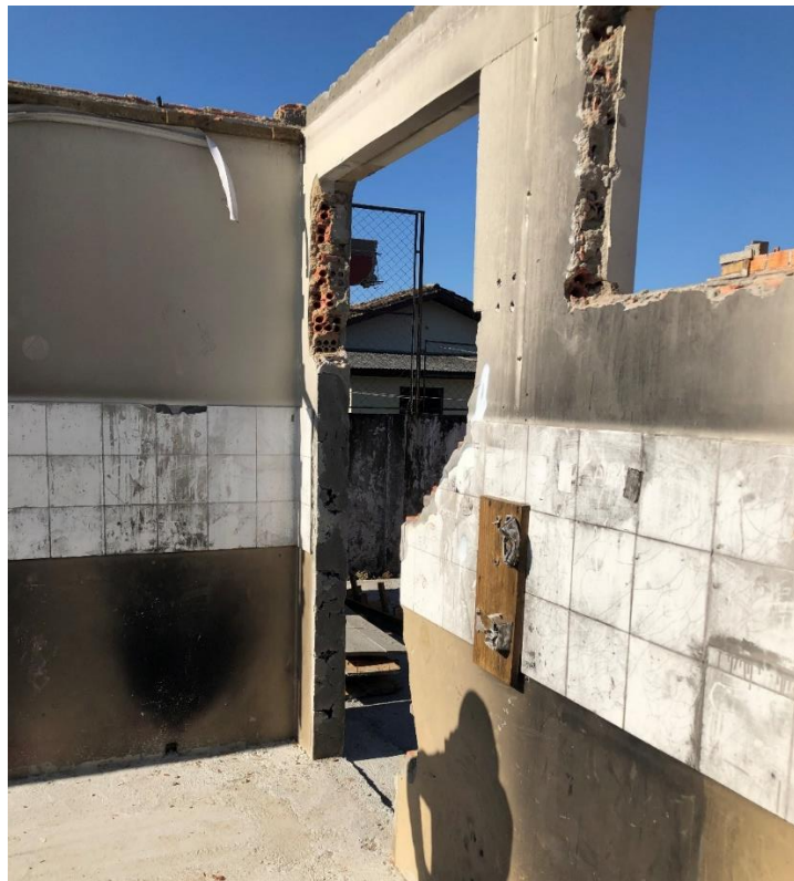
Figura 39: Banheiros antiga estrutura. (Fonte: Dos Autores 2019)
