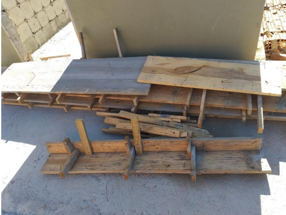
Figura 44: Formas das vigas. (Fonte: Dos Autores 2019)
