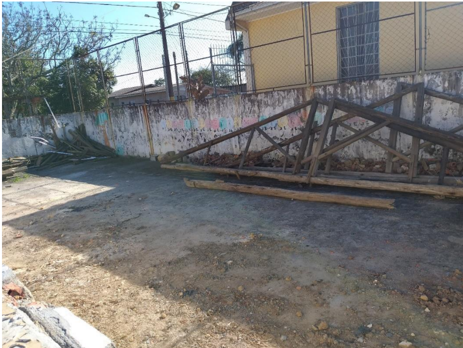
Figura 47: Entulho. (Fonte: Dos Autores 2019)
