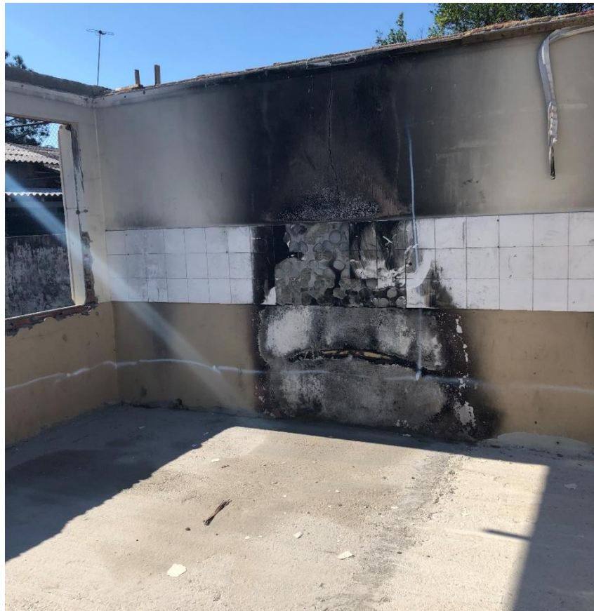
Figura 37: Banheiros antiga estrutura. (Fonte: Dos Autores 2019)
