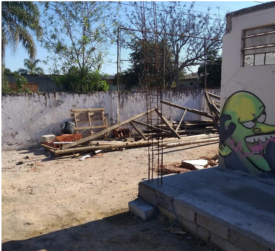
Figura 45: Entulho (Fonte: Dos Autores 2019)
