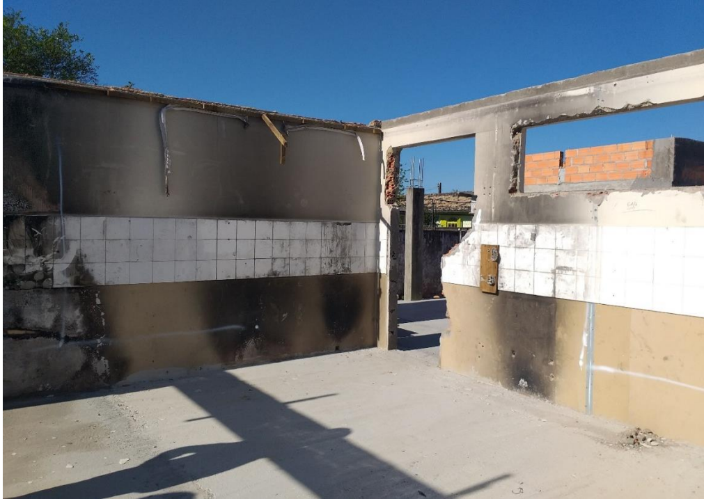
Figura 36: Banheiros antiga estrutura. (Fonte: Dos Autores 2019)
