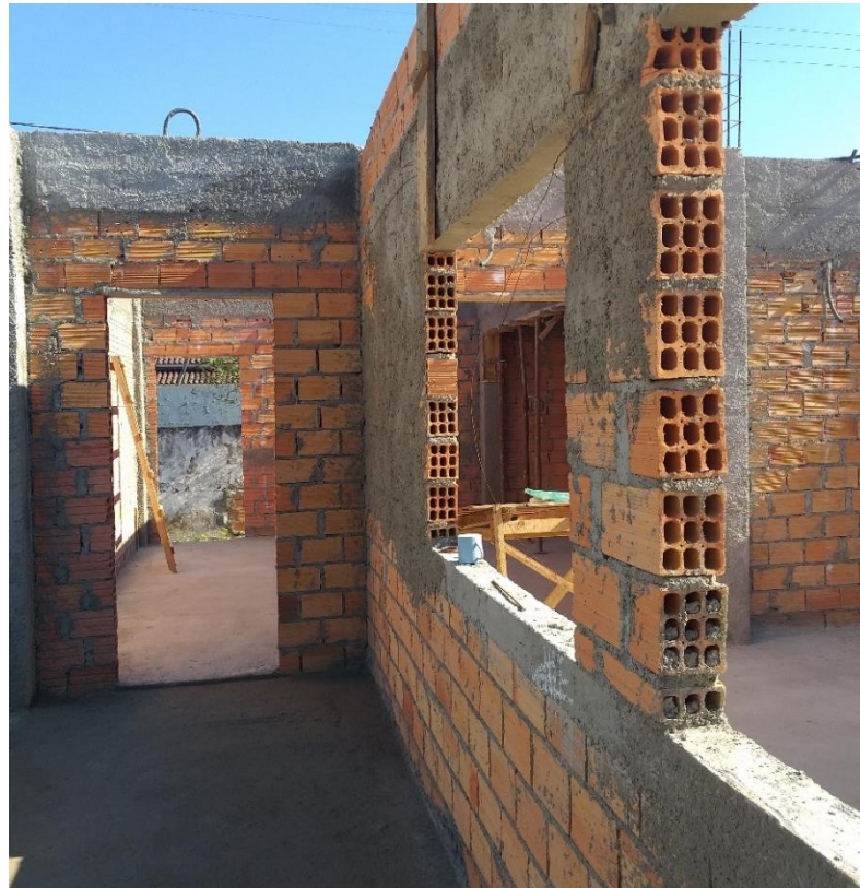
Figura 15: Corredor de acesso. (Fonte: Dos Autores 2019)
