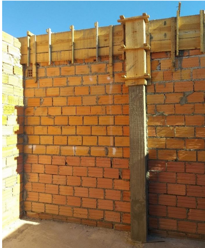
Figura 20: Acréscimo de 1 (um) metro de altura nas paredes. (Fonte: Dos Autores 2019)
