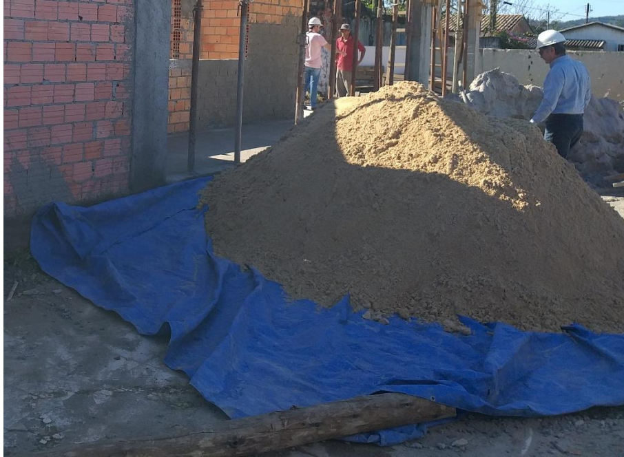
Figura 11: Areia armazenada corretamente. (Fonte: Dos Autores 2019)
