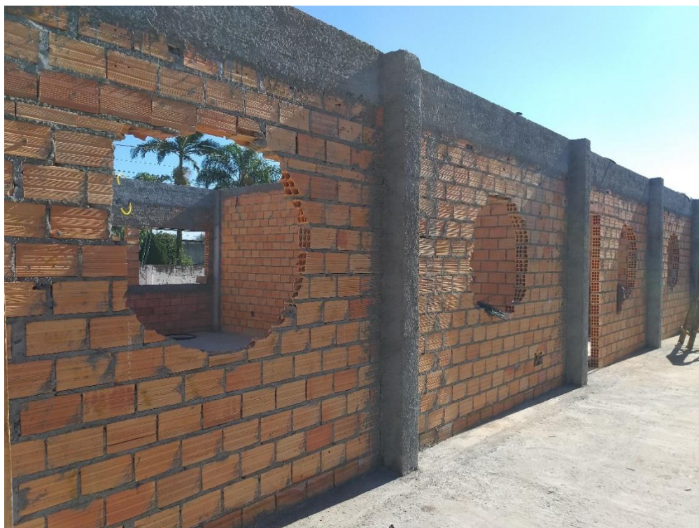
Figura 19: Janelas circulares corredor de acesso principal. (Fonte: Dos Autores 2019)
