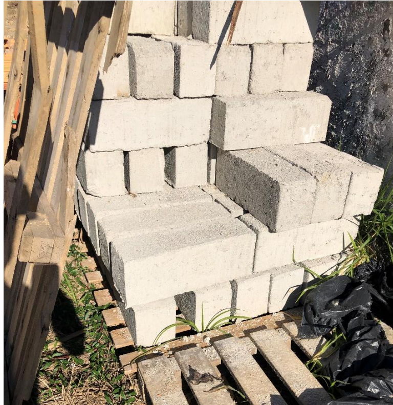
Figura 9: Blocos de concreto armazenados corretamente. (Fonte: Dos Autores 2019)
