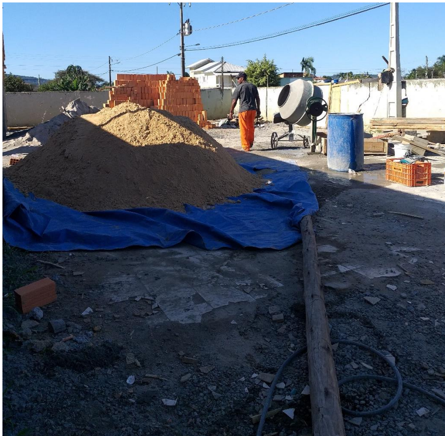
Figura 12: Canteiro de obras. (Fonte: Dos Autores 2019)
