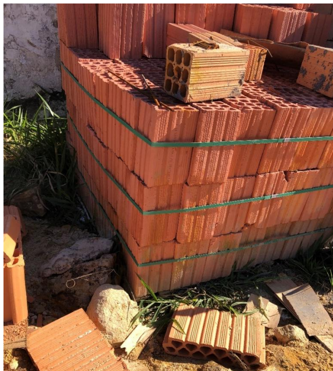
Figura 8: Blocos cerâmicos armazenados corretamente. (Fonte: Dos Autores 2019)
