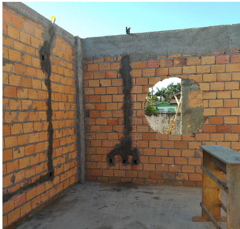
Figura 27: Execução da parte elétrica. (Fonte: Dos Autores 2019)
