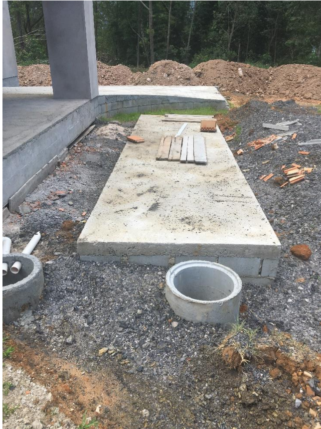
Figura 7: Tanque séptico. (Fonte: Dos Autores 2019)
