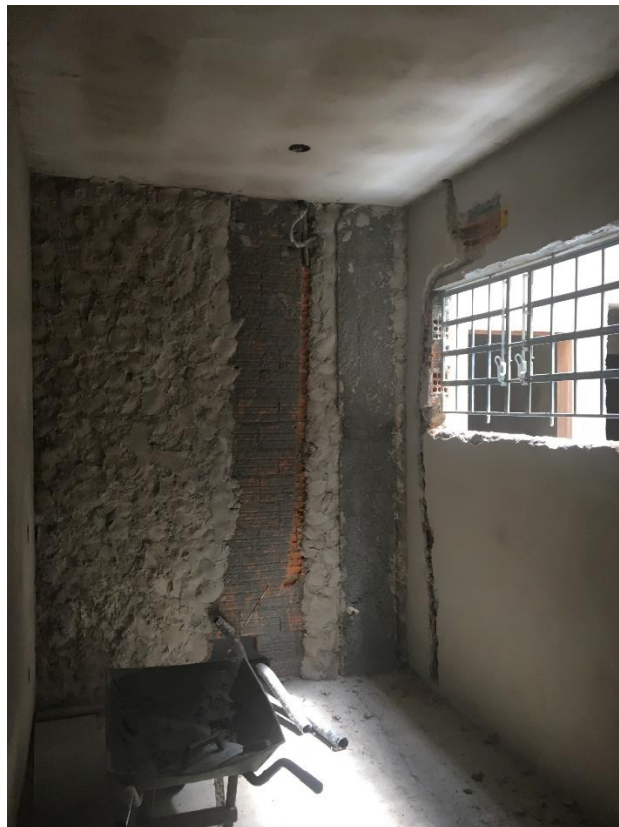
Figura 11: Serviços de emboço e reboco incompletos. (Fonte: Dos Autores 2019)
