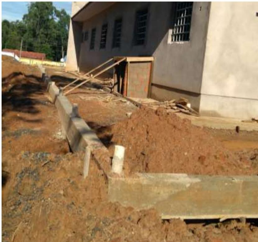
**Figura 10:** Viga baldrame para cerca da unidade. (Fonte: Dos Autores 2019)
