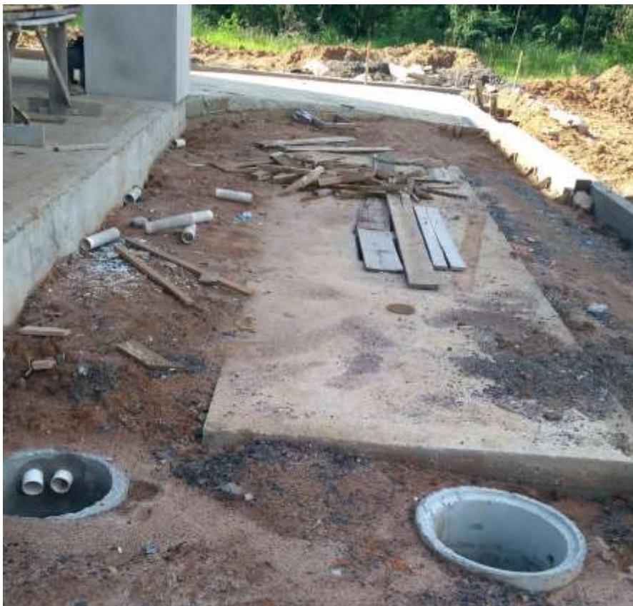
**Figura 8:** Tanque séptico. (Fonte: Dos Autores 2019)
