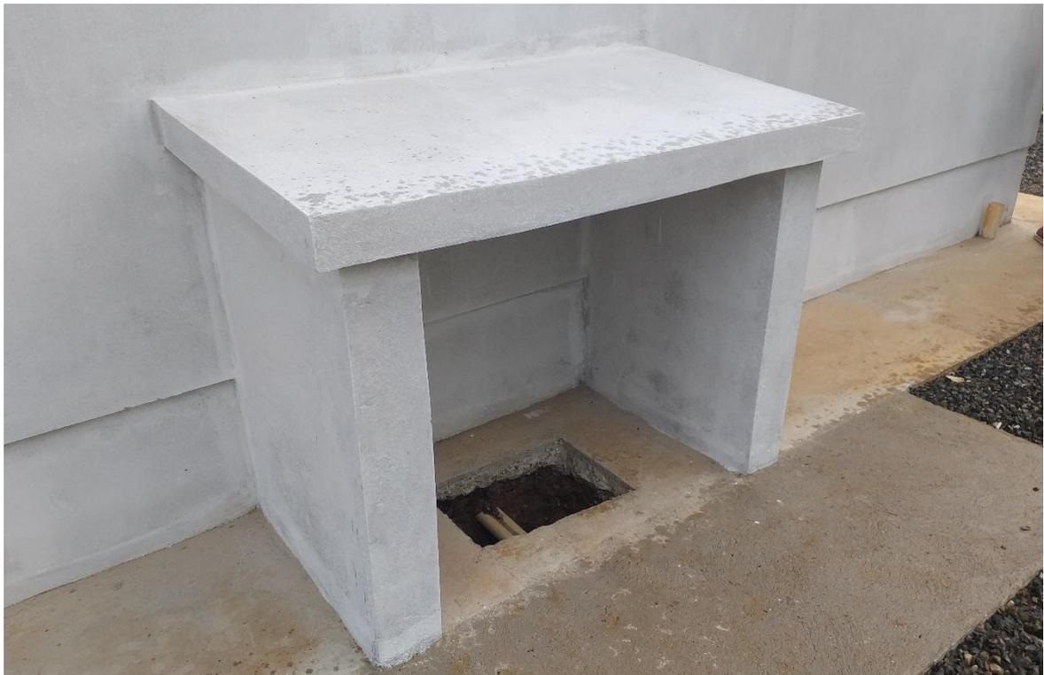
**Figura 8:** Local de abrigo para o compressor. (Fonte: Dos Autores 2019)
