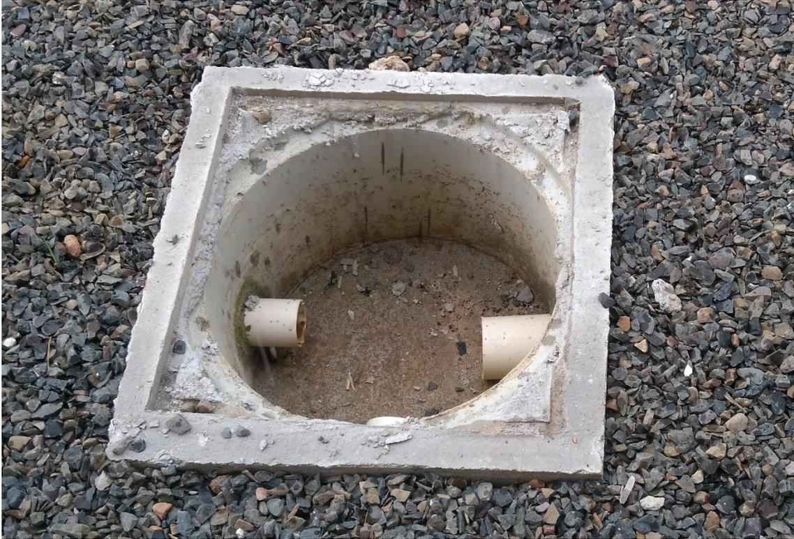
**Figura 12:** Caixa de inspeção. (Fonte: Dos Autores 2019)
