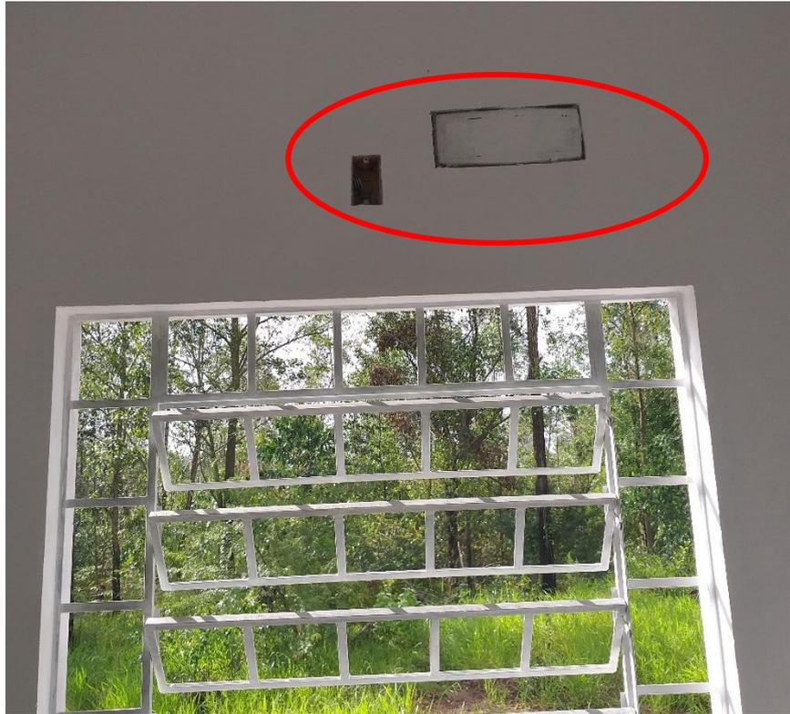
**Figura 23:** Abertura para instalação do split. (Fonte: Dos Autores 2019)
