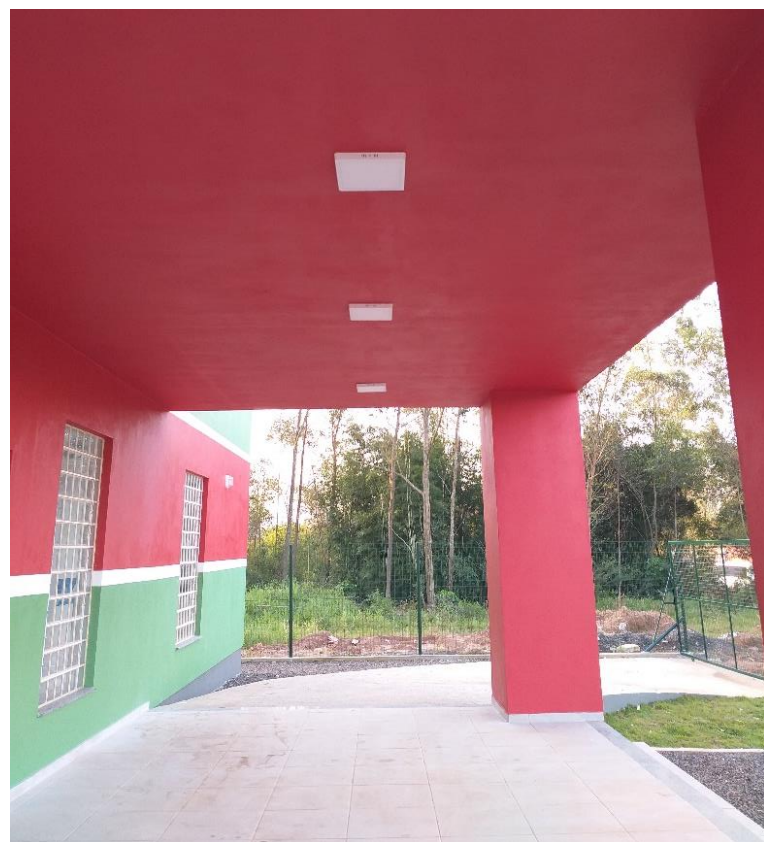
Figura 11: Instalações elétricas exteriores concluídas. (Fonte: Dos Autores 2019)
