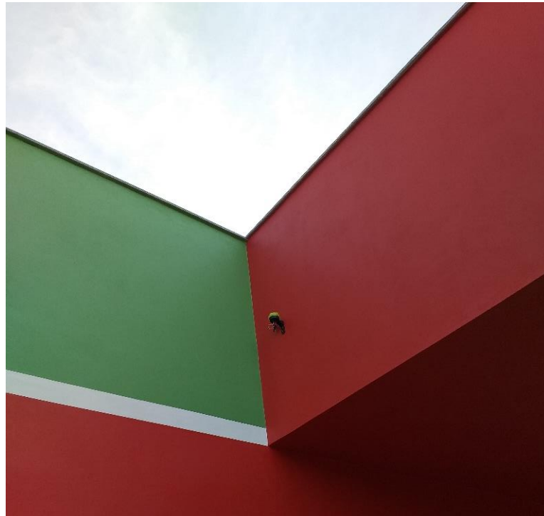
Figura 10: Pingadeiras. (Fonte: Dos Autores 2019)
