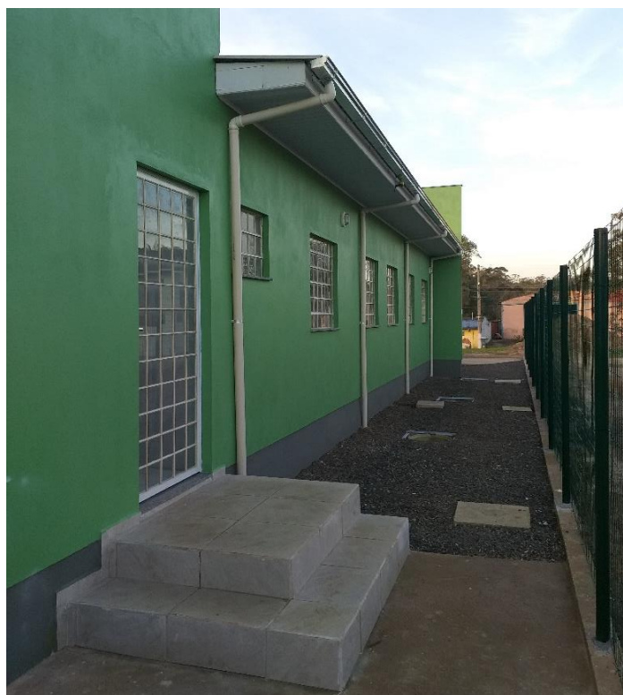
Figura 9: Fachada lateral da UBS Sangão e conclusão da calha. (Fonte: Dos Autores 2019)
