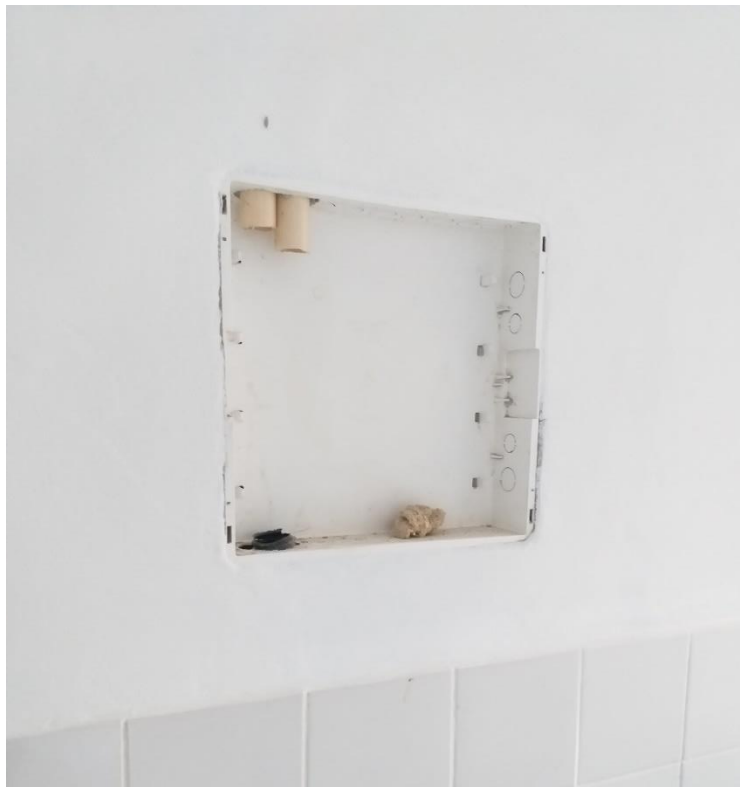
Figura 22: Parte elétrica da obra em execução. (Fonte: Dos Autores 2019)
