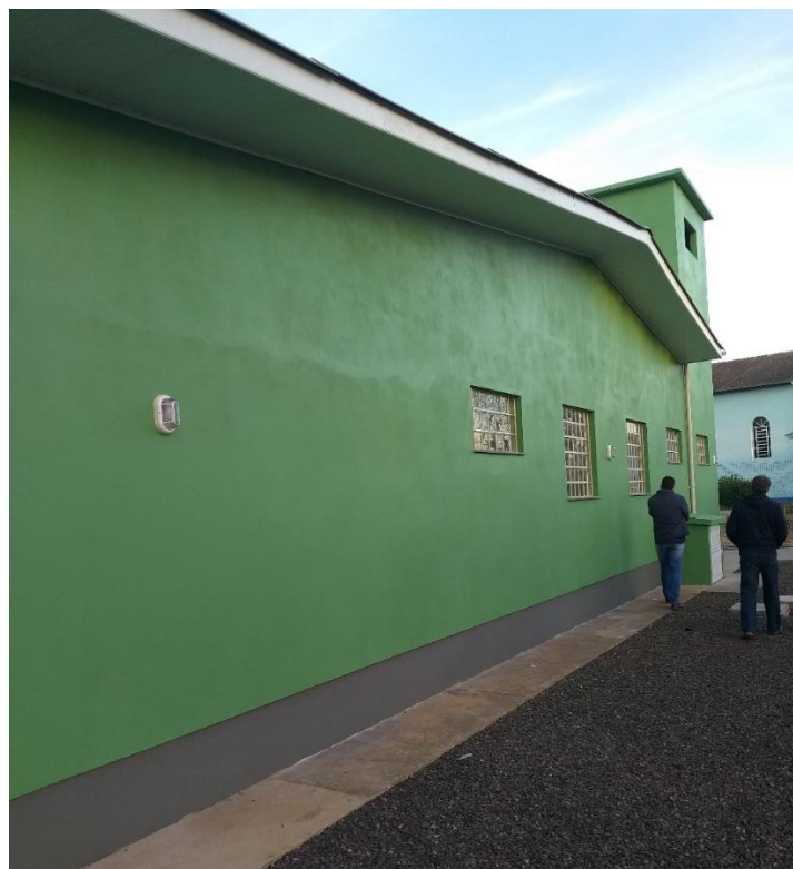
Figura 13: Fachada posterior UBS Sangão e instalações elétricas exteriores concluídas. (Fonte: Dos Autores 2019)
