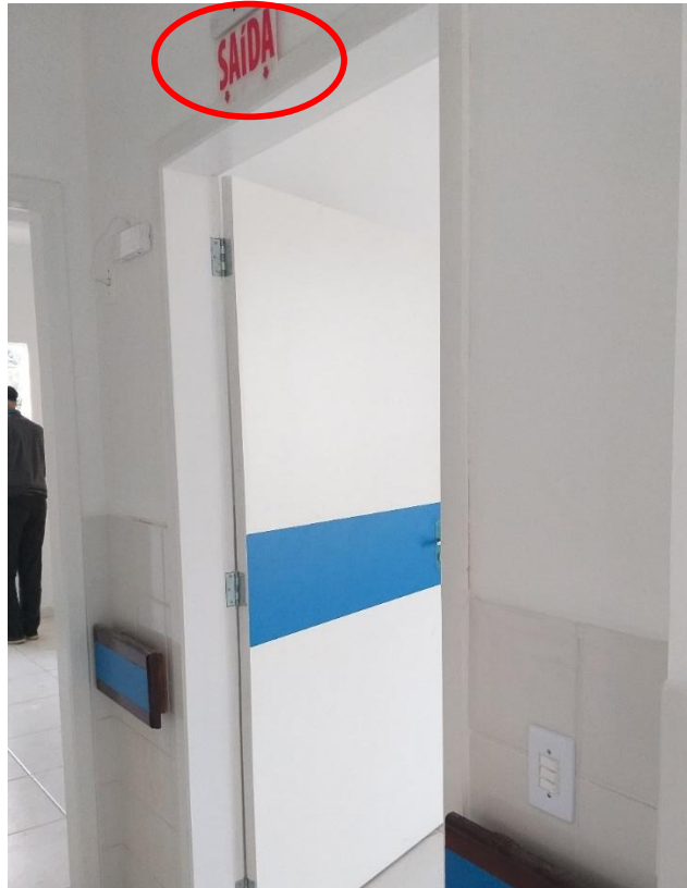
Figura 23: Iluminação de emergência. (Fonte: Dos Autores 2019)
