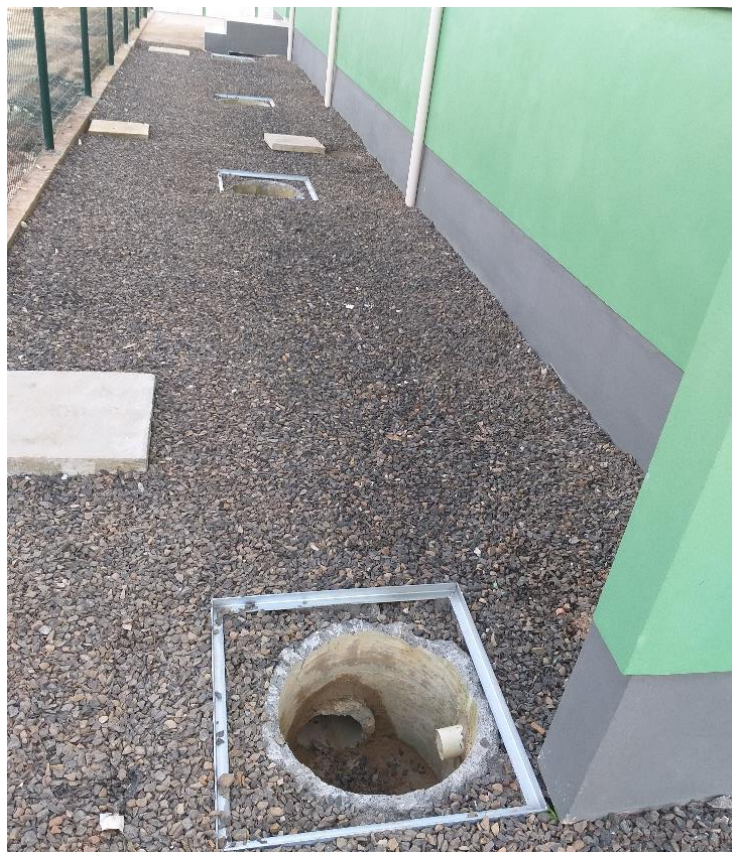
Figura 6: Conclusão das caixas de inspeção. (Fonte: Dos Autores 2019)
