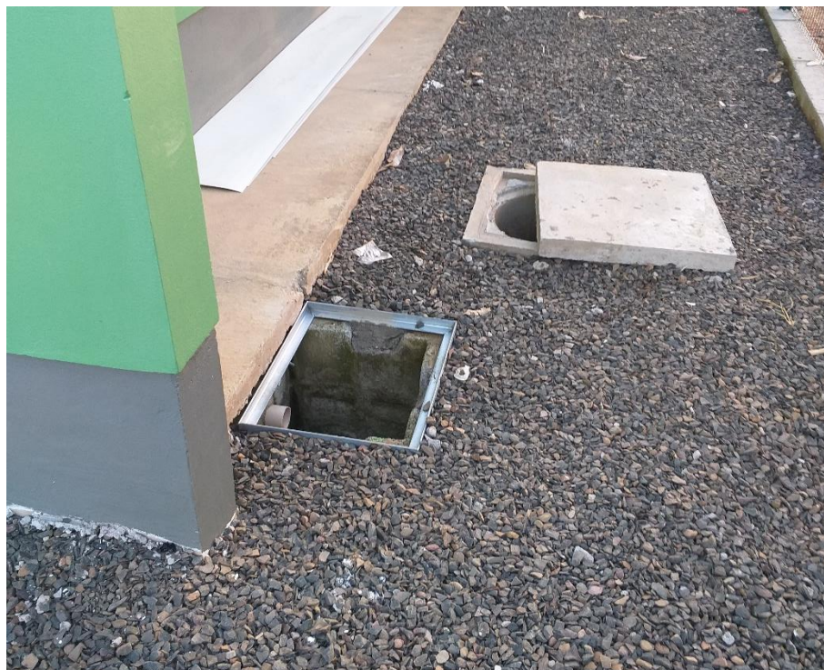
Figura 7: Conclusão das caixas de inspeção. (Fonte: Dos Autores 2019)
