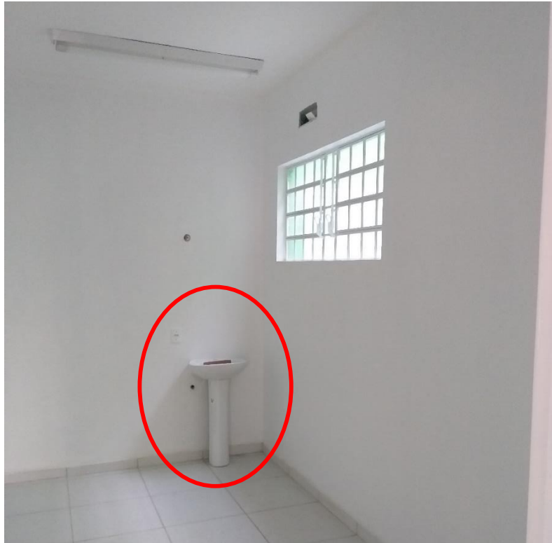
Figura 19: Pia da sala de triagem sem azulejo. (Fonte: Dos Autores 2019)
