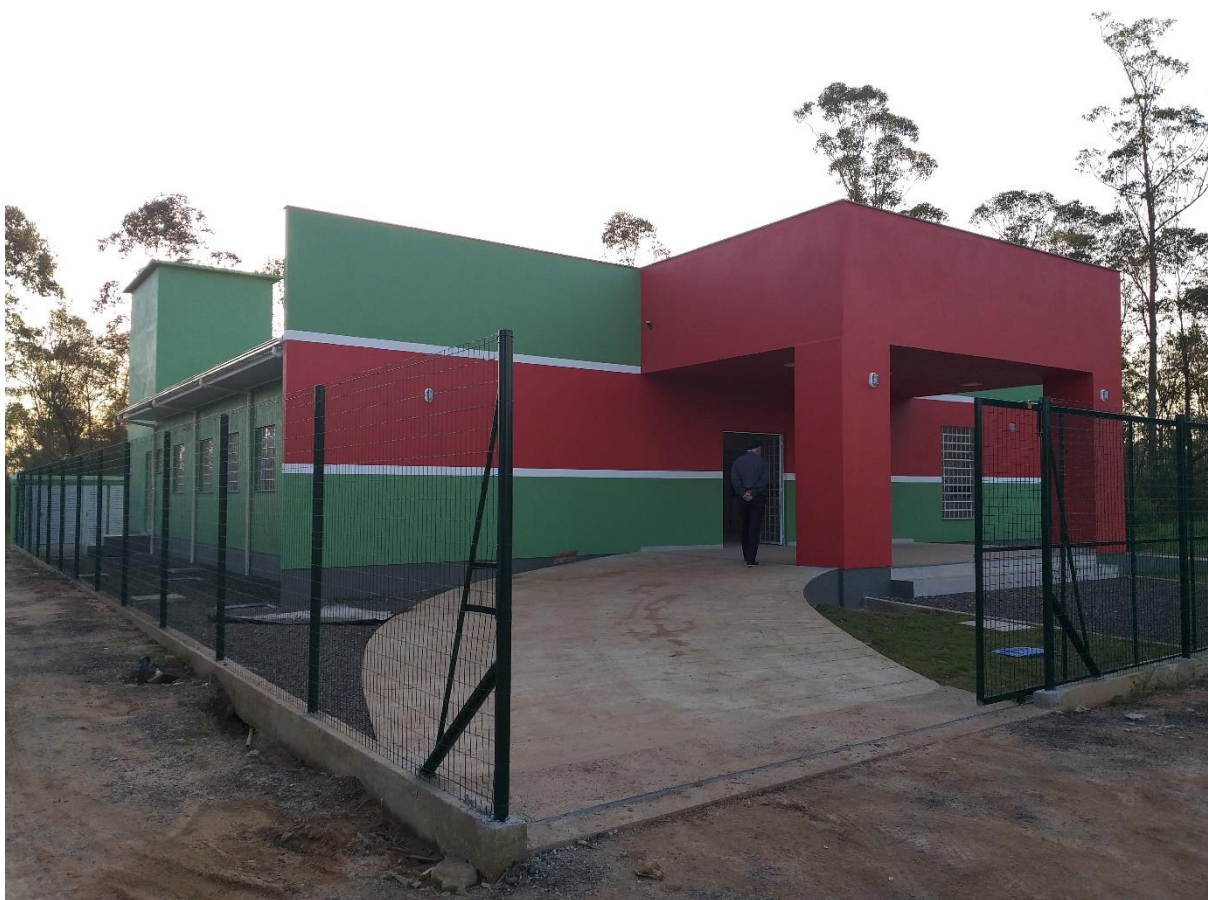
Figura 4: Fachada frontal da UBS Sangão. (Fonte: Dos Autores 2019)
