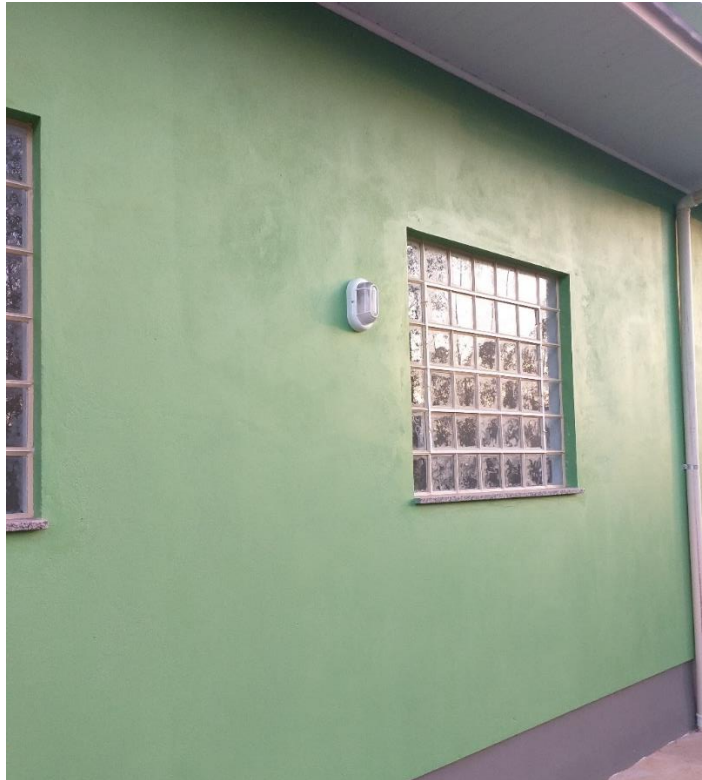
Figura 12: Instalações elétricas exteriores concluídas. (Fonte: Dos Autores 2019)
