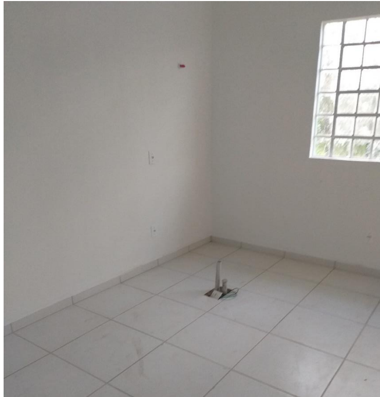
Figura 21: Parte hidráulica da obra em execução. (Fonte: Dos Autores 2019)
