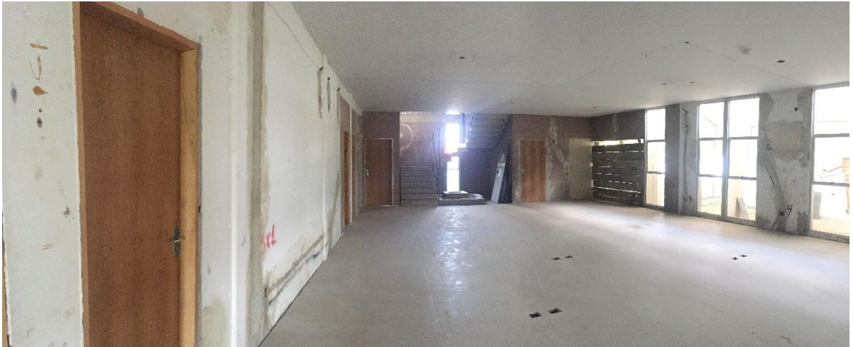
Figura 9: Portas substituídas. (Fonte: Dos Autores 2020).
