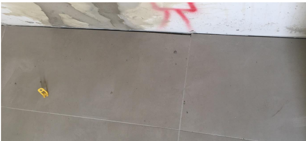
Figura 13: Rodapé ainda não colocado. (Fonte: Dos Autores 2020).
