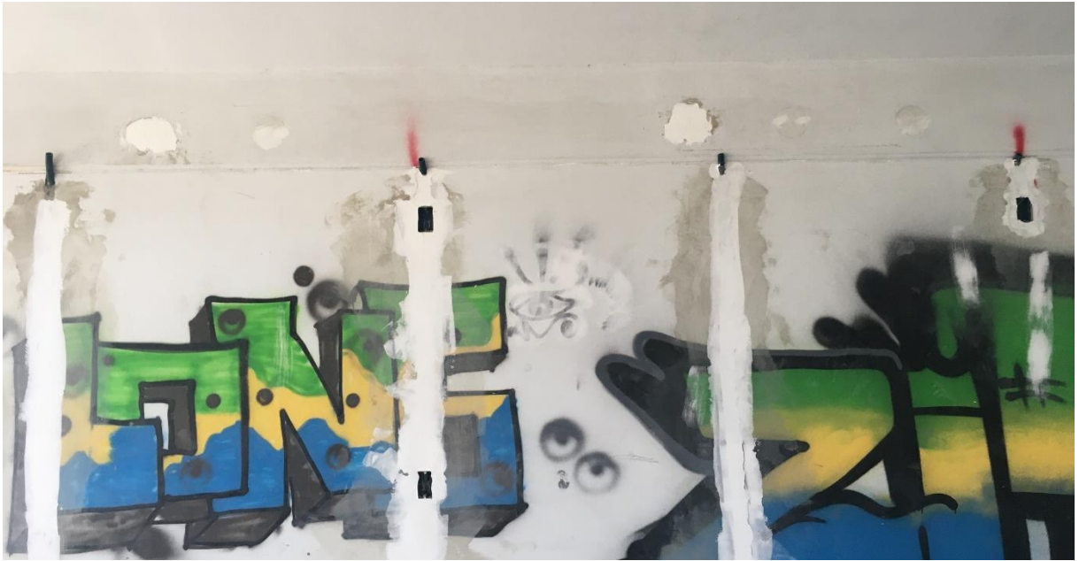
Figura 18: Parte superior dos eletrodutos à mostra. (Fonte: Dos Autores 2020).
