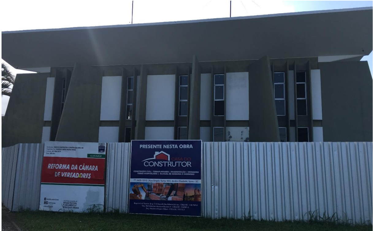
Figura 4: Fachada frontal da obra. (Fonte: Dos Autores 2020).
