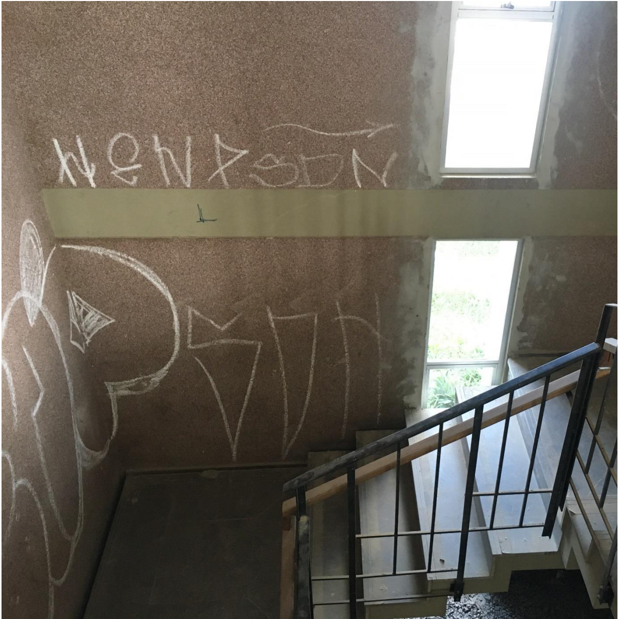
Figura 20: Paredes da escada sem alterações. (Fonte: Dos Autores 2020).
