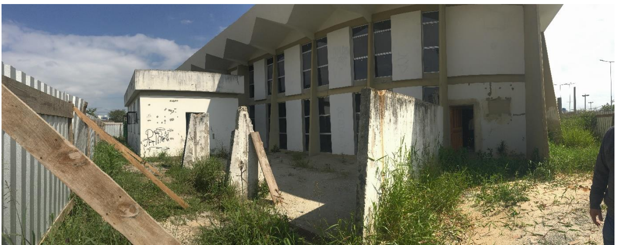
Figura 7: Obra paralisada. (Fonte: Dos Autores 2020).
