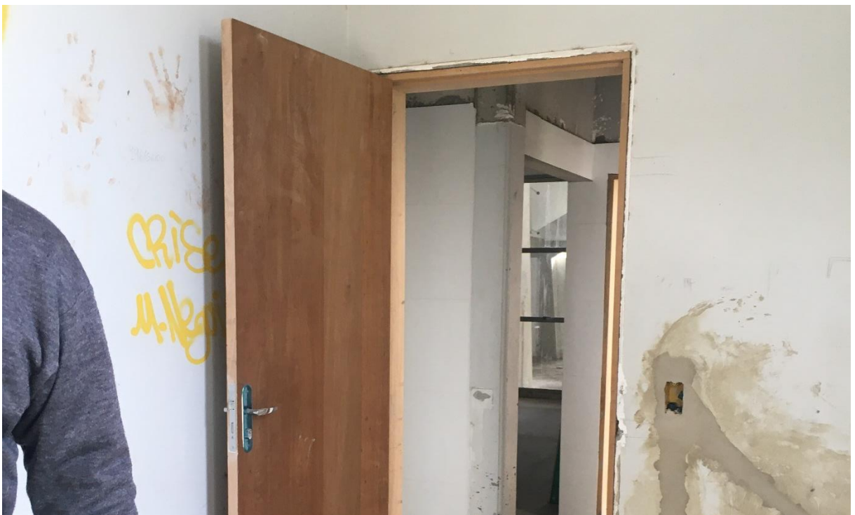
Figura 10: Modelo de porta colocada. (Fonte: Dos Autores 2020).
