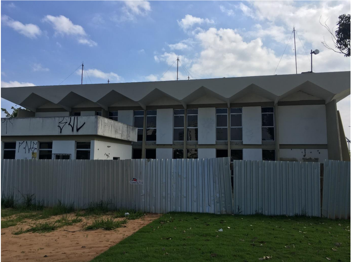
Figura 6: Tapumes isolando a obra. (Fonte: Dos Autores 2020).
