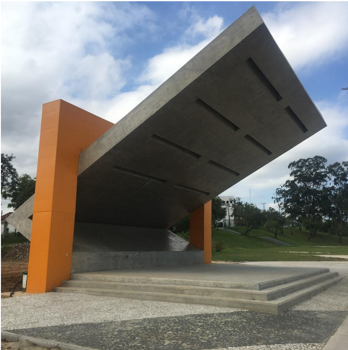
Figura 24: Palco de Eventos em concreto armado. (Fonte: Dos Autores 2020).
