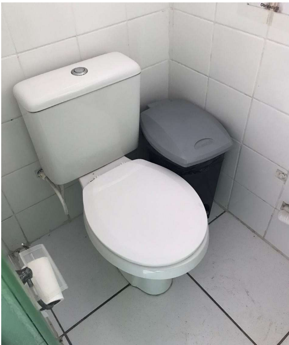
Figura 13: Banheiro com o vazamento consertado. (Fonte: Dos Autores 2020).
