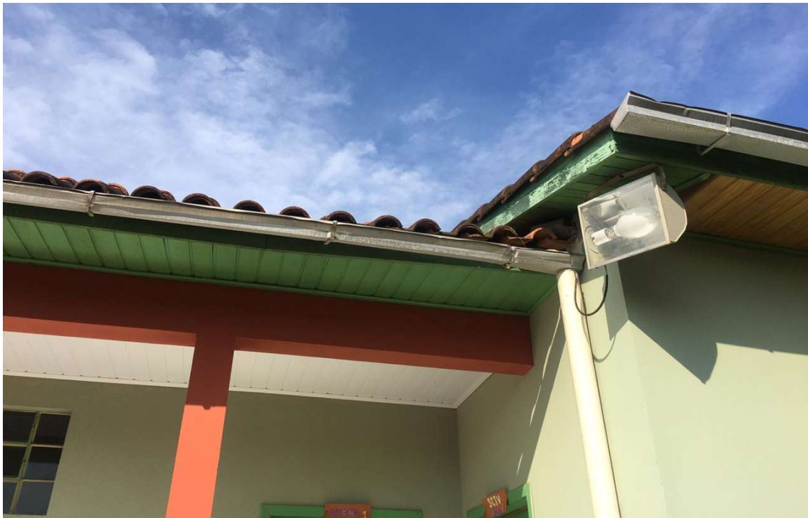
Figura 10: Beiral com forro torto. (Fonte: Dos Autores 2020).
