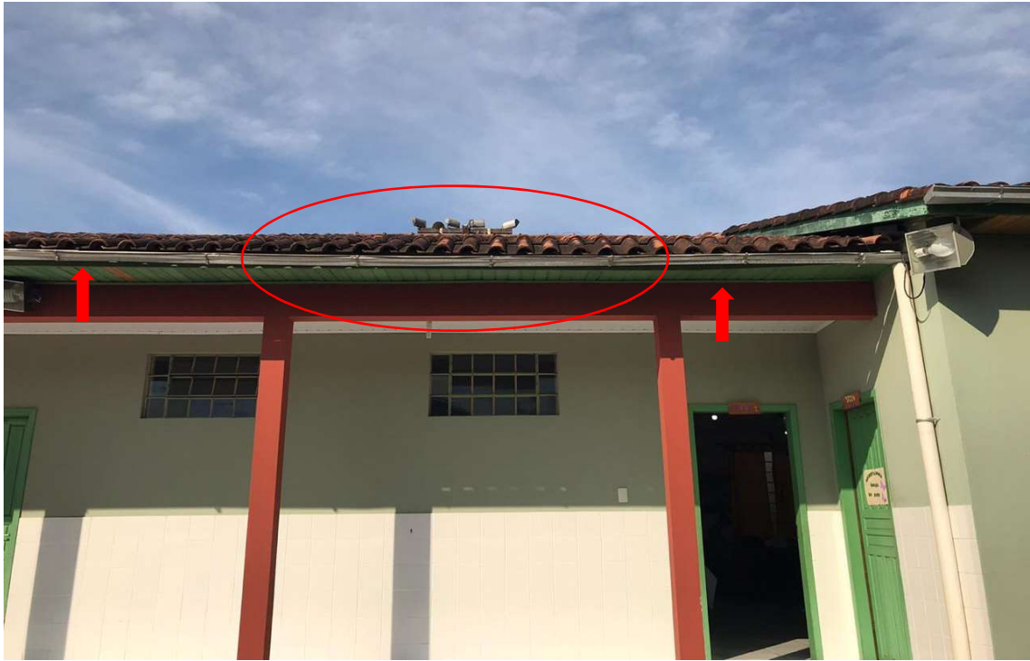
Figura 9: Beiral torto. (Fonte: Dos Autores 2020).
