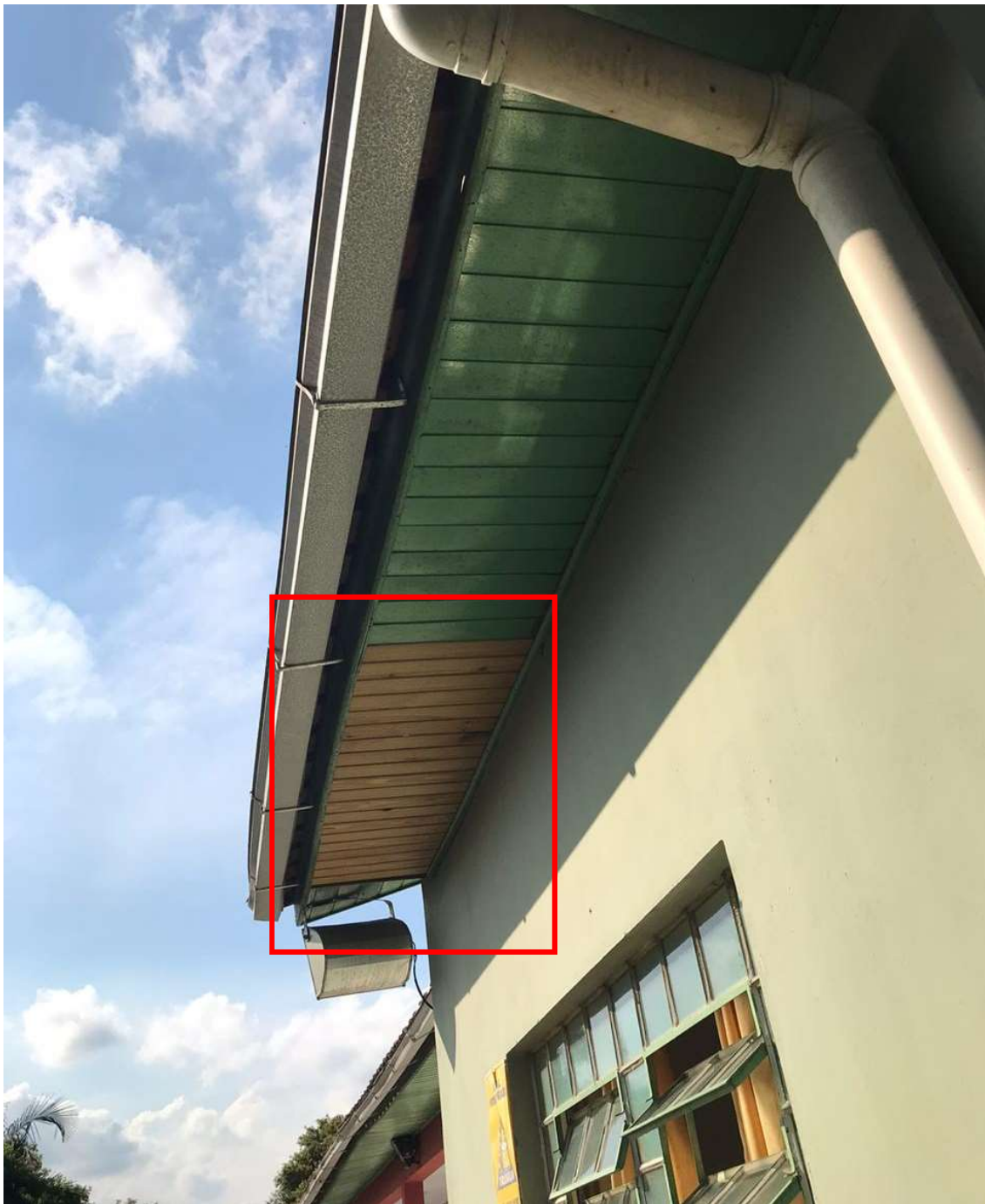
Figura 6: Parte do forro recém trocada. (Fonte: Dos Autores 2020).
