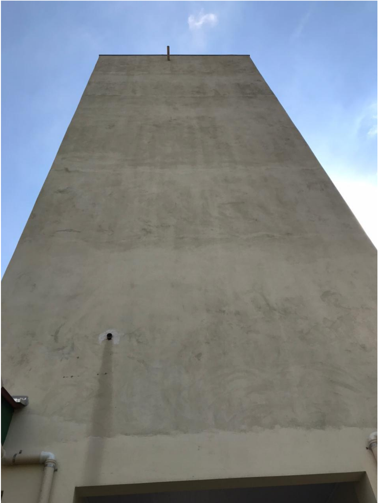
Figura 10: Cobertura para caixa d'água. (Fonte: Dos Autores 2021).
