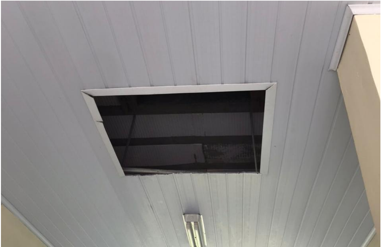
Figura 19: Forro com alçapão aberto. (Fonte: Dos Autores 2021).
