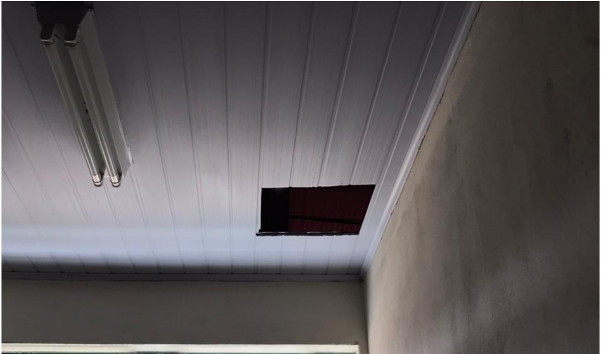
Figura 20: Forro com alçapão aberto. (Fonte: Dos Autores 2021).
