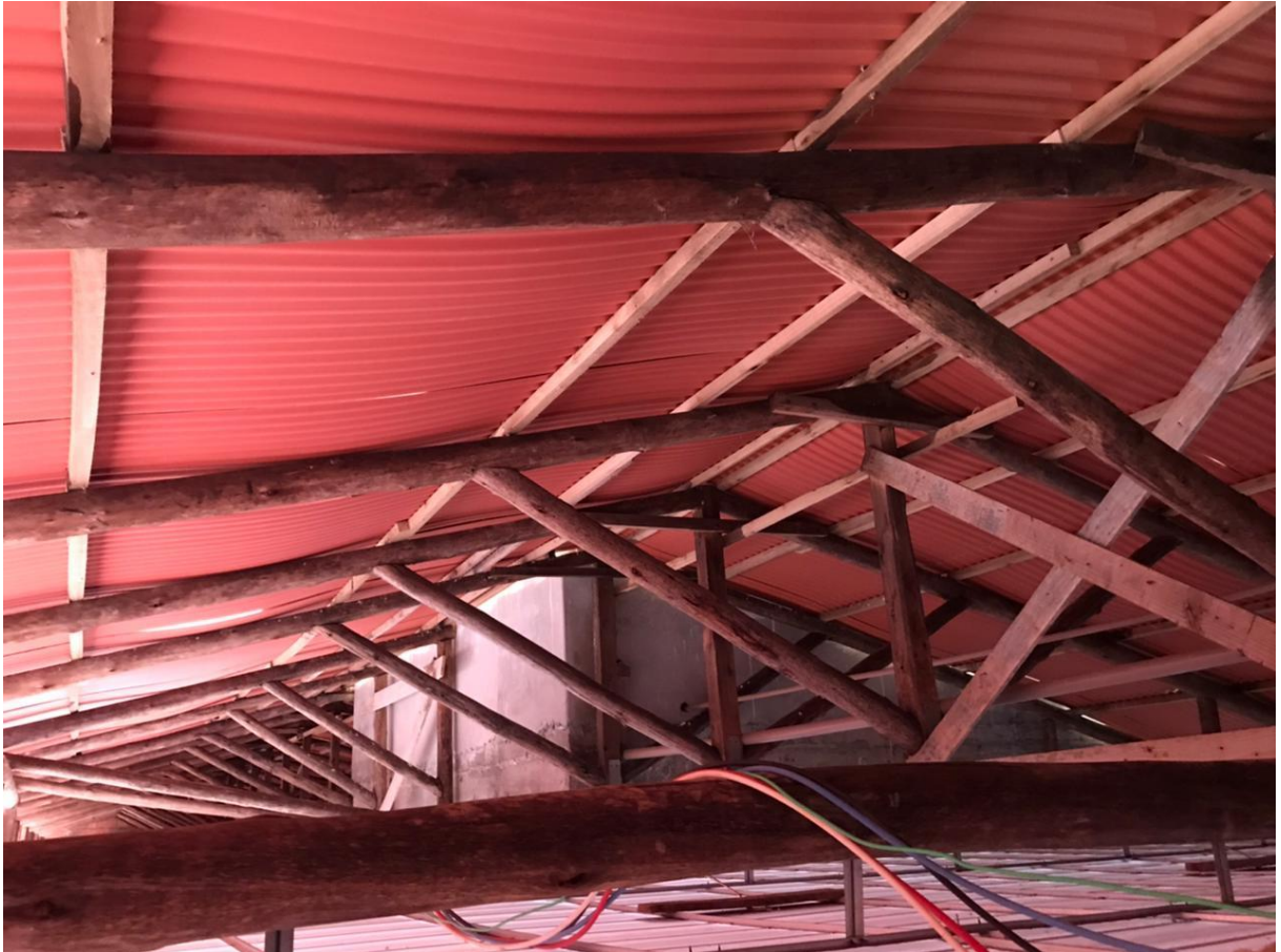
Figura 12: Estrutura do telhado em madeira. (Fonte: Dos Autores 2021).
