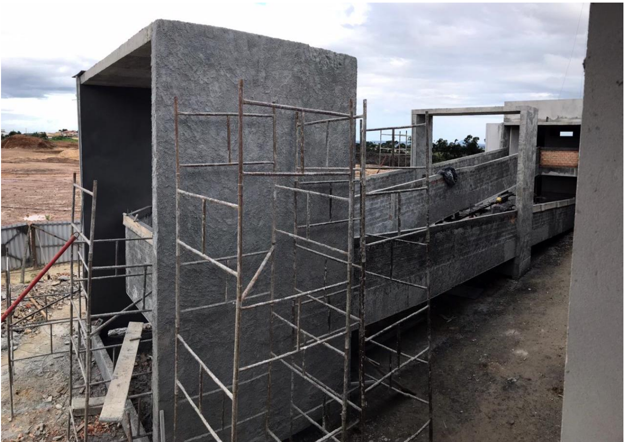
Figura 24: Rampa em construção. (Fonte: Dos Autores 2021).
