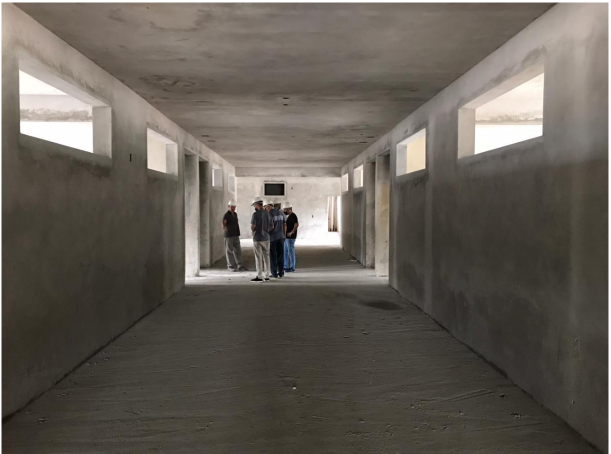
Figura 13: Interior da construção em andamento. (Fonte: Dos Autores 2021).
