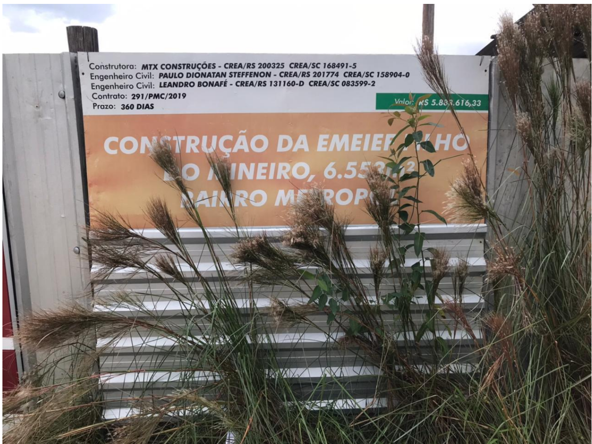
Figura 4: Placa da obra de construção da escola. (Fonte: Dos Autores 2021).
