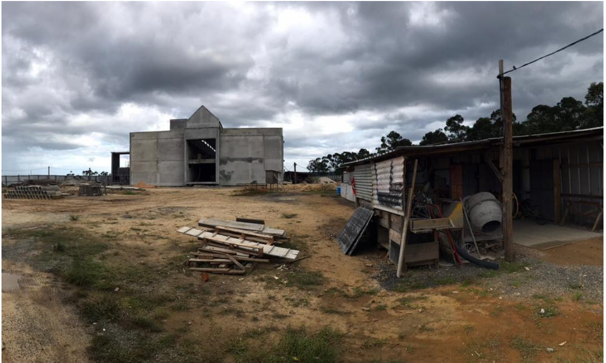
Figura 5: Entrada do canteiro de obras. (Fonte: Dos Autores 2021).
