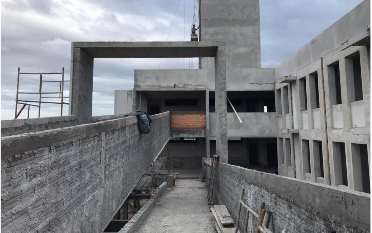
Figura 23: Vista do patamar da rampa. (Fonte: Dos Autores 2021).
