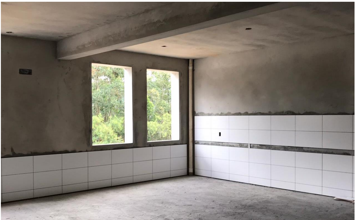
Figura 20: Revestimento cerâmico em aplicação. (Fonte: Dos Autores 2021).
