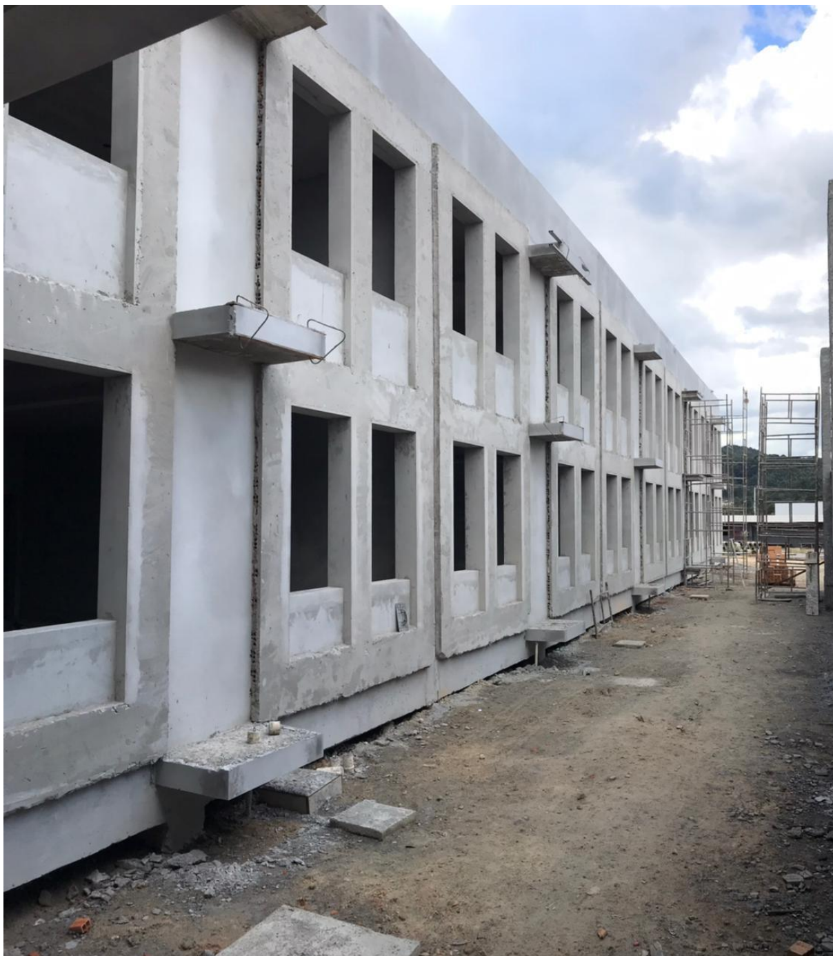
Figura 11: Construção em andamento. (Fonte: Dos Autores 2021).
