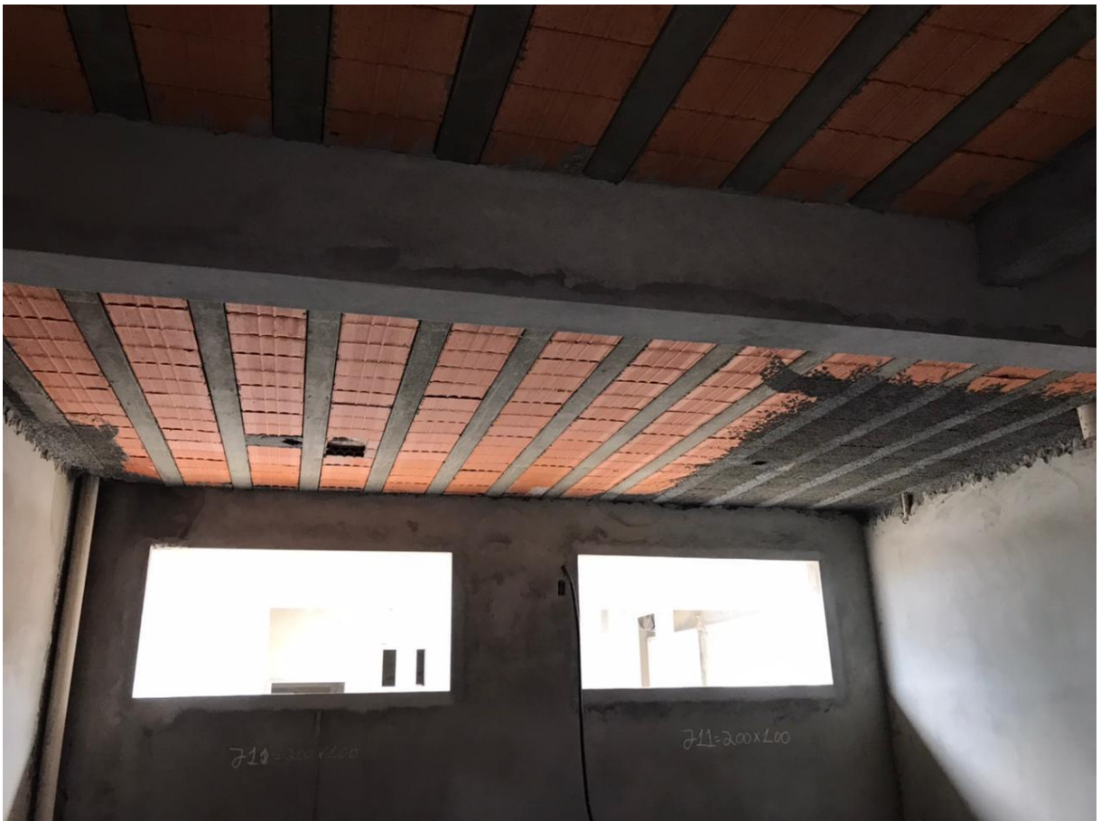
Figura 16: Laje em finalização. (Fonte: Dos Autores 2021).
