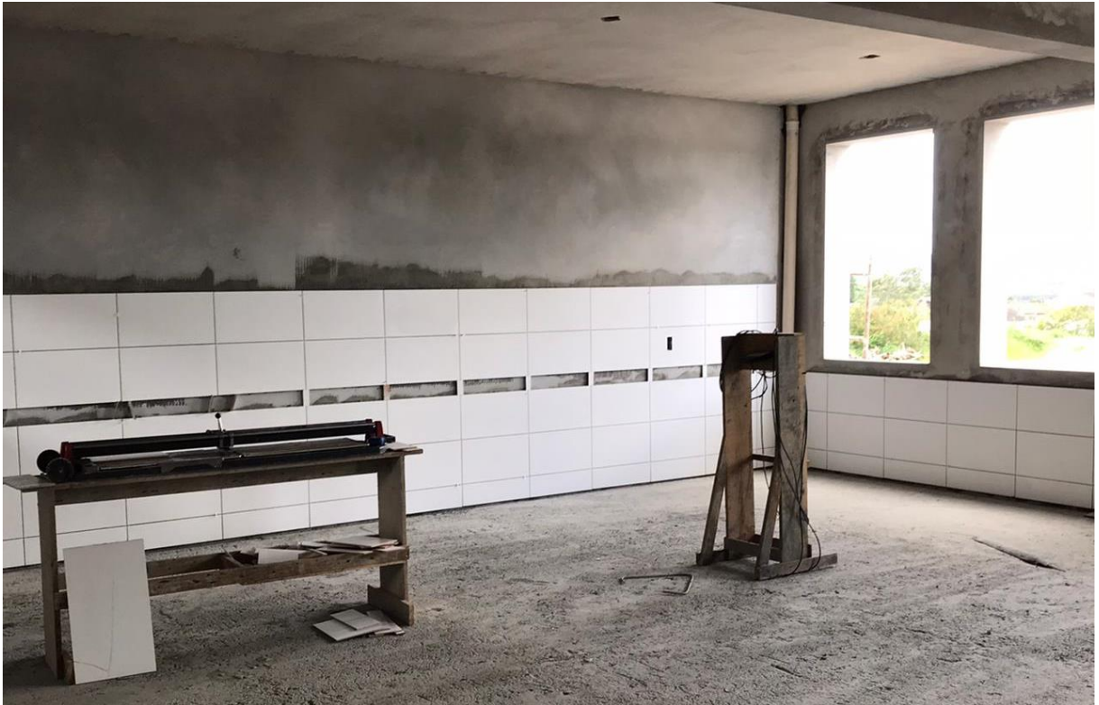
Figura 19: Revestimento cerâmico em aplicação. (Fonte: Dos Autores 2021).
