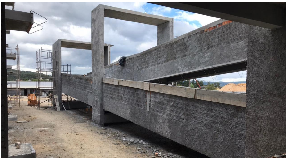
Figura 21: Rampa de acesso ao 2º pavimento. (Fonte: Dos Autores 2021).
