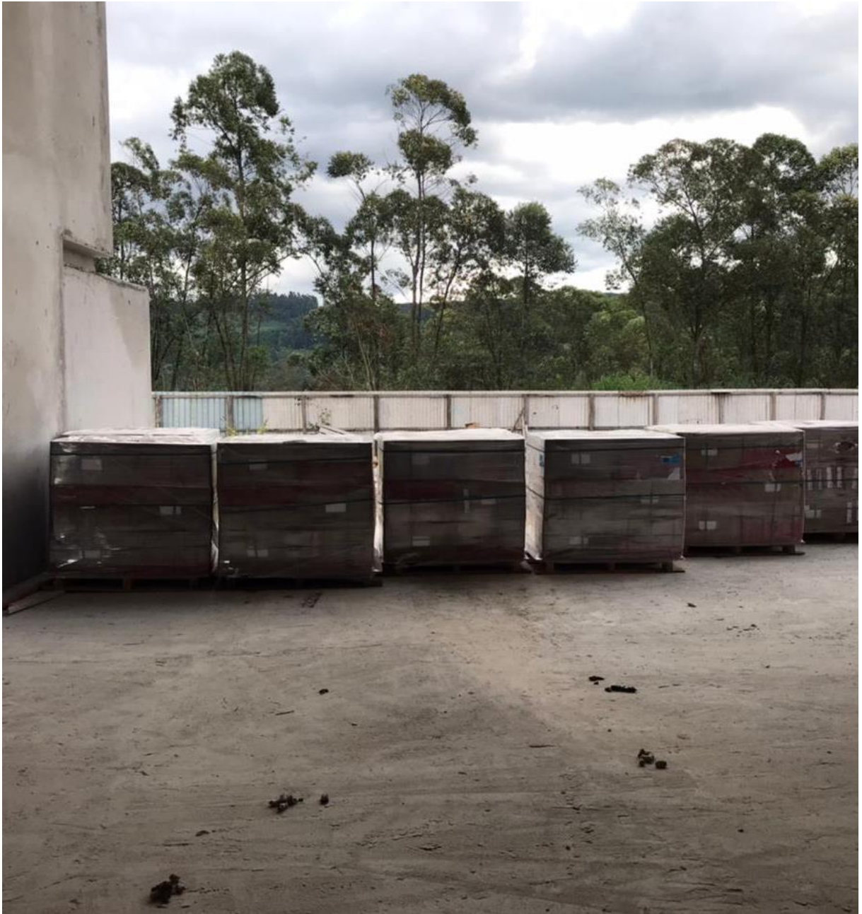
Figura 10: Armazenamento de material correto. (Fonte: Dos Autores 2021).
