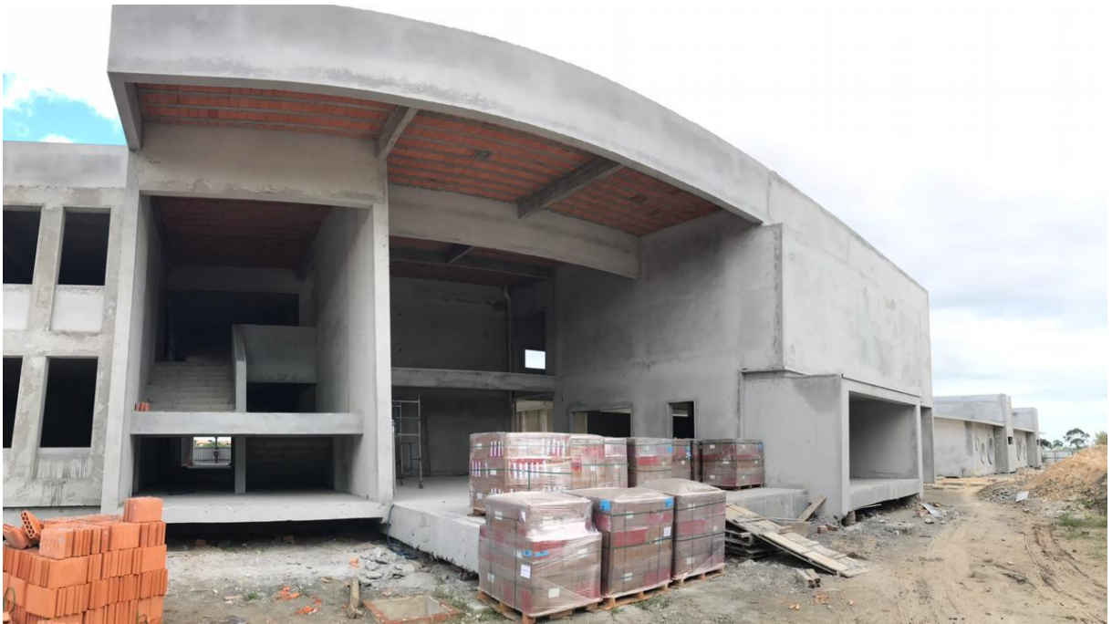
Figura 12: Construção em estágio avançado. (Fonte: Dos Autores 2021).
