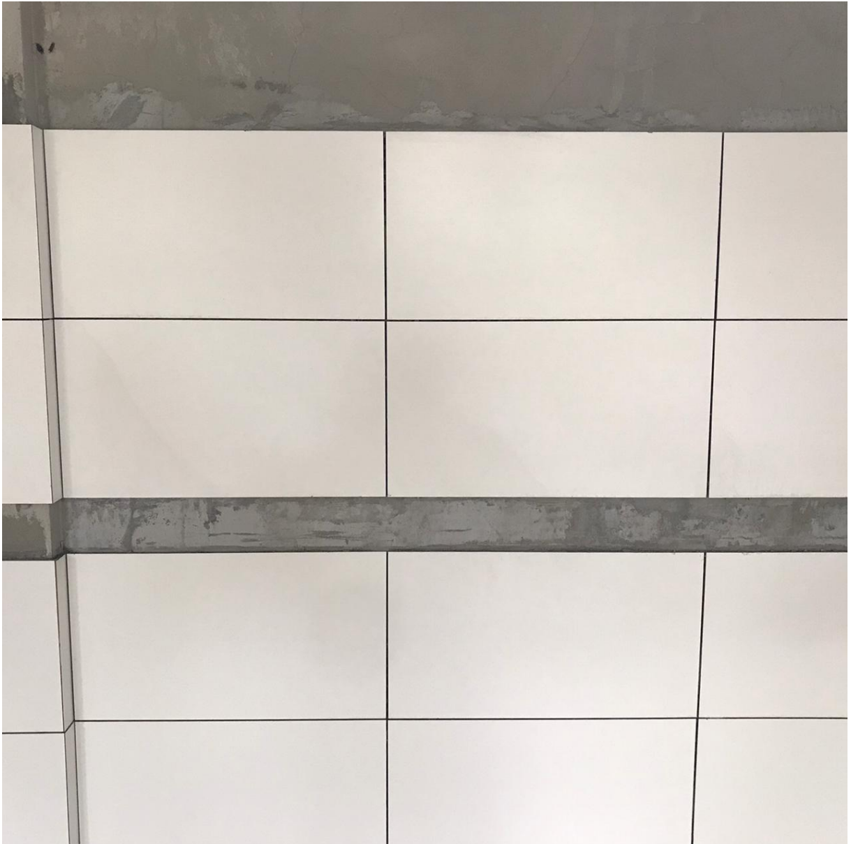
Figura 18: Revestimento cerâmico bem assentado. (Fonte: Dos Autores 2021).
