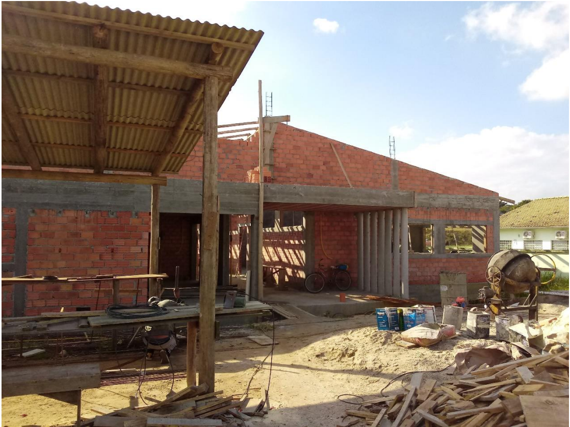
Figura 5: Fachada frontal da obra (fonte: dos autores 2021).
