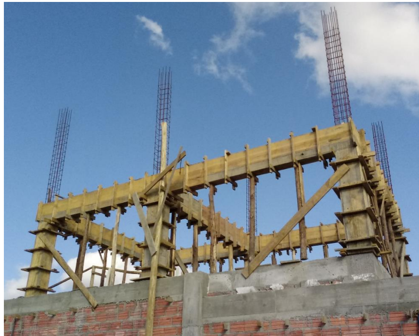
Figura 11: Estrutura da caixa d'água (fonte: dos autores 2021).
