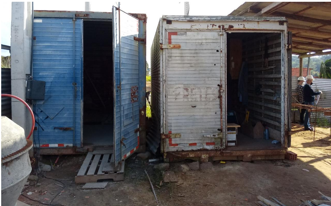
Figura 8: Barracão feito em inconformidade com o Memorial Descritivo (Fonte: dos autores 2021).
